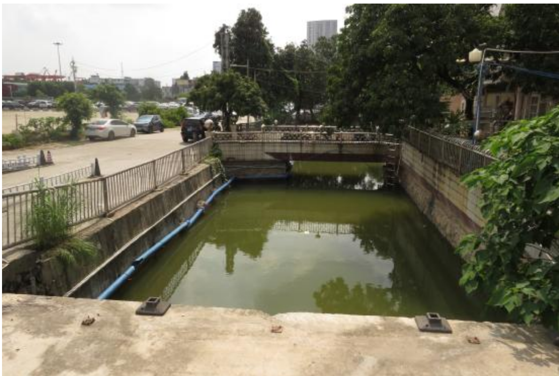
图 9 地块中部乌涌现状（东-西）
