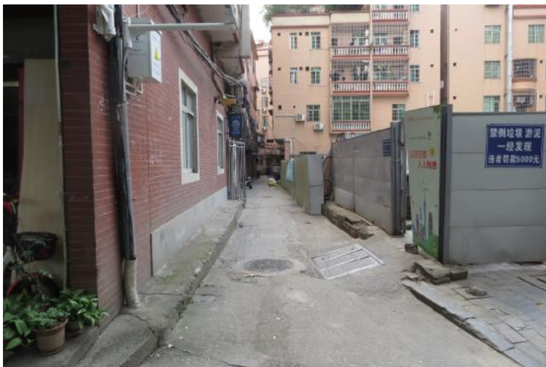
图 20 地块内现状（东-西）
