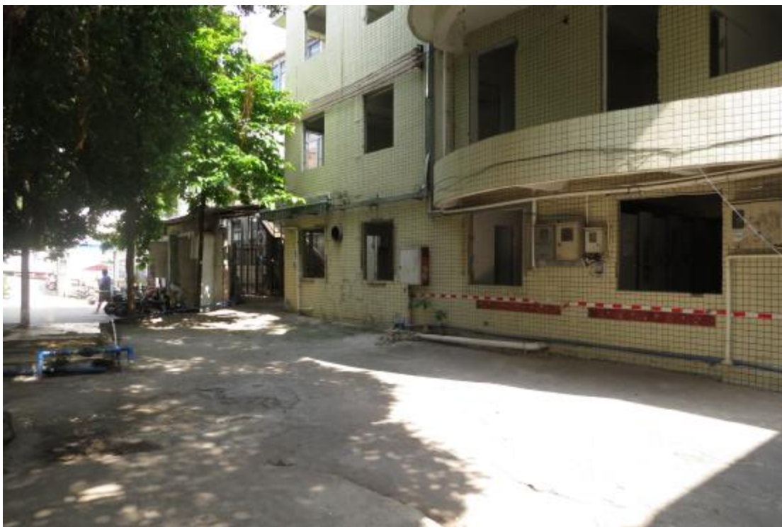
图 24 地块内现状（西北-东南）
