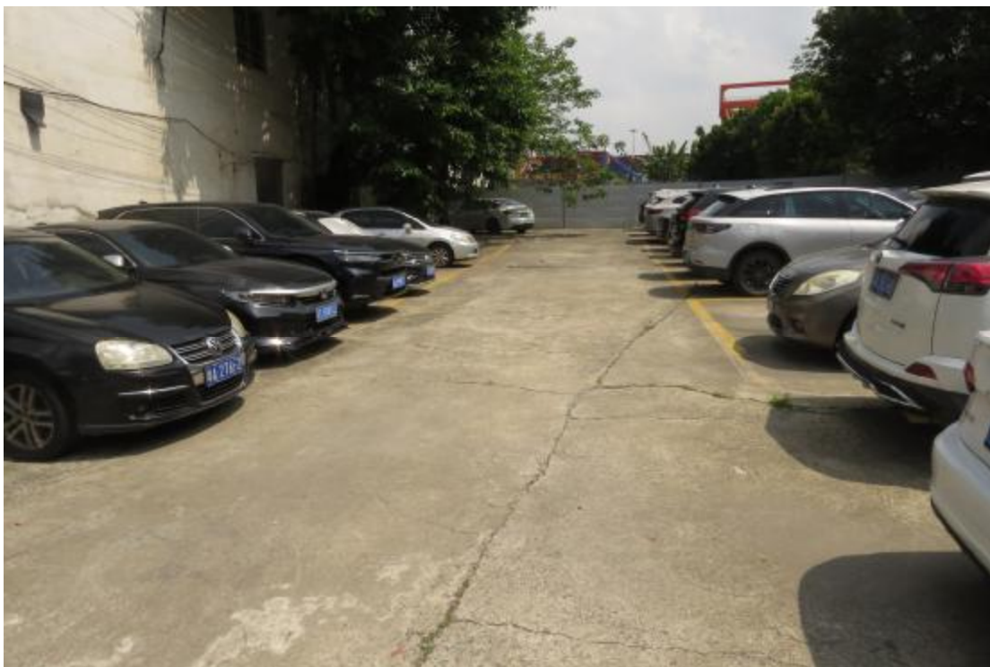
图 10 地块内现状（北-南）
