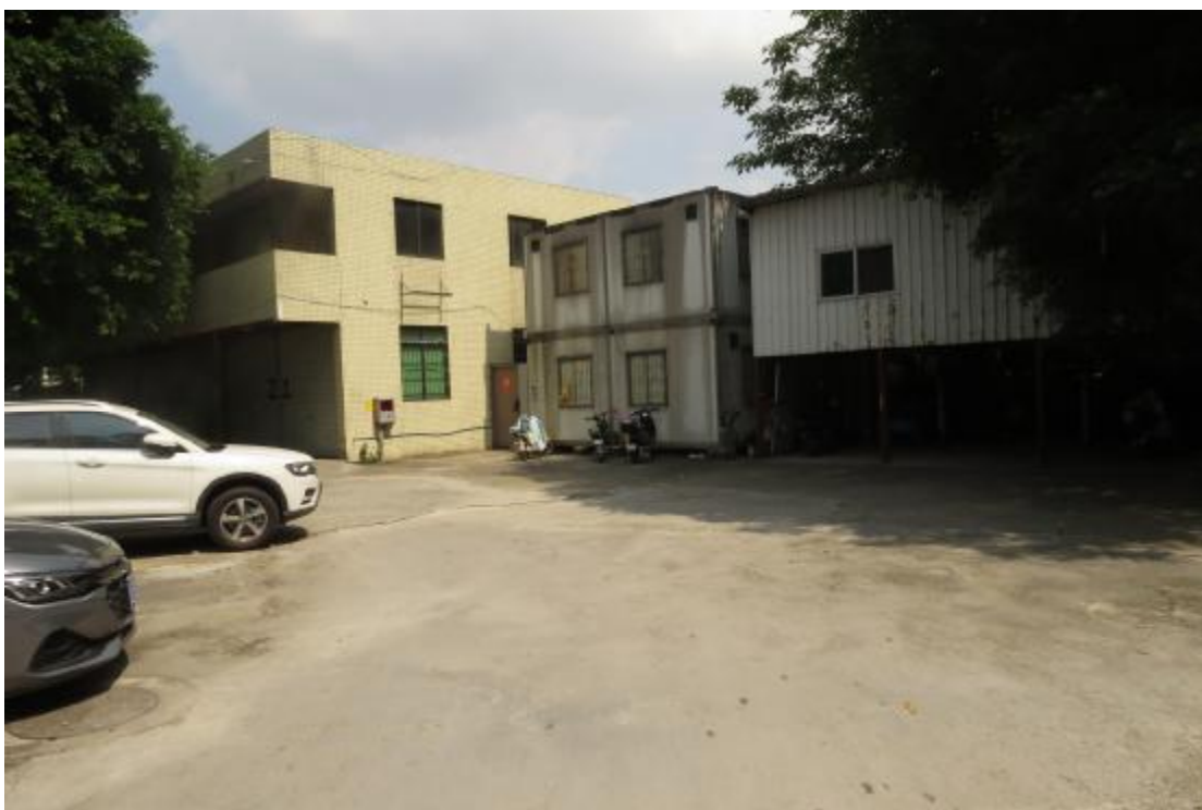
图 23 地块内现状（西北-东南）
