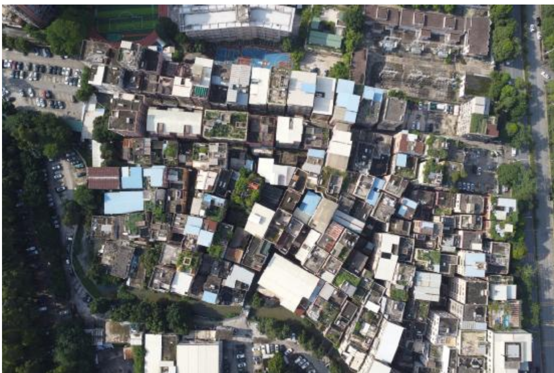
图 7 地块北部航拍现状（上北-下南）
