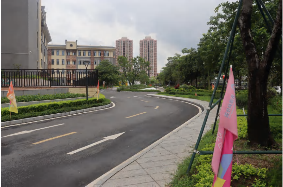
图 19 地块内中部现状（北-南）
