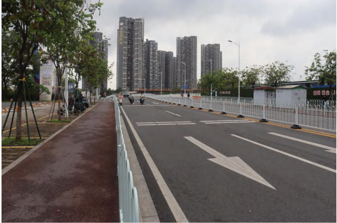
图 23 地块内中部现状（东-西）
