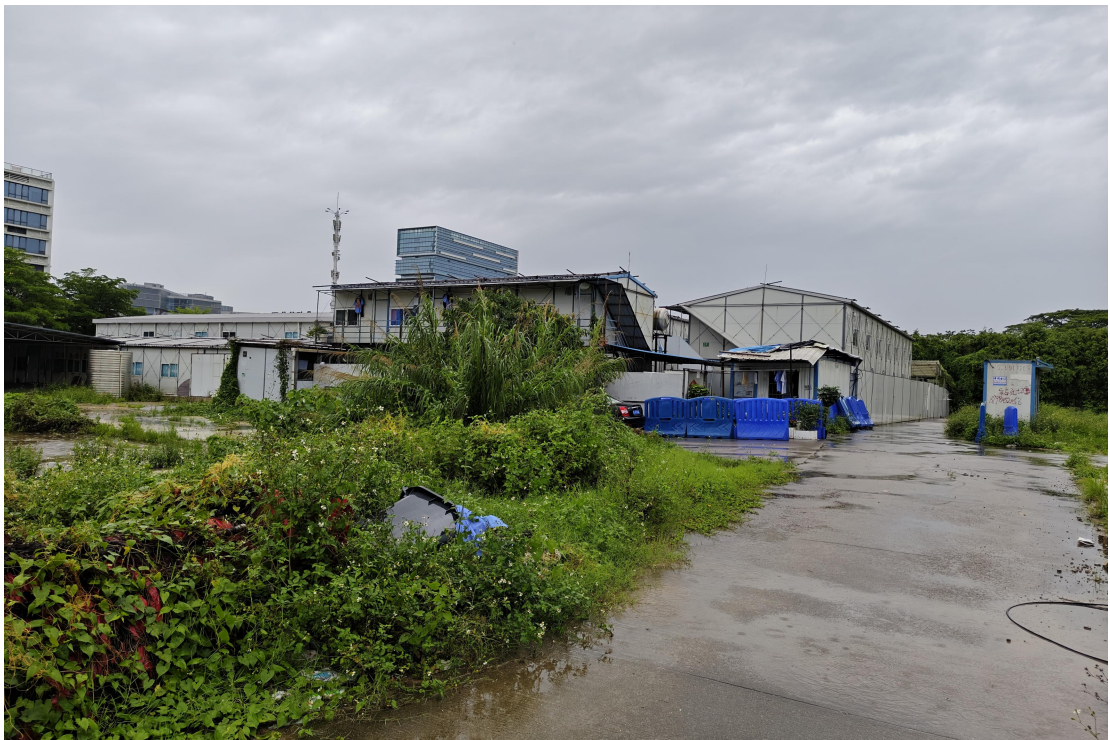
地块西南部现状（东北-西南）
