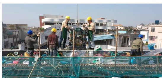
图 27、28 吊装屋脊中心的瓦脊构件
