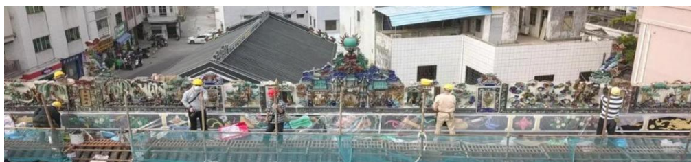
图 29 安装基本完工的妙灵宫第三进陶塑瓦脊
