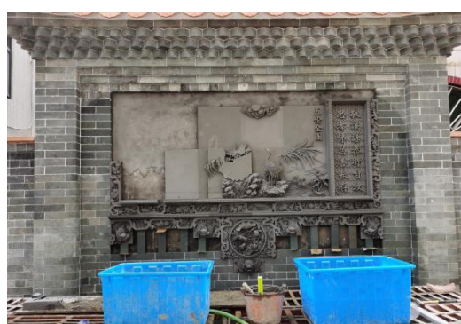
图 27 工地现场与安装 1
