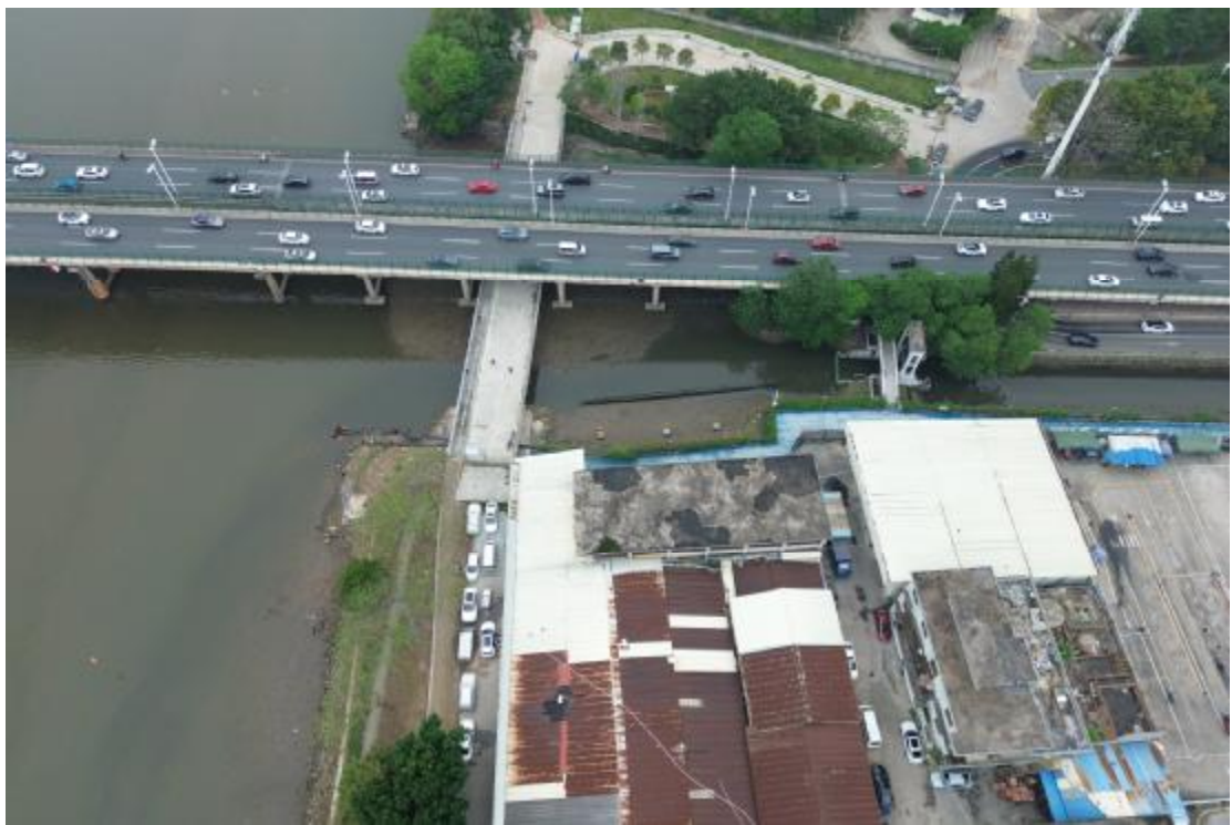
图 10 项目内现状（东北-西南）
