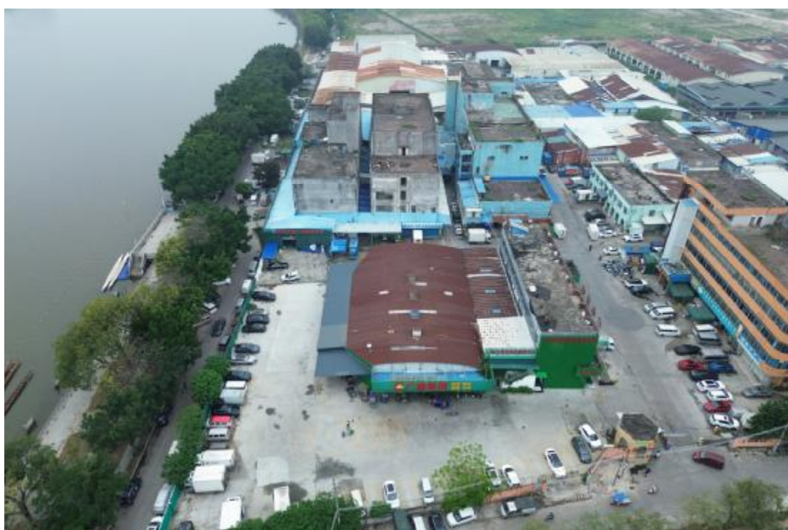
图 9 项目内现状（东-西）
