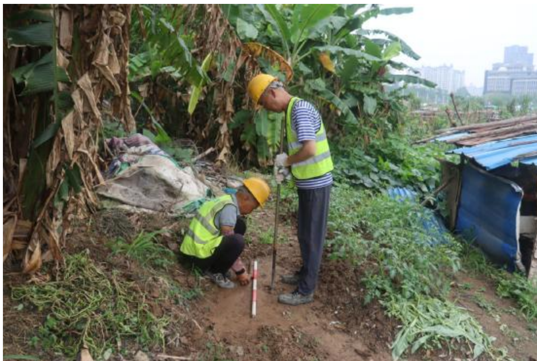
图 26 提取土样（东南-西北）
