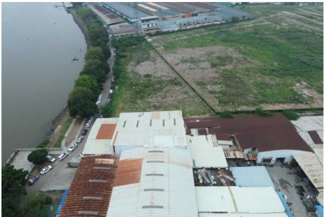
图 16 项目内现状（东-西）
