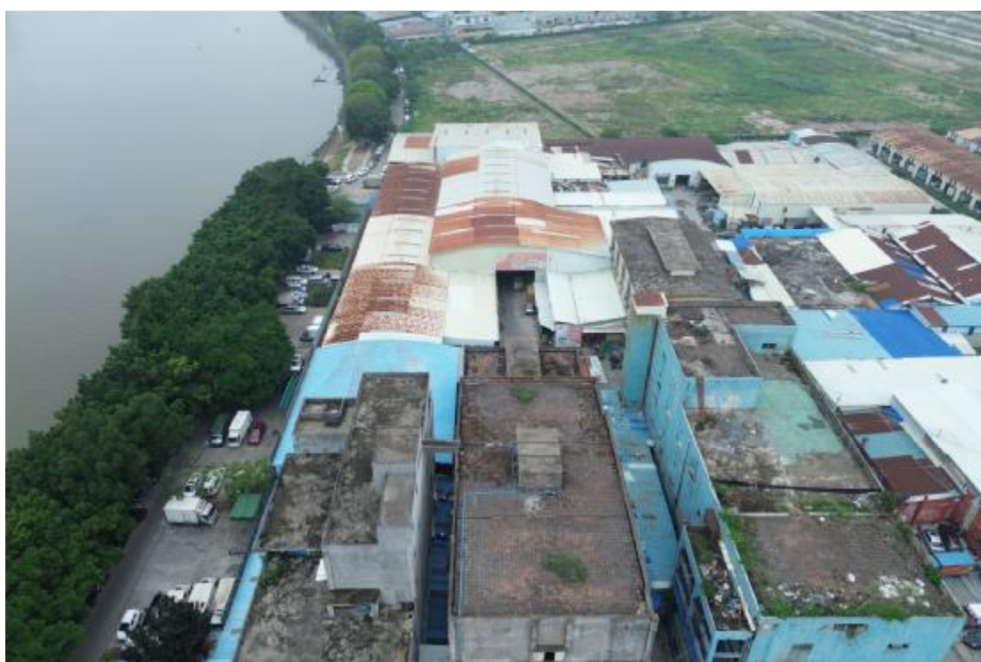
图 15 项目内现状（东-西）
