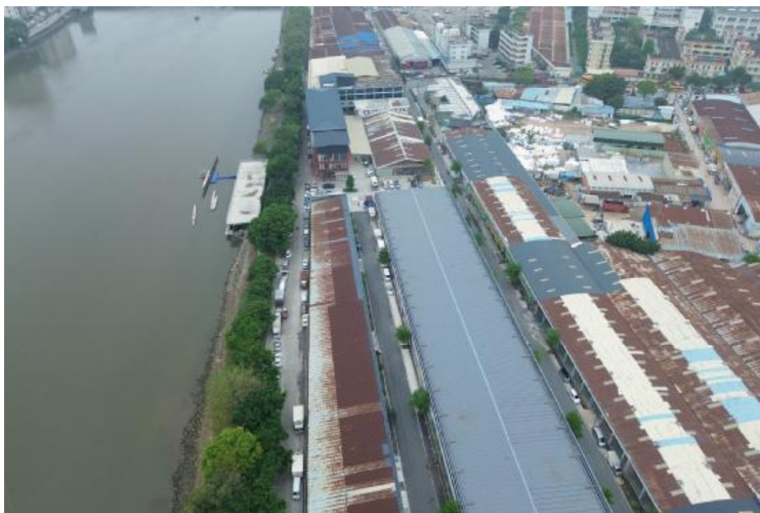
图 12 项目内现状（东北-西南）
