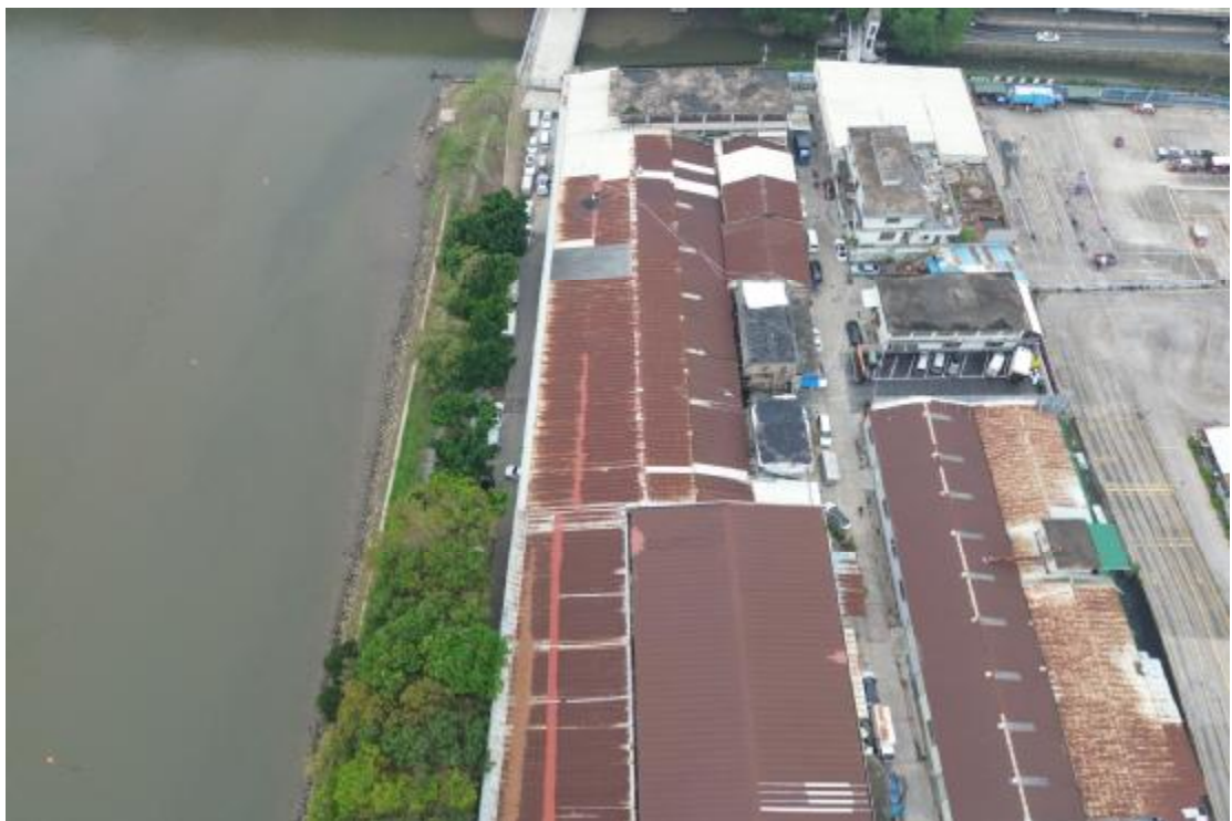
图 11 项目内现状（东北-西南）
