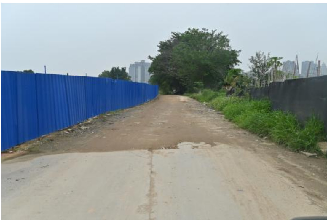
图 19 项目内现状（东南-西北）
