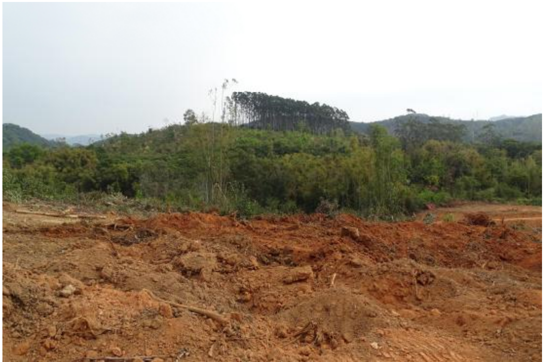
图 21 地块东部地表现状（西-东）
