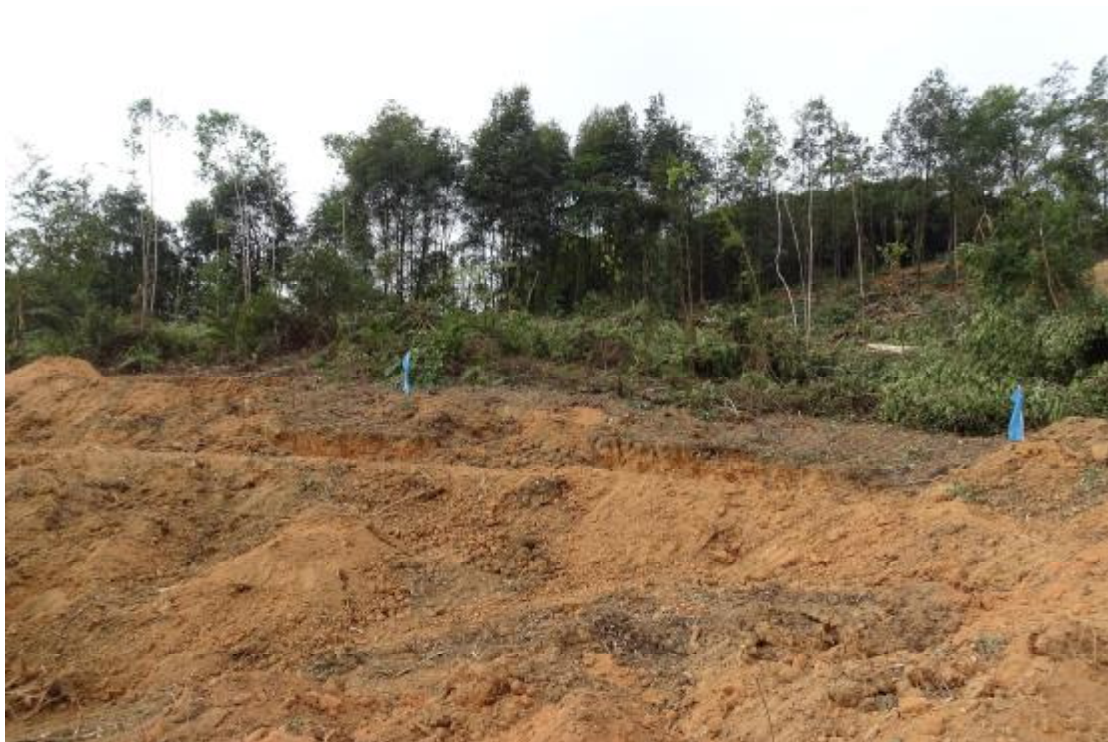
图 22 地块东部地表现状（东-西）
