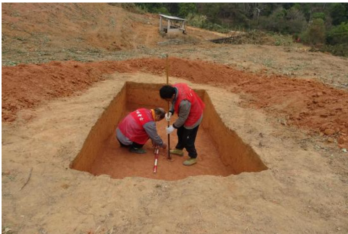
图 108 探沟底部土样提取（南-北）
