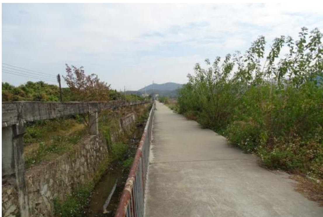
图 27 地块地表现状（西-东）
