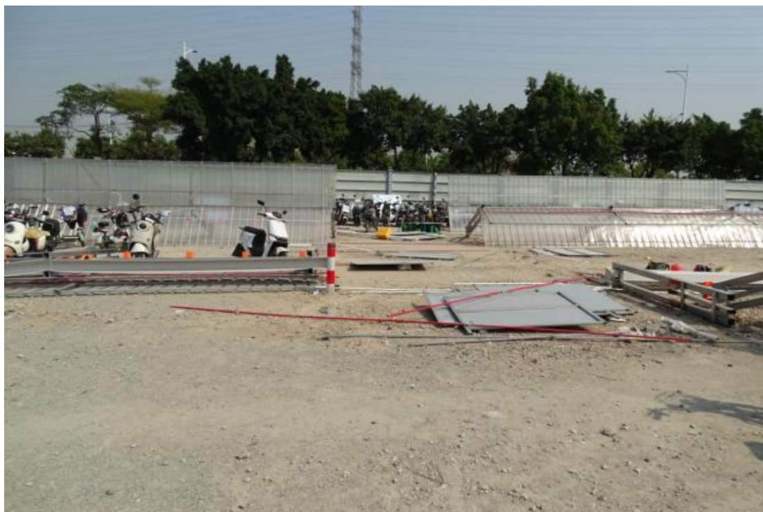
图 20 东部地块地表现状（南-北）
