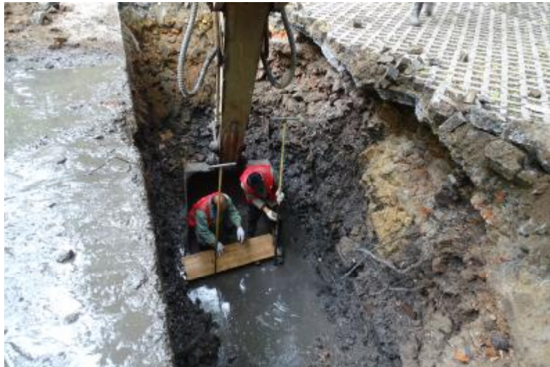
图 31 标准孔土样提取（南-北）
