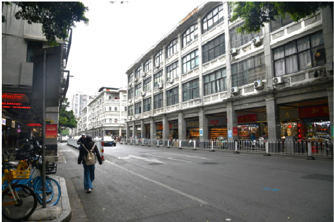
图 26 地块外北部地表现状（东南-西北）
