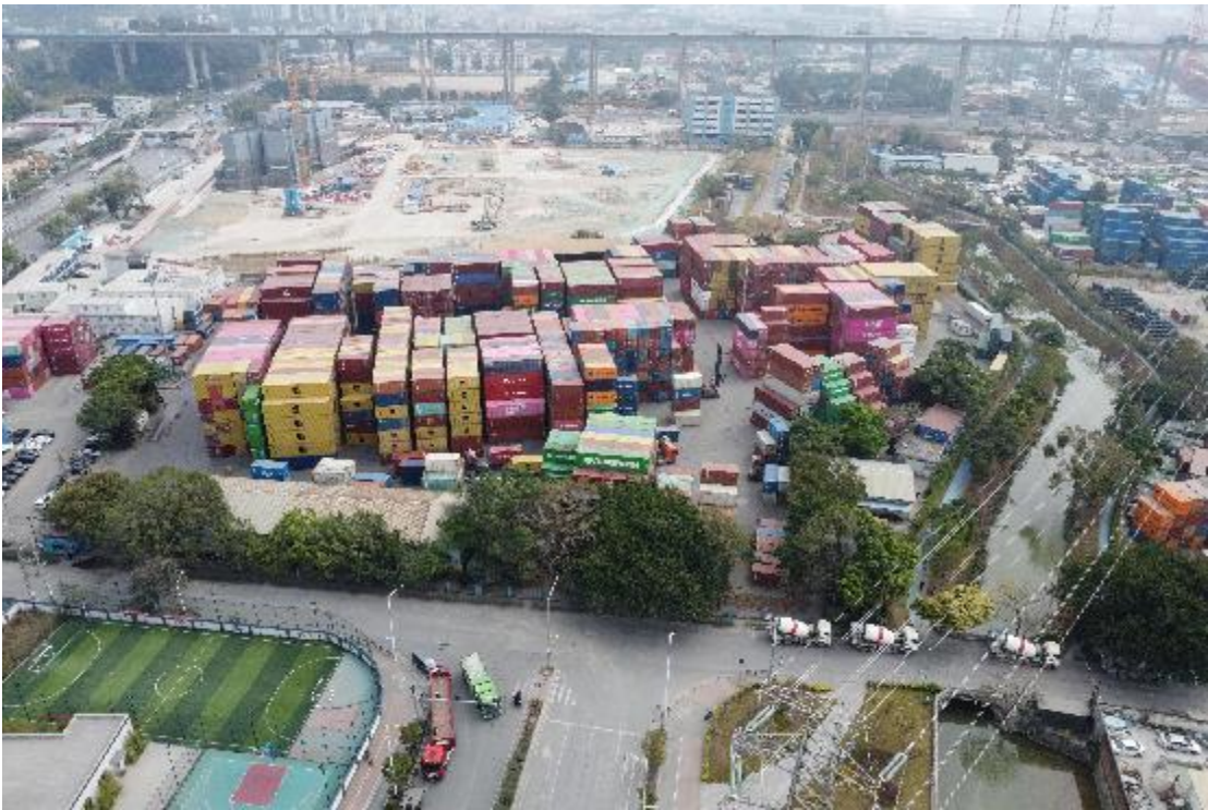
图 7 地块全景航拍（西北-东南）
