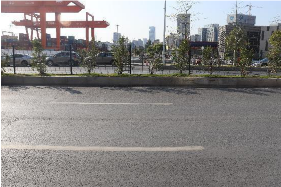
图 20 裕丰围站周边道路现状（西-东）
