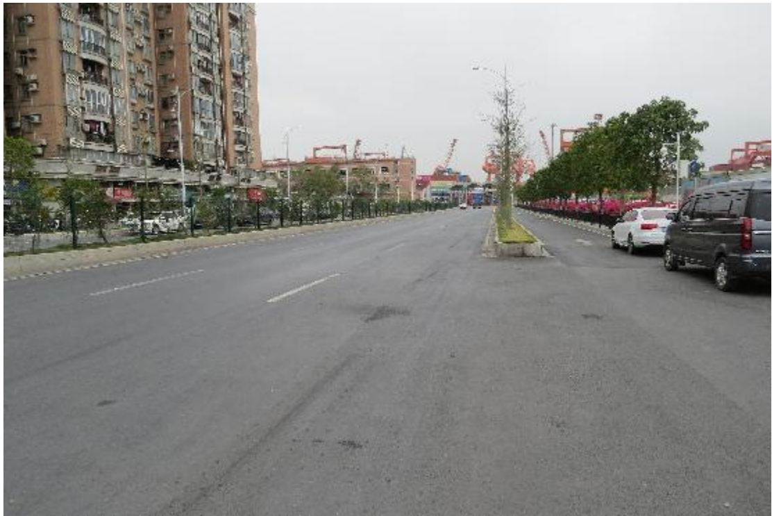
图 25 裕丰围站周边道路现状（北-南）
