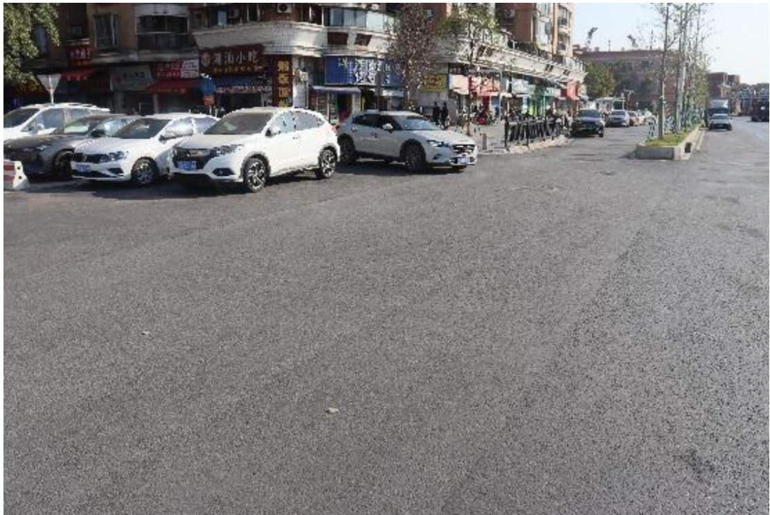
图 23 裕丰围站周边道路现状（北-南）
