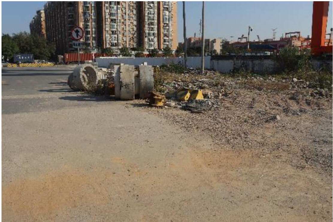
图 31 裕丰围站周边道路现状（西北-东南）
