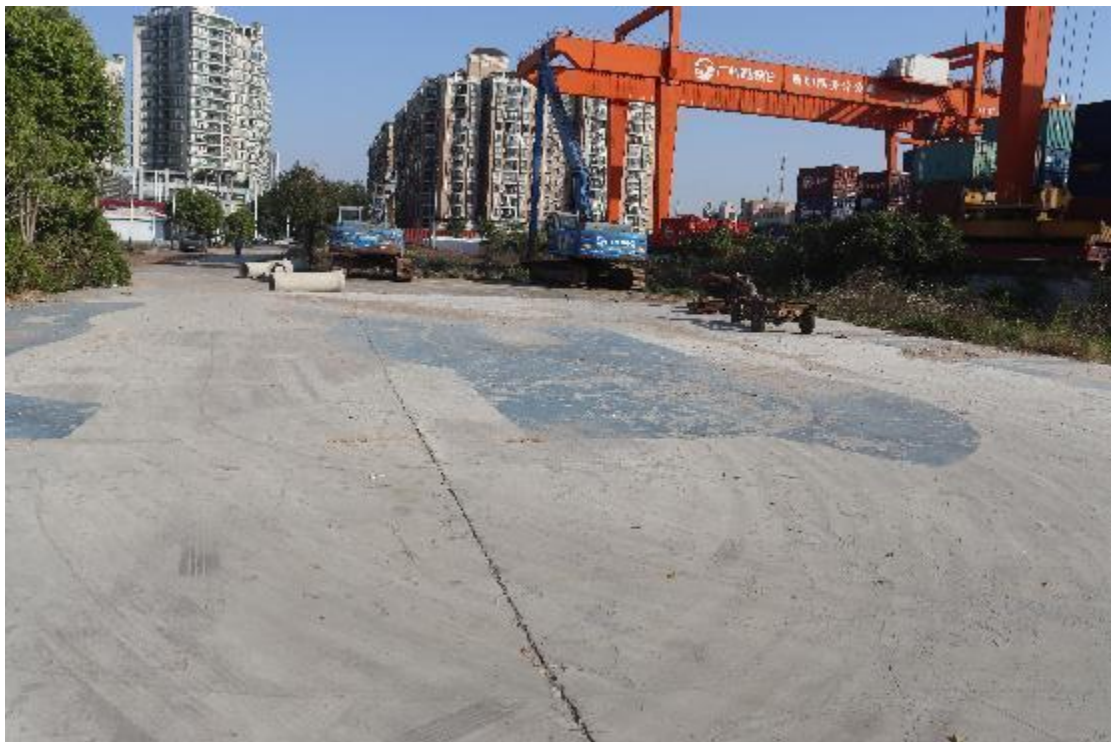
图 21 裕丰围站周边道路现状（西-东）
