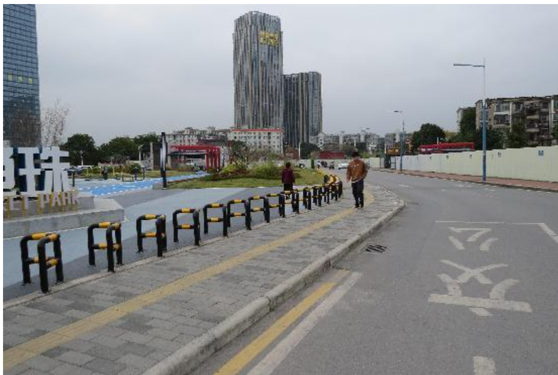
图 12 鱼珠站周边道路现状（北-南）
