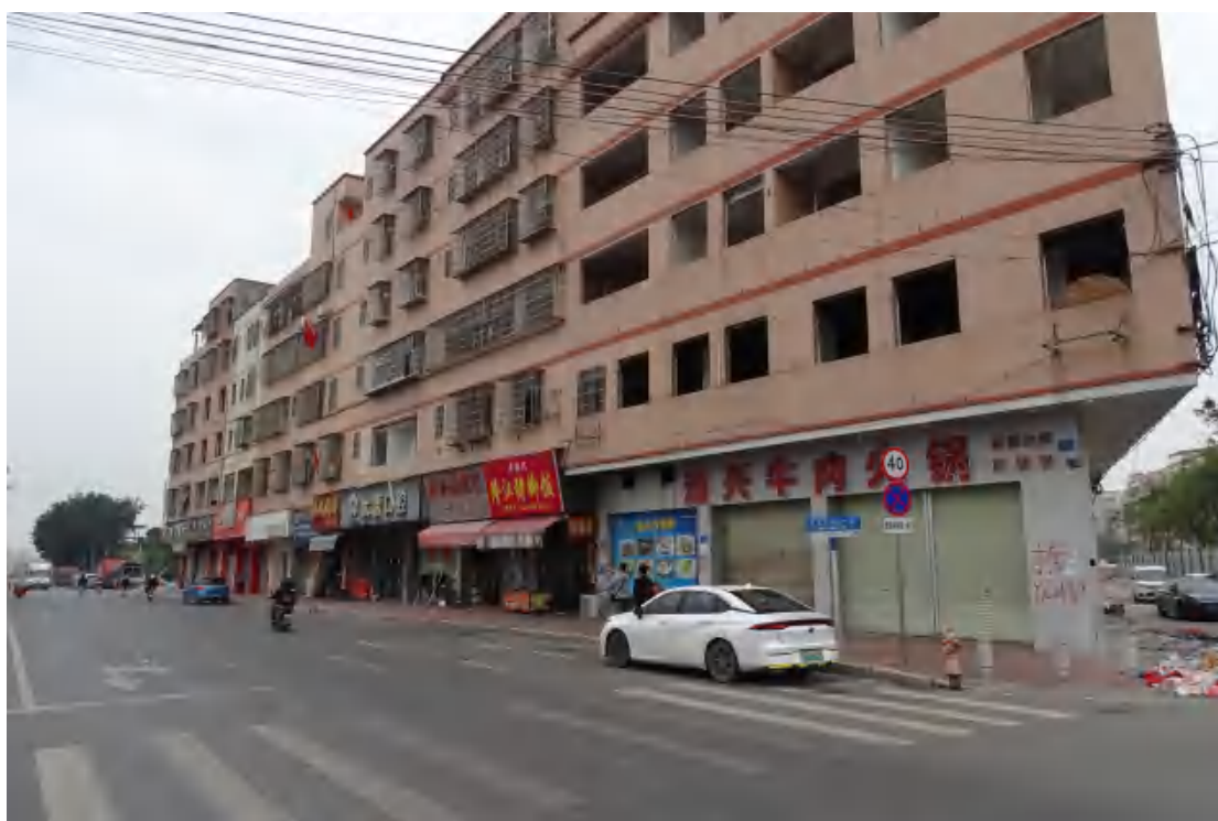
图 29 北部地块地表现状（东-西）
