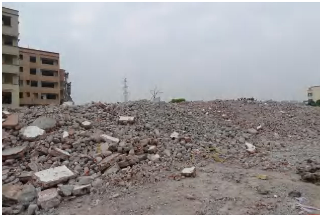
图 30 北部地块地表现状（东-西）
