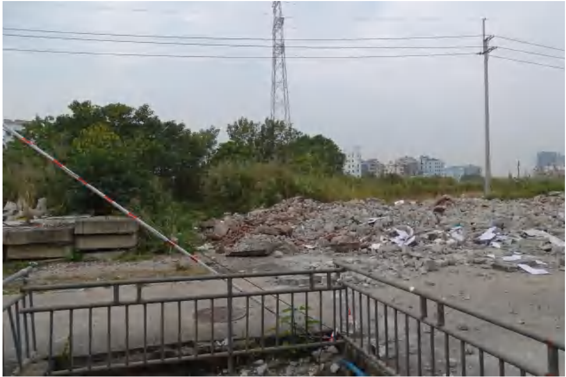
图 33 南部地块地表现状（北-南）
