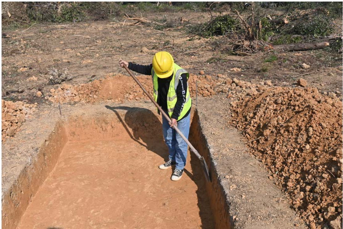
图 53 修整探沟壁（西-东）
