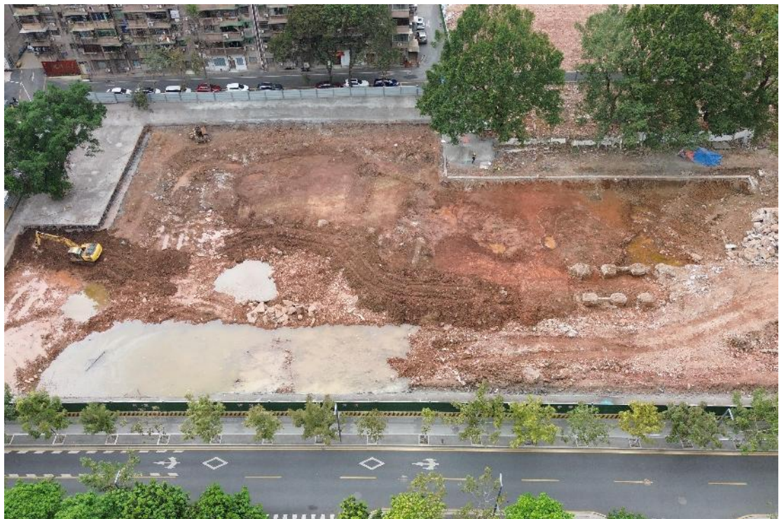
图 28 勘探区域内现状（南-北）
