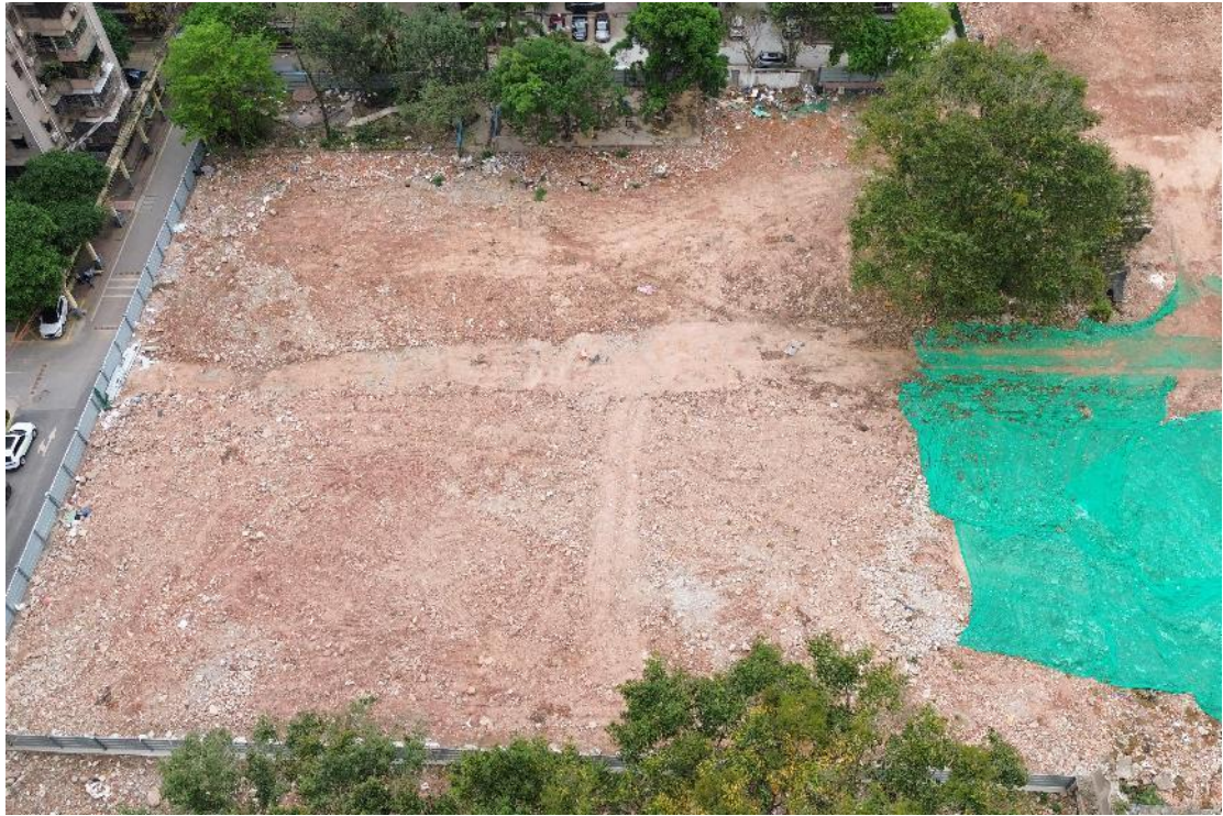
图 27 勘探区域内现状（南-北）
