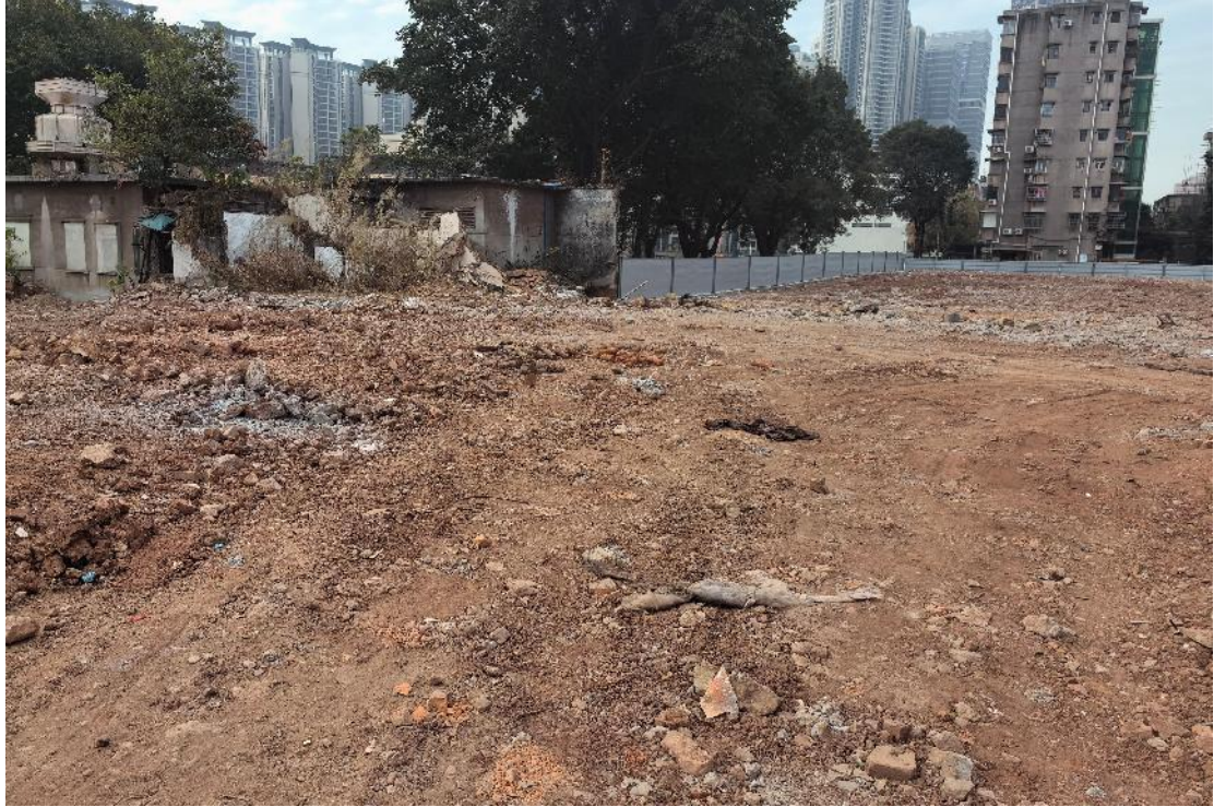
图 18 2024 年 1 月 14 日地块内中部现状（东北-西南）
