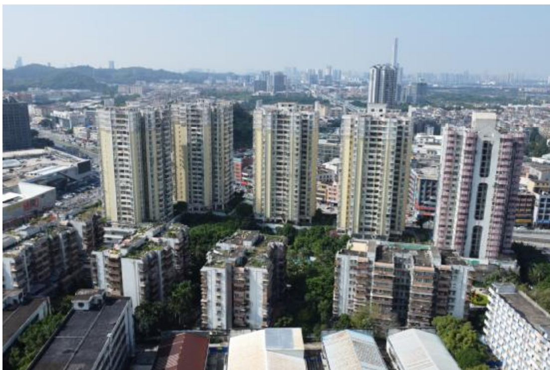
图 12 地块外西部地形地貌（东-西）
