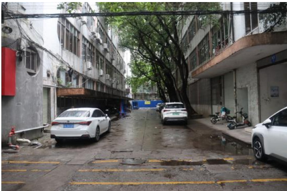
图 20 地块内现状（东-西）
