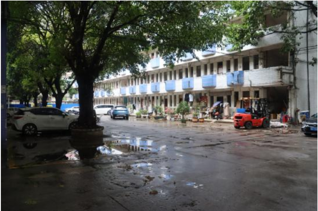
图 16 地块内现状（东南-西北）
