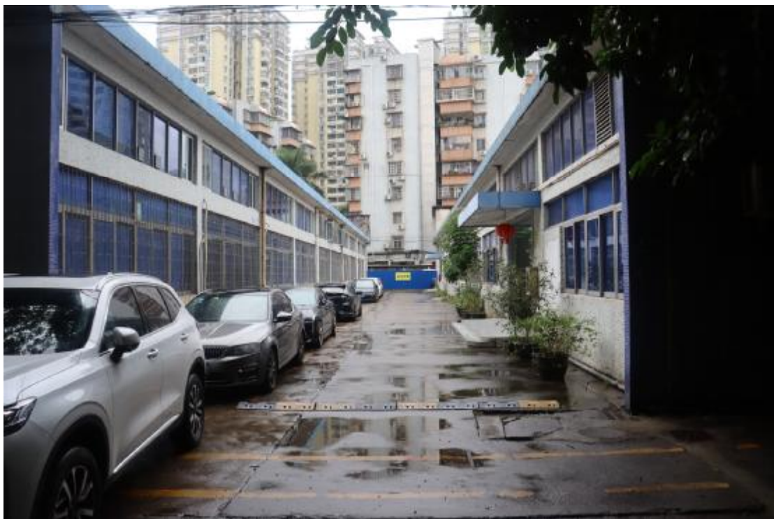
图 19 地块内现状（东-西）
