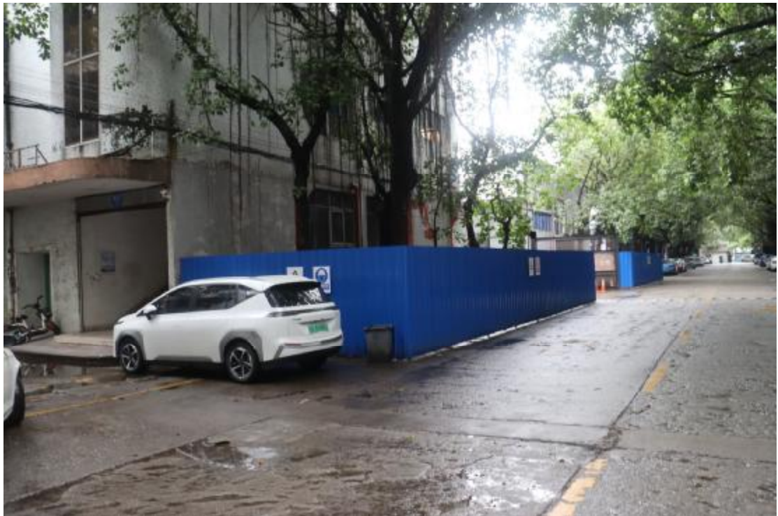
图 18 地块内现状（东南-西北）
