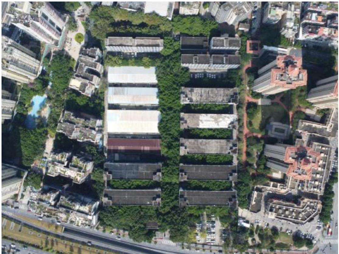
图 8 地块内全景航拍现状（上北-下南）
