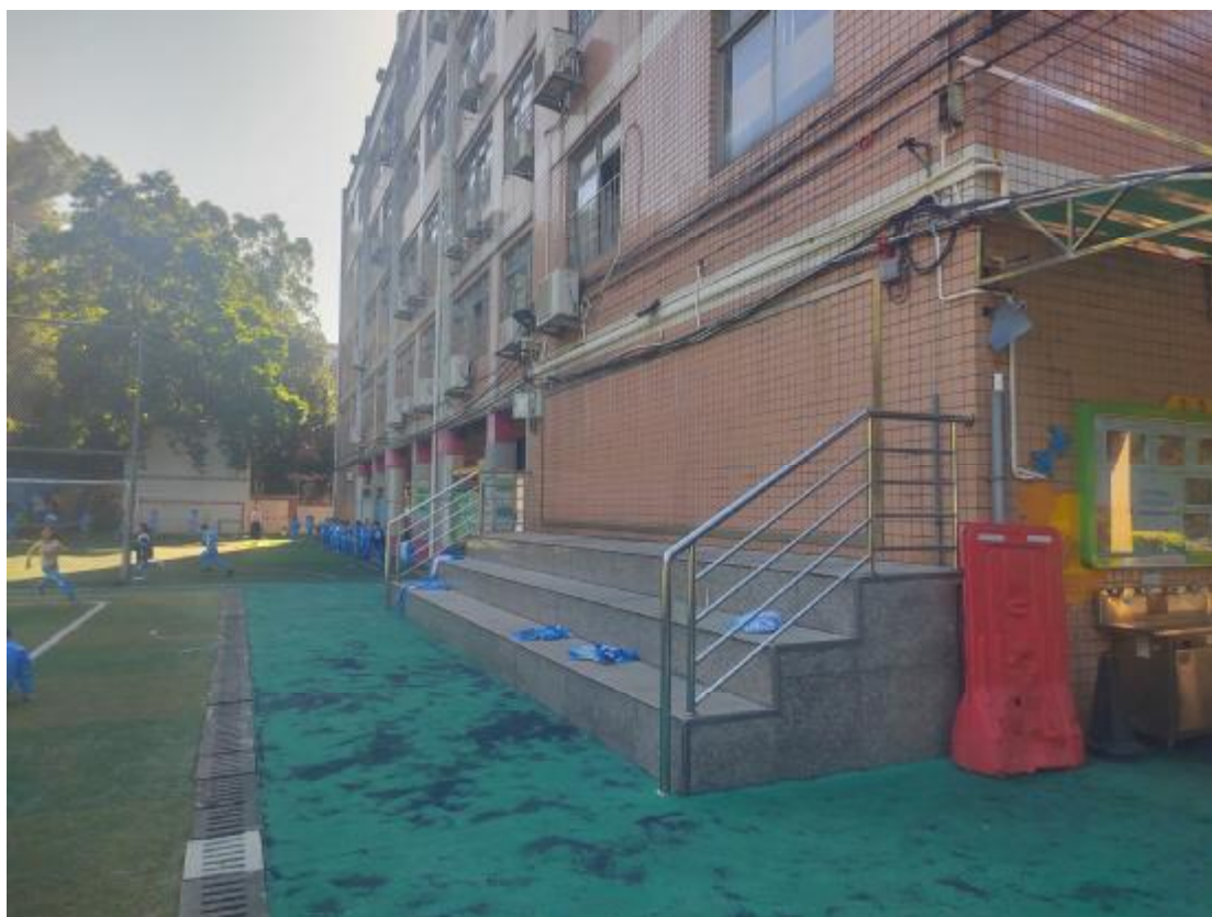
图 12 地块东部地表现状（西-东）
