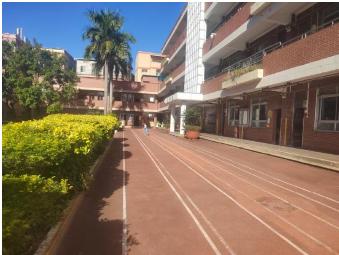
图 20 地块中部地表现状（东-西）
