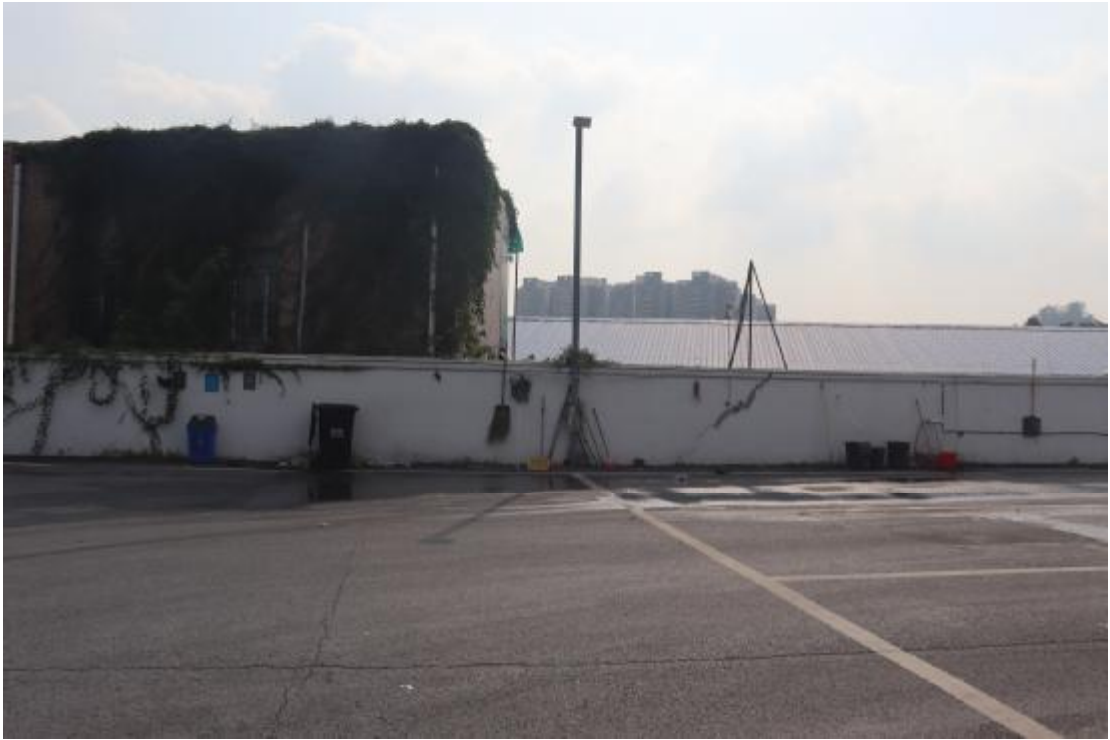
图 24 项目中北部地表现状（西-东）
