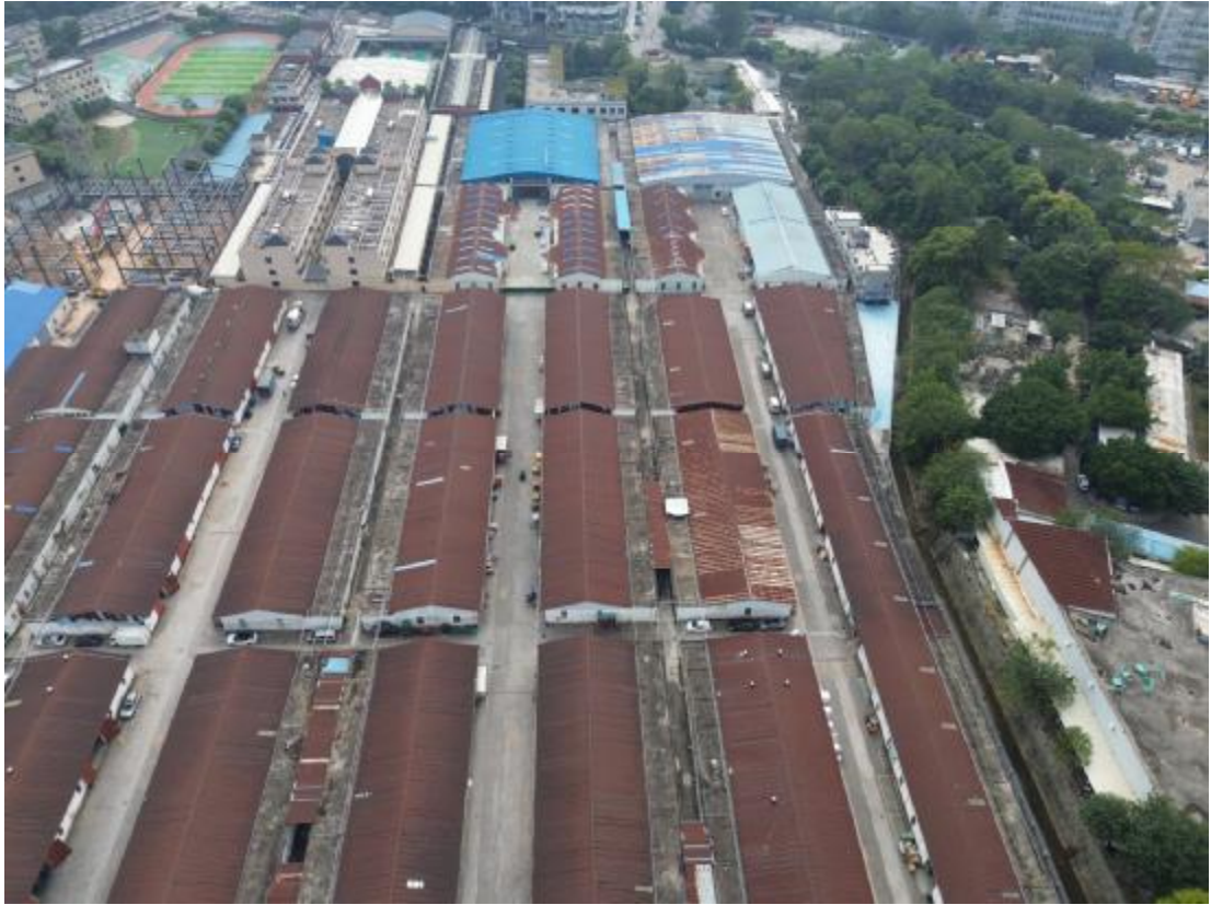
图 16 项目南部地表现状（北-南）
