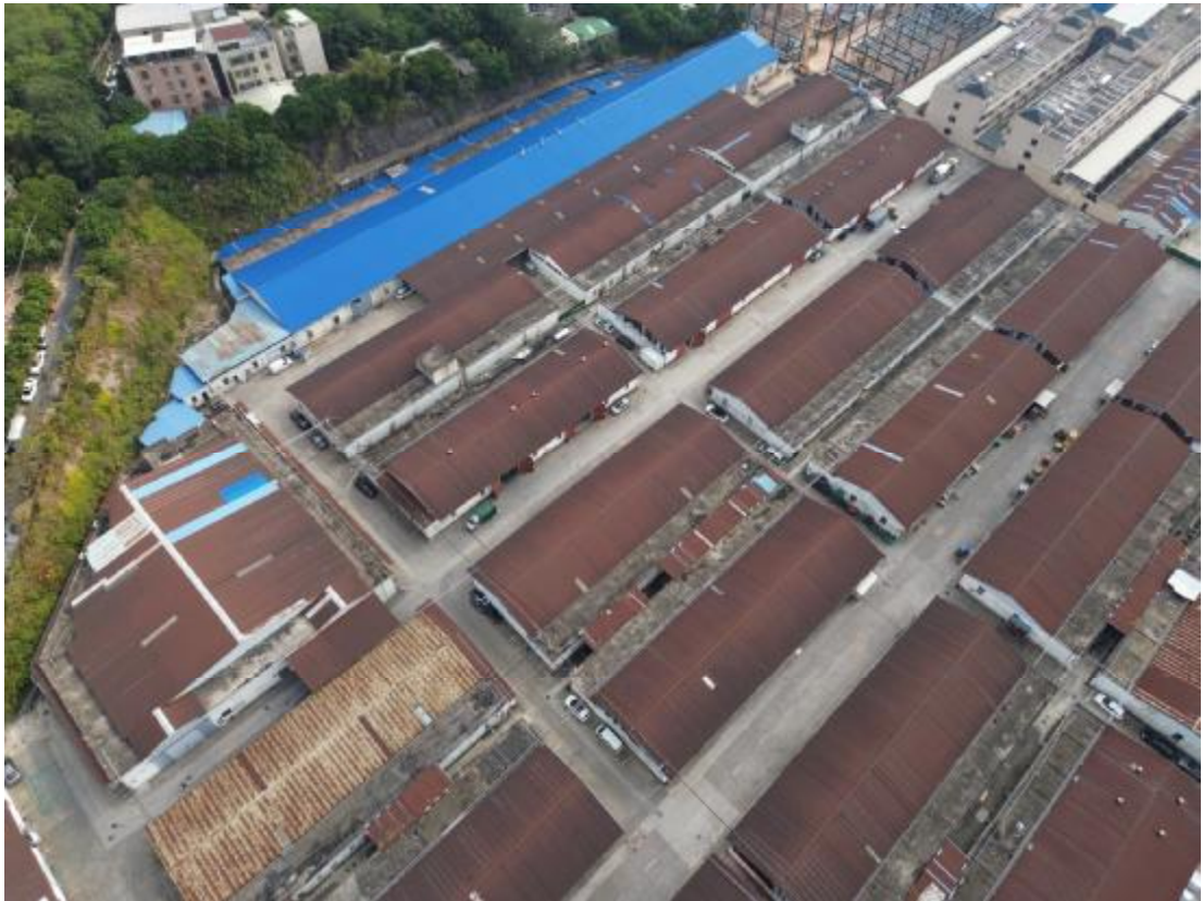
图 15 项目东南部地表现状（西北-东南）
