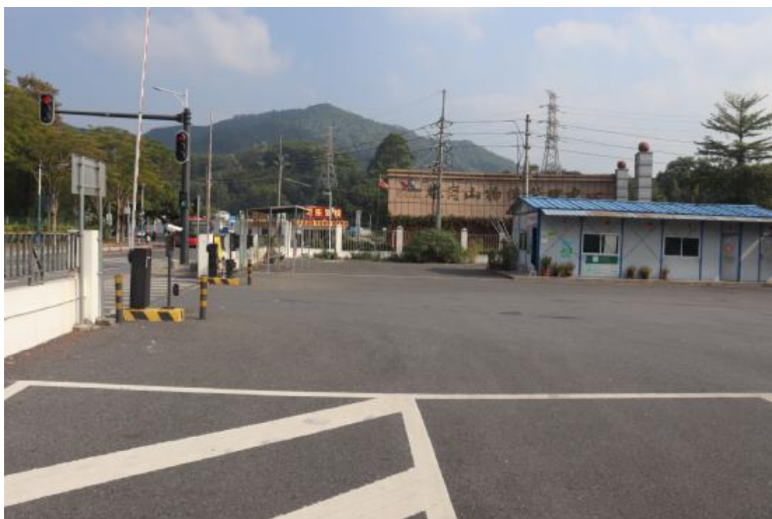
图 18 项目西北部地表现状（南-北）
