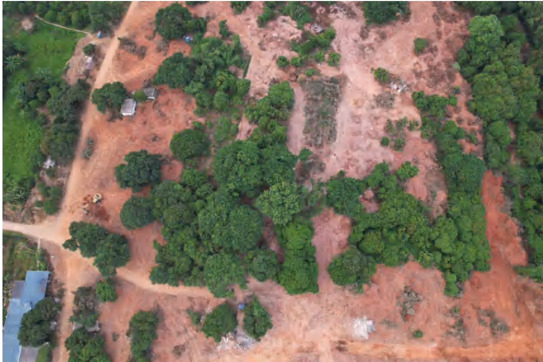
图 36 地块西部勘探区域地表现状（东-西）
