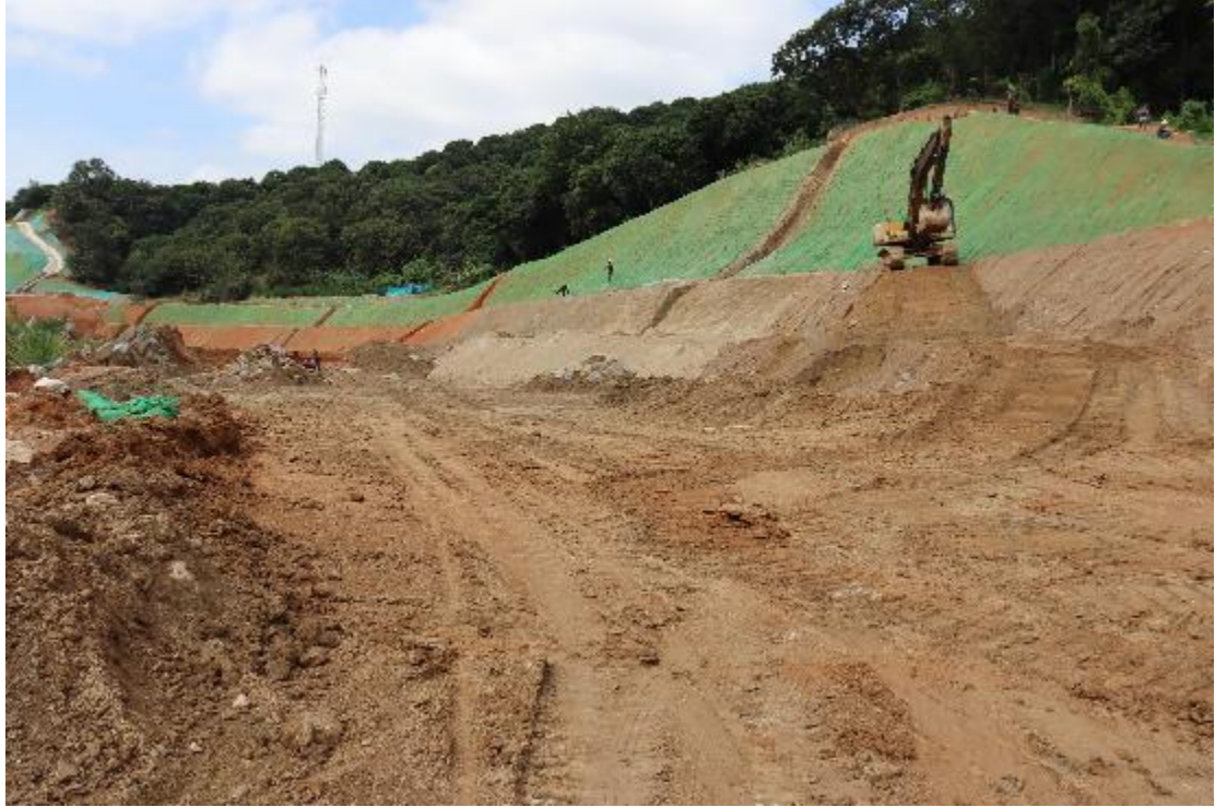
图 8 地块内西北部现状（东北-西南）
