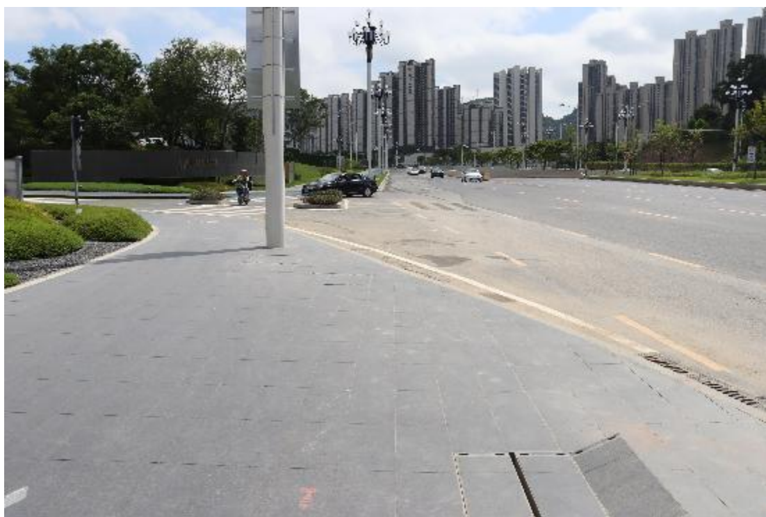
图 15 地块内中部现状（西-东）
