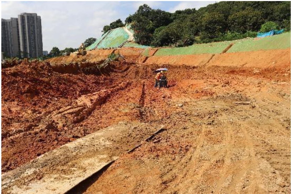
图 7 地块内西北部现状（东北-西南）
