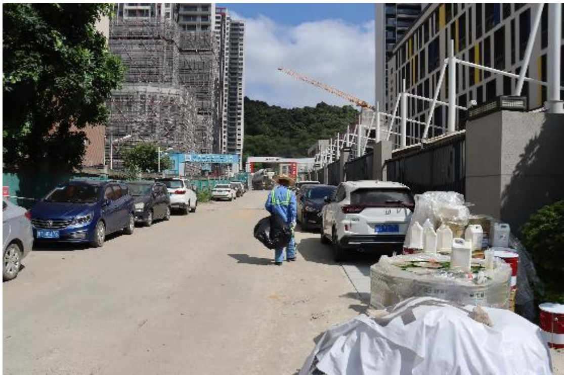
图 13 地块内中部现状（南-北）
