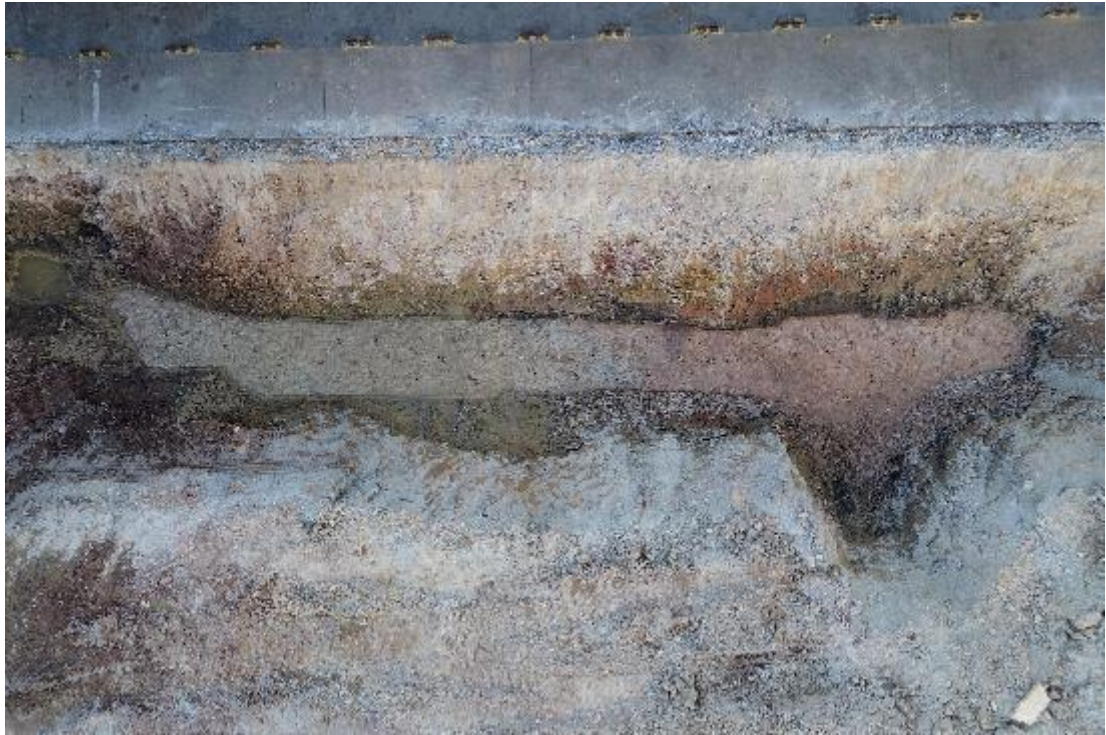
图 62 TG1 完工照（上为西）
