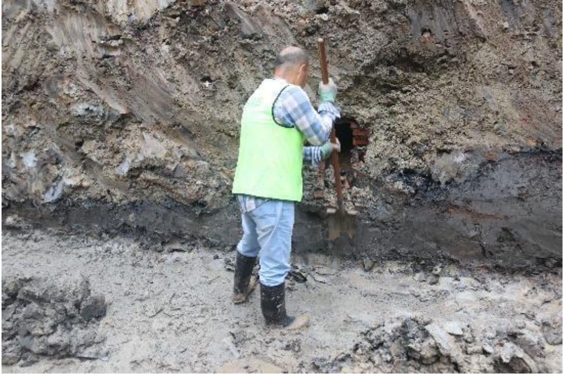
图 59 修壁工作照（东-西）
