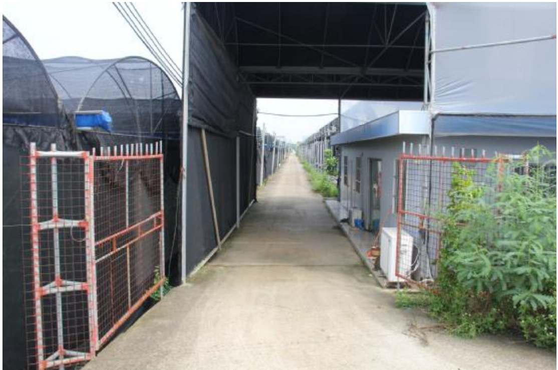
图 28 地块内现状（东-西）
