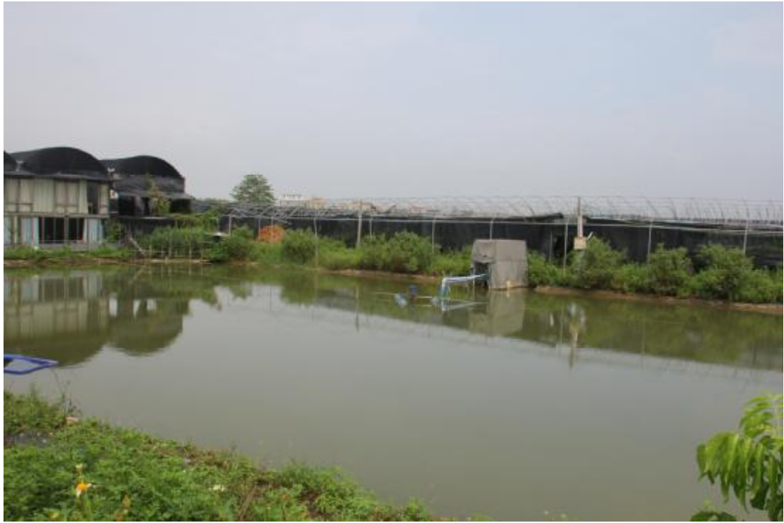
图 11 地块内现状（东南-西北）
