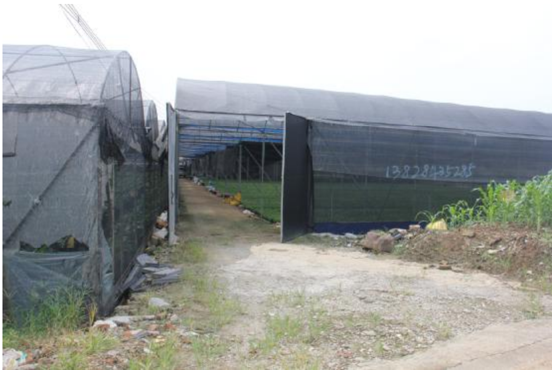
图 19 地块内现状（东南-西北）
