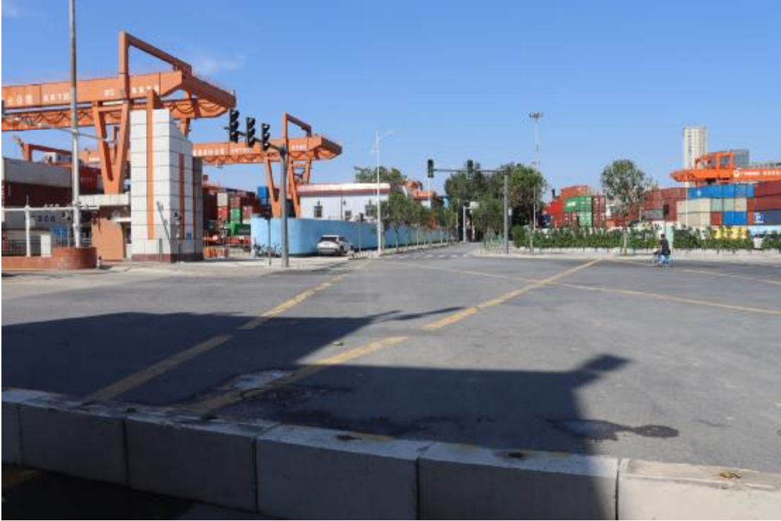
图 10 地块内东部现状（东-西）
