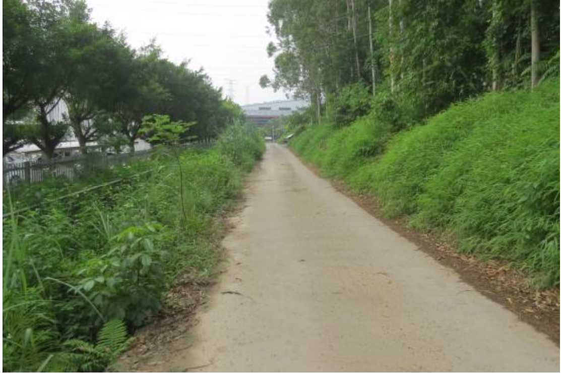
图 12 地块内现状（北-南）
