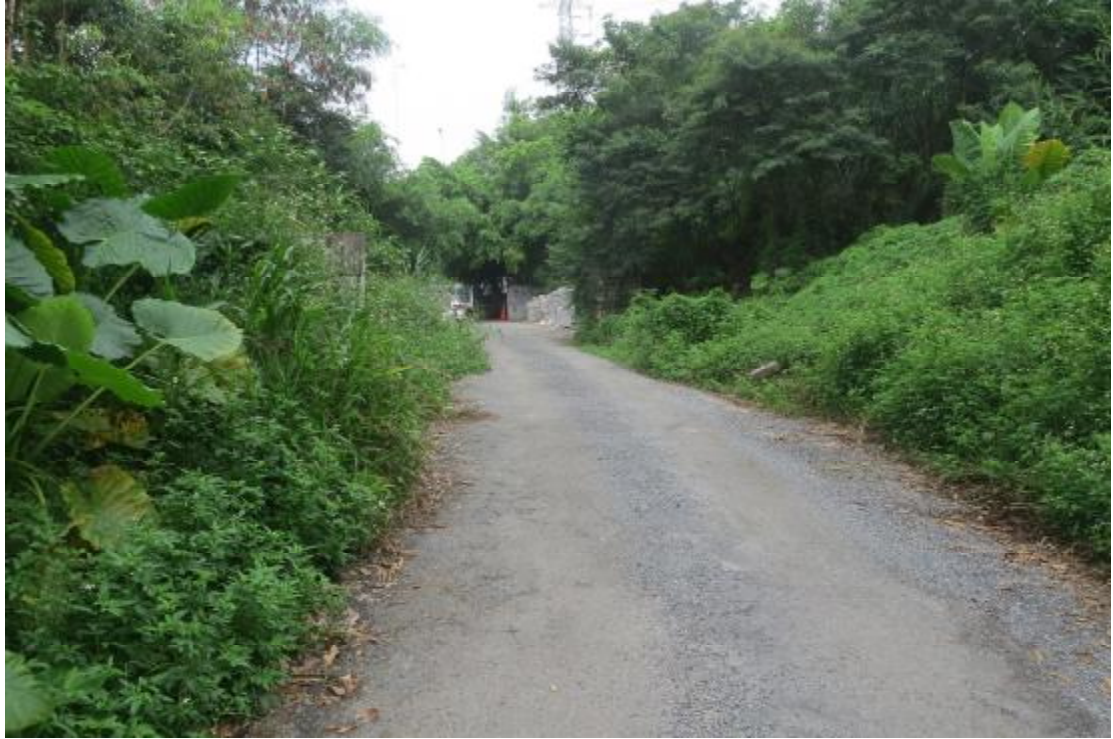
图 14 地块内现状（东-西）
