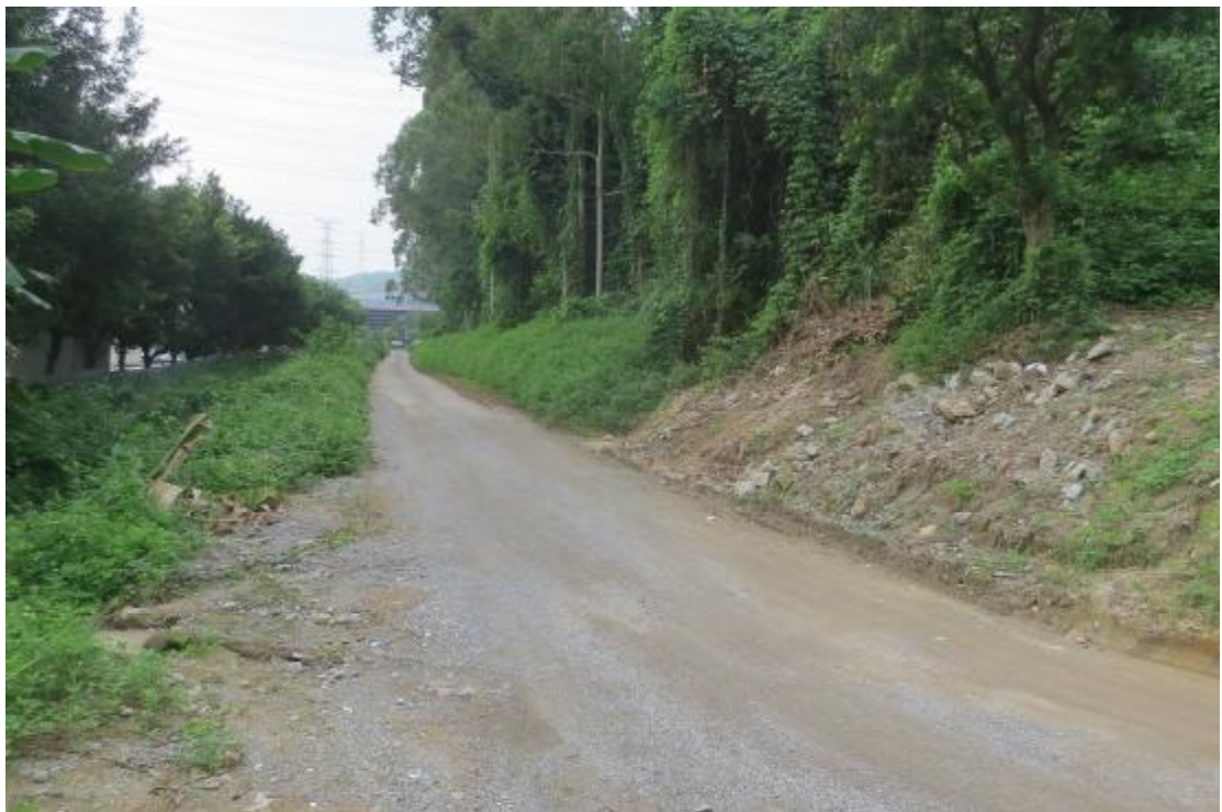
图 11 地块内现状（北-南）
