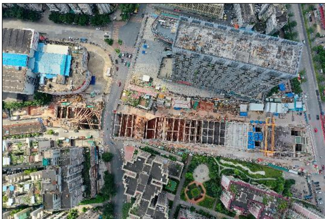
图 38 江泰路站航拍图
