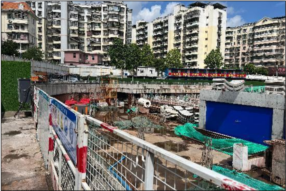
图 28 梓元岗站内部现状（西-东）
