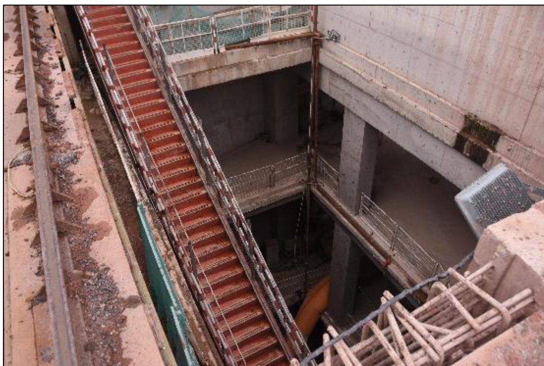
图 41 江泰路站内部现状（东南-西北）
