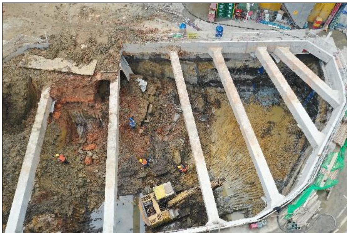
图 37 勘探区域清障后现状（东-西）
