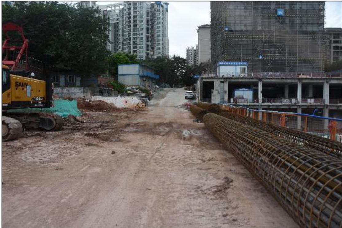
图 36 燕岗站内部现状（南-北）
