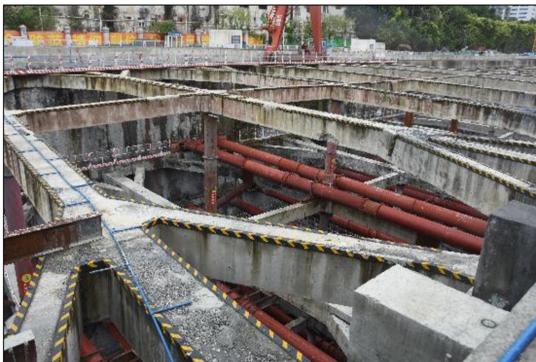
图 24 广园新村站内部现状（西南-东北）
