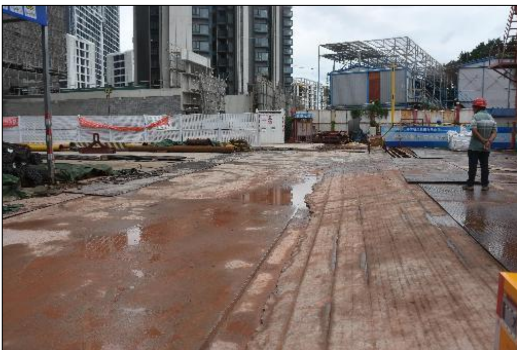
图 31 南石路站内部现状（北-南）
