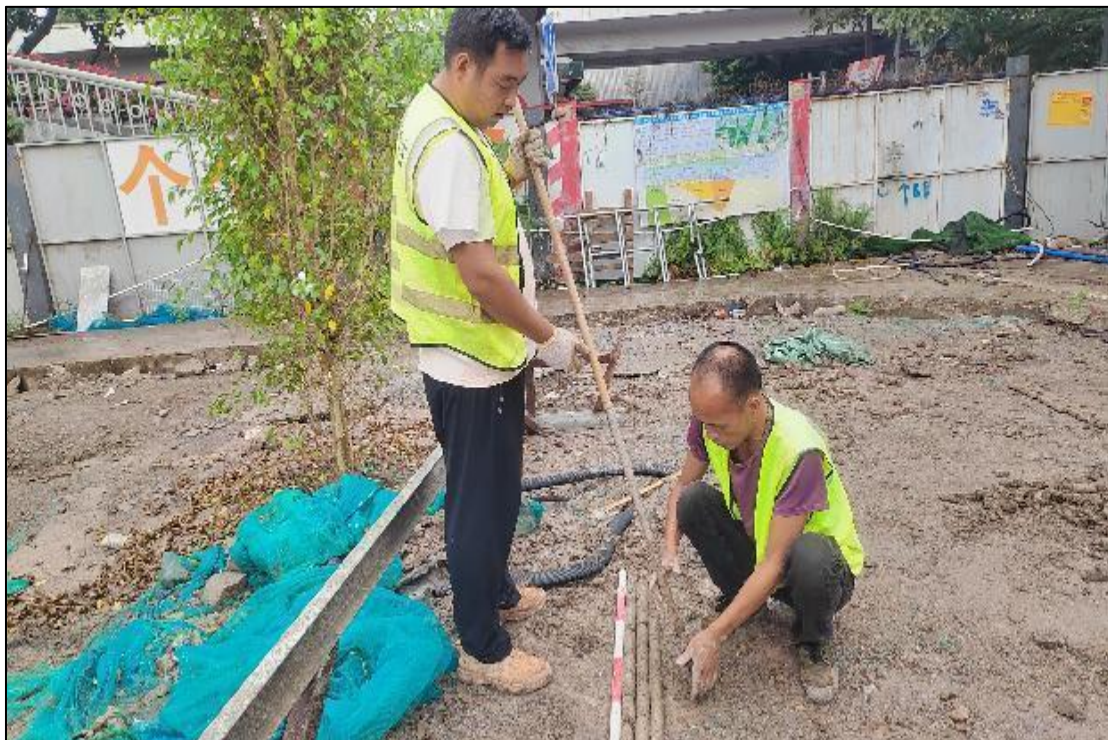
图 52 提取标准孔土样工作照（南-北）
