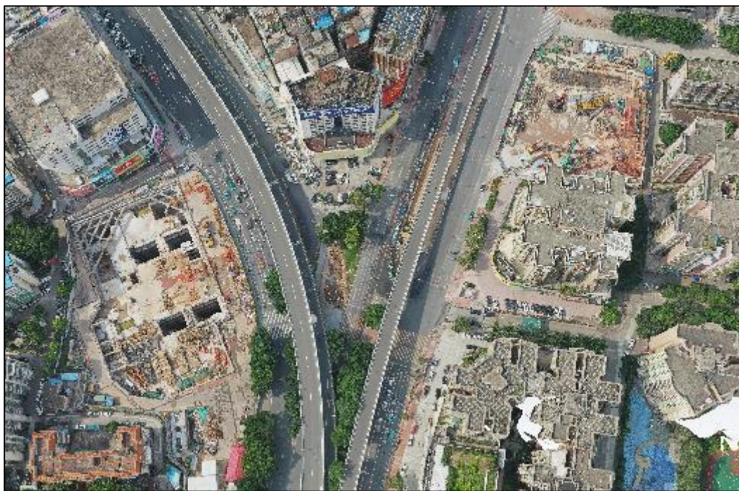
图 26 梓元岗站航拍图
