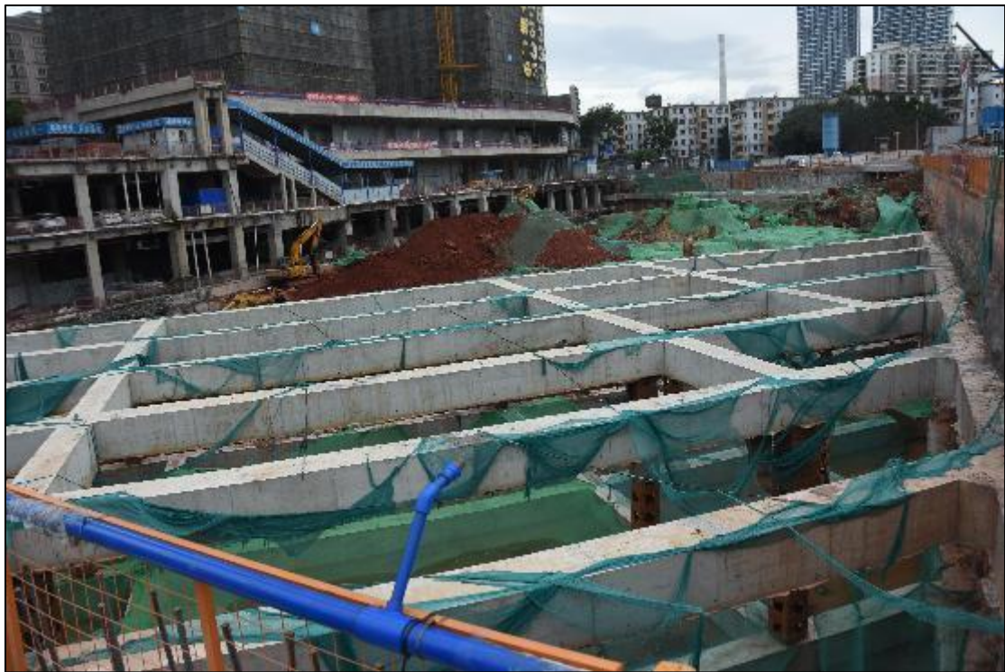
图 37 燕岗站内部现状（西南-东北）
