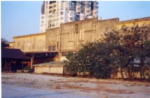
图 9 大阪仓旧址仓库外貌
