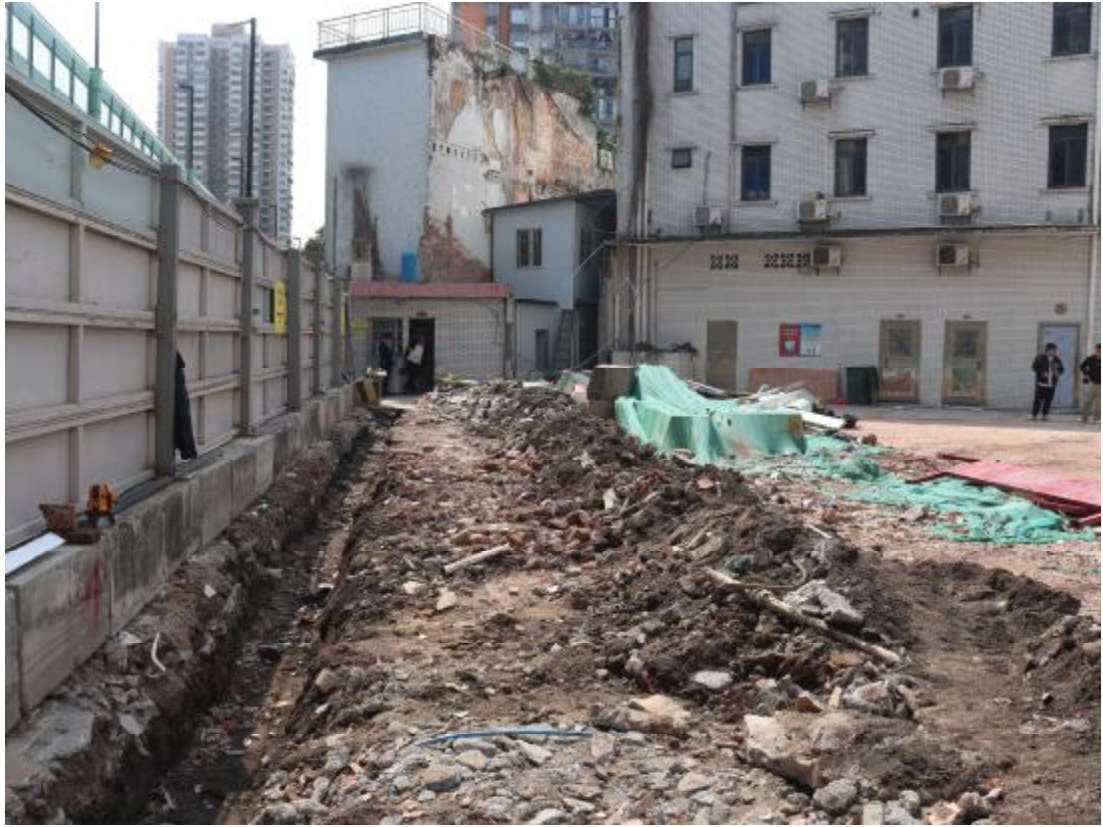
图 16 地块中部现状（西北-东南）
