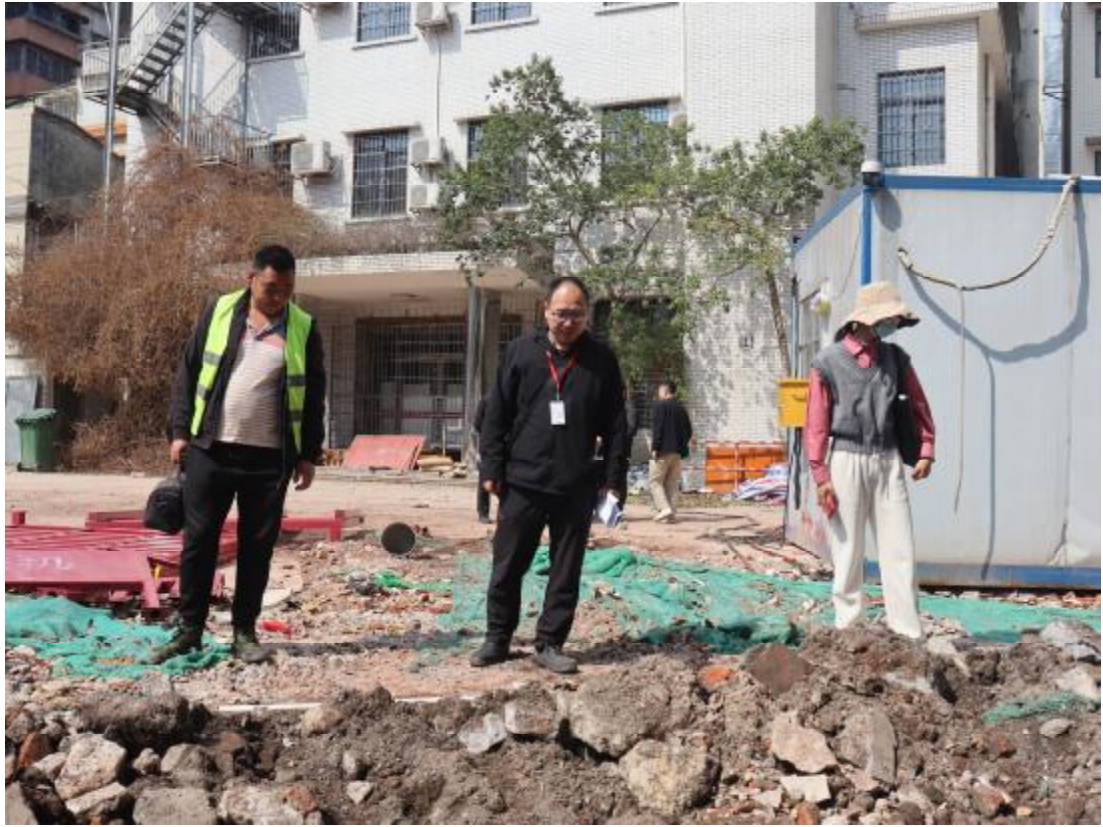
图 12 工作人员现场踏查（南-北）
