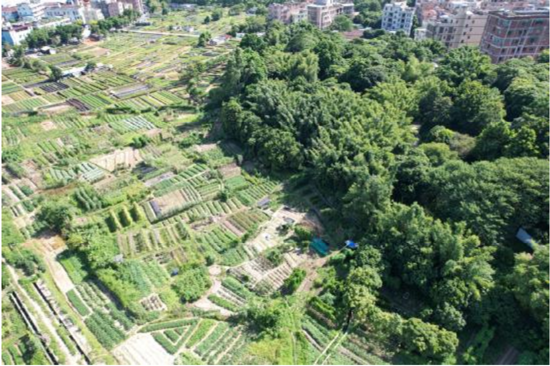
图 16 项目地块西南部地表现状（东北-西南）
