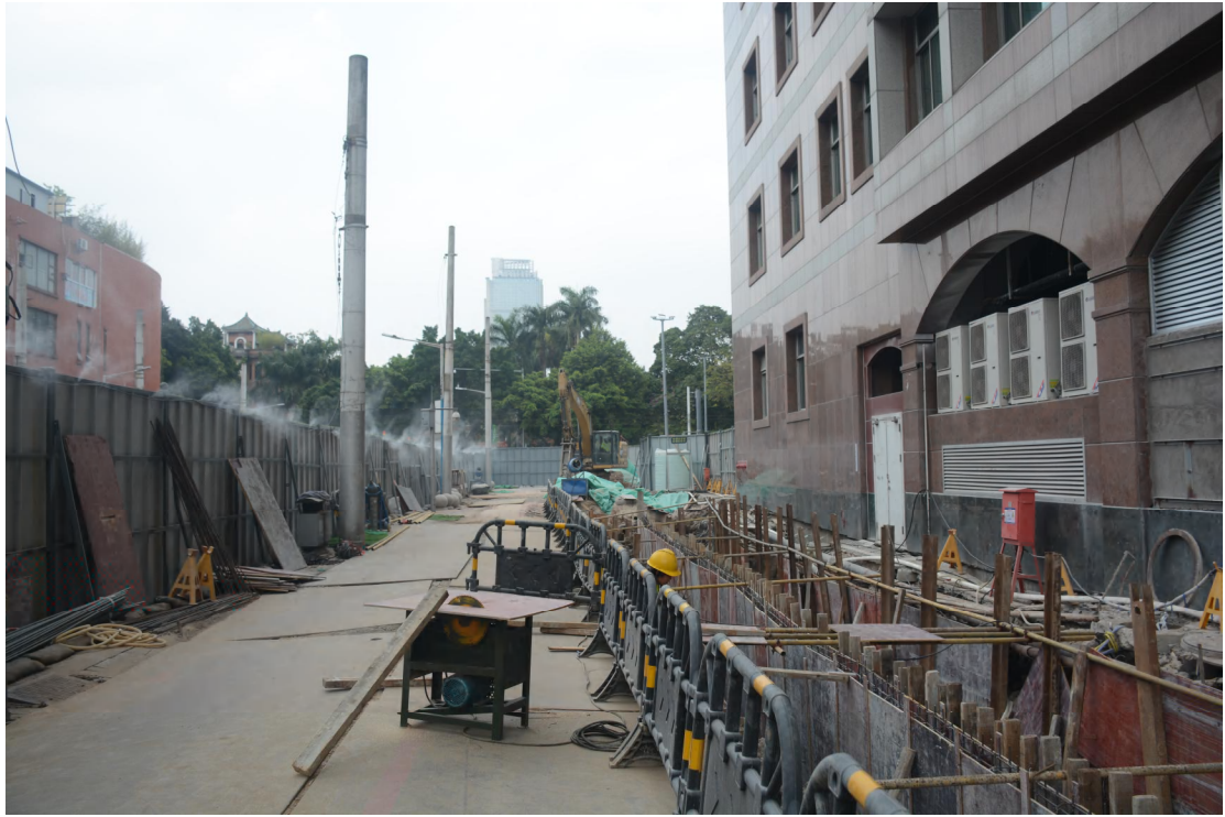
图 19 2022. 3. 18 项目地块内部地貌（南-北）
