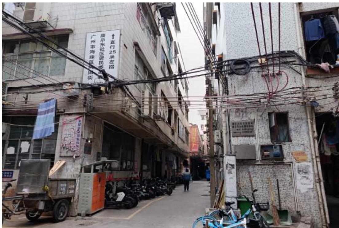
图 17 地块南部现状（北-南）
