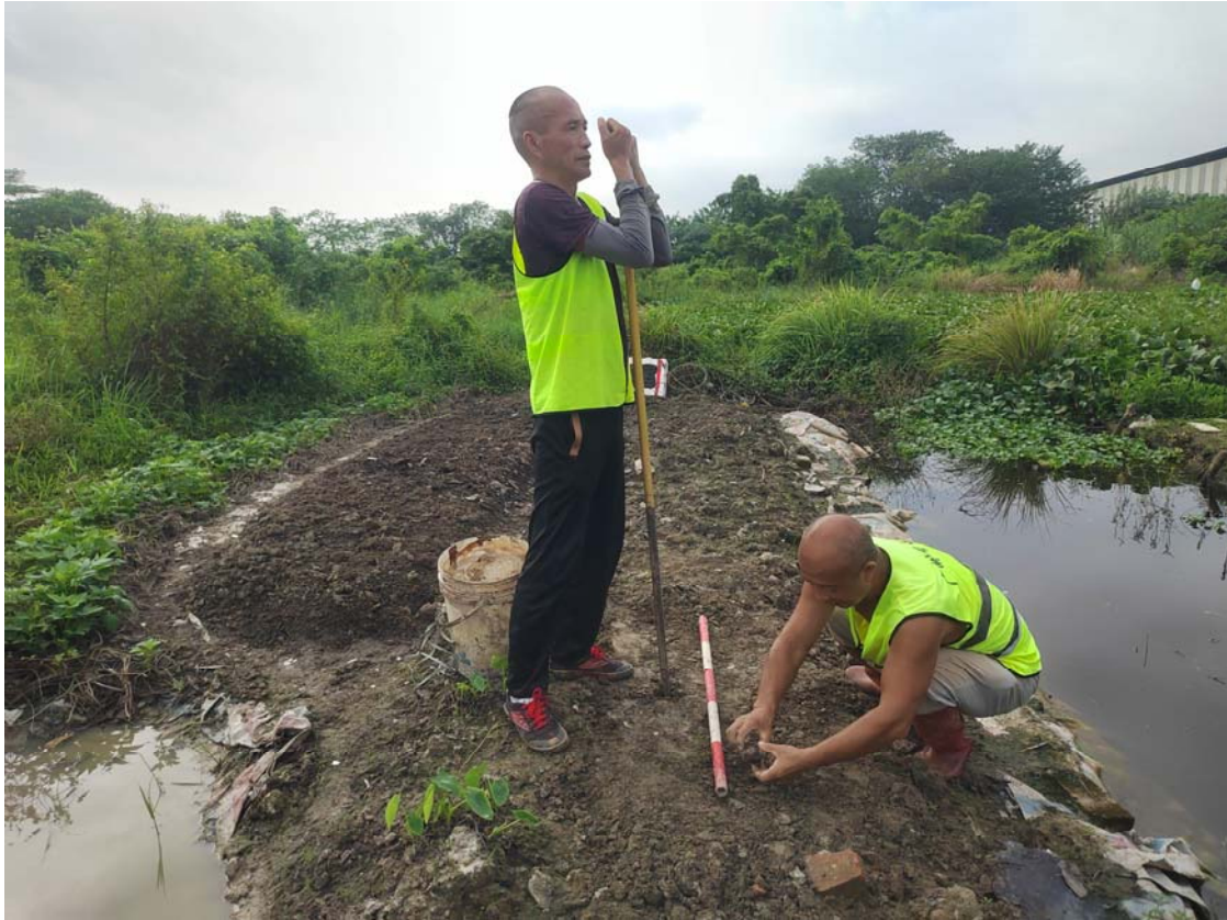
图 26 试探孔提取工作照（东-西）
