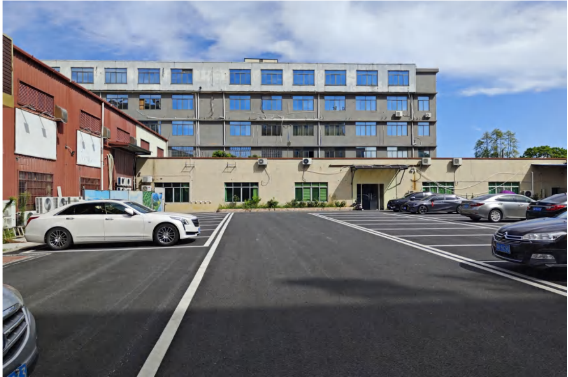
图 29 鸿岭地块内现状（东南-西北）
