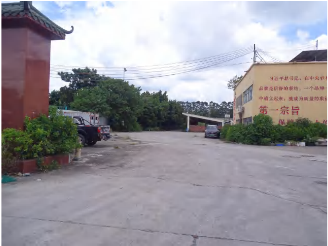
图 39 东南部地块西侧地表现状（北-南）
