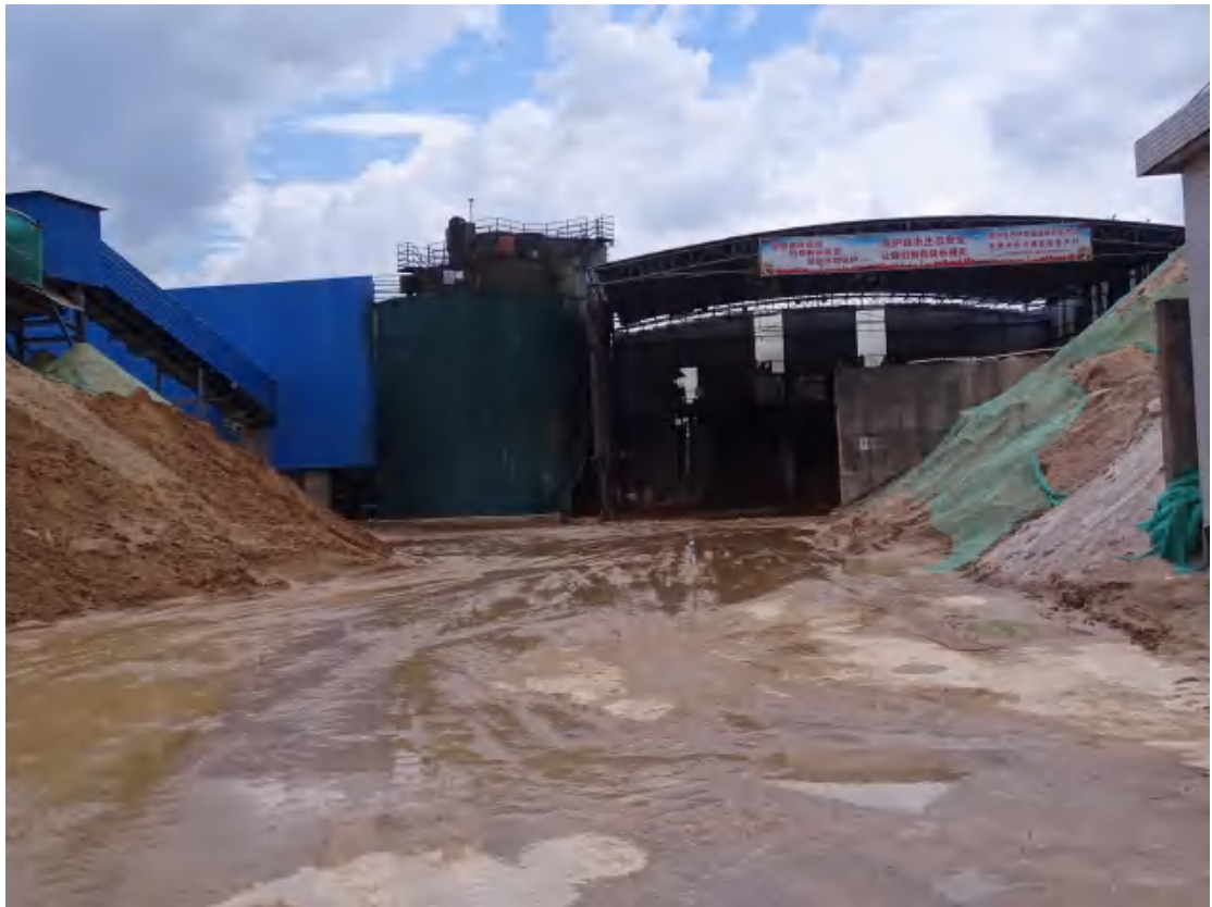
图 52 东南部地块东侧地表现状（东-西）
