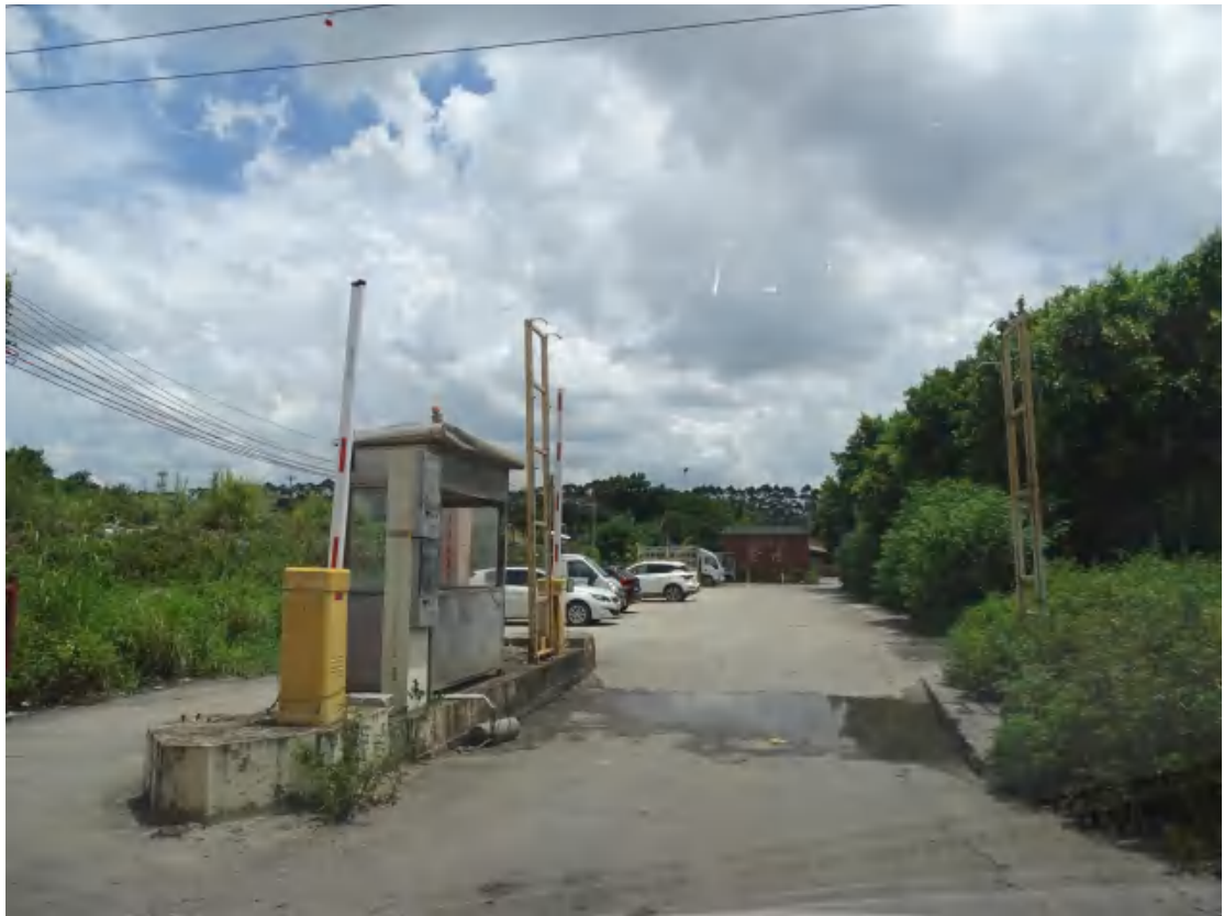
图 38 东南部地块西侧地表现状（北-南）
