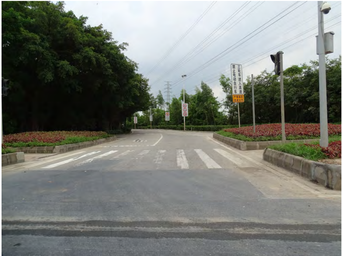
图 23 工程用地地表现状（西-东）
