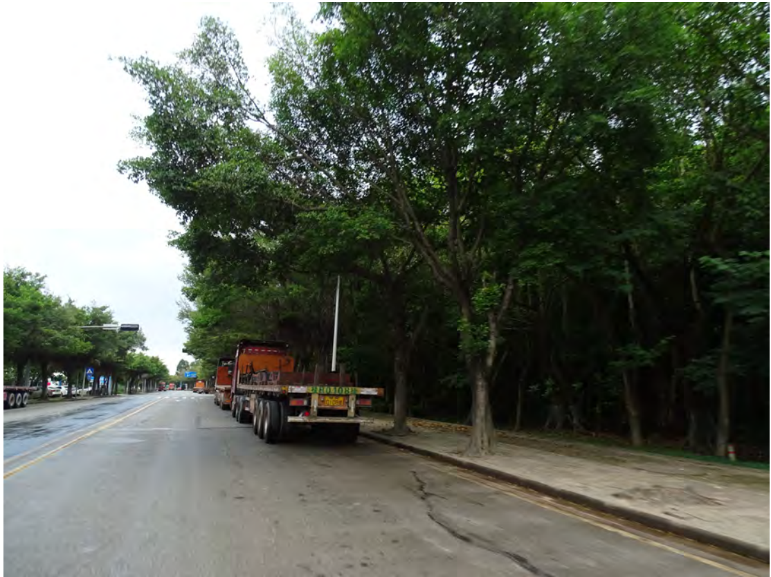
图 25 工程用地地表现状（西-东）
