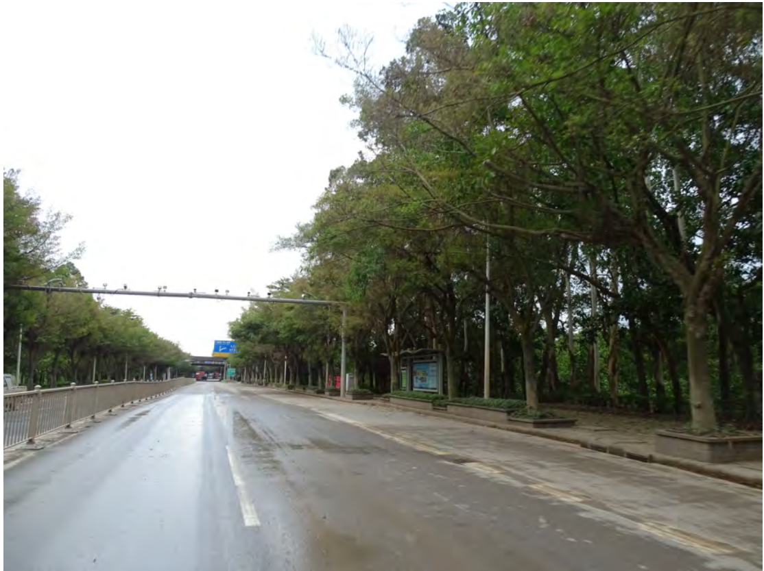
图 21 工程用地地表现状（南-北）
