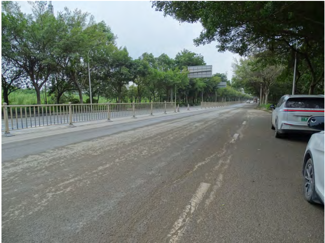
图 17 工程用地地表现状（南-北）
