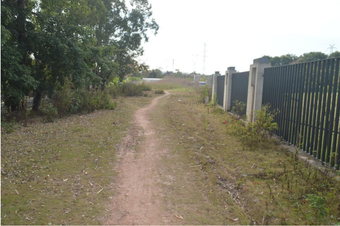
图 8 污水主管顶管范围内现状（北-南）
