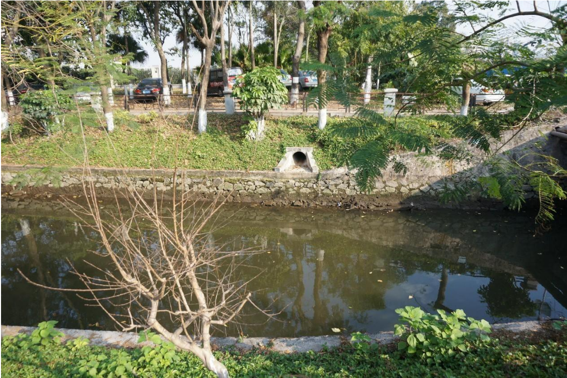
图 30 污水主管顶管范围内现状（西南-东北）
