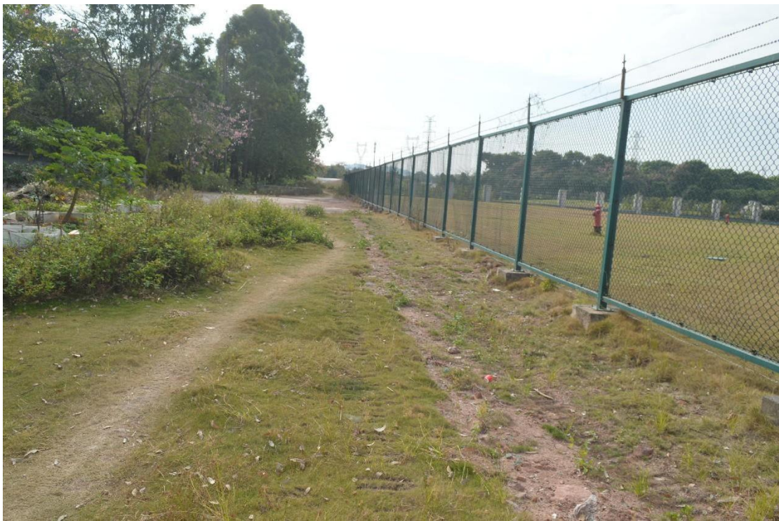
图 27 污水主管顶管范围内现状（南-北）
