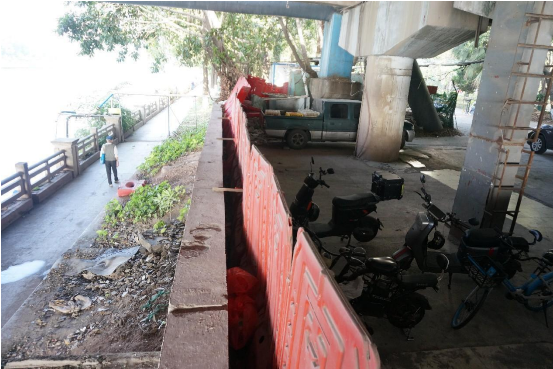
图 21 污水主管顶管范围内现状（东南-西北）
