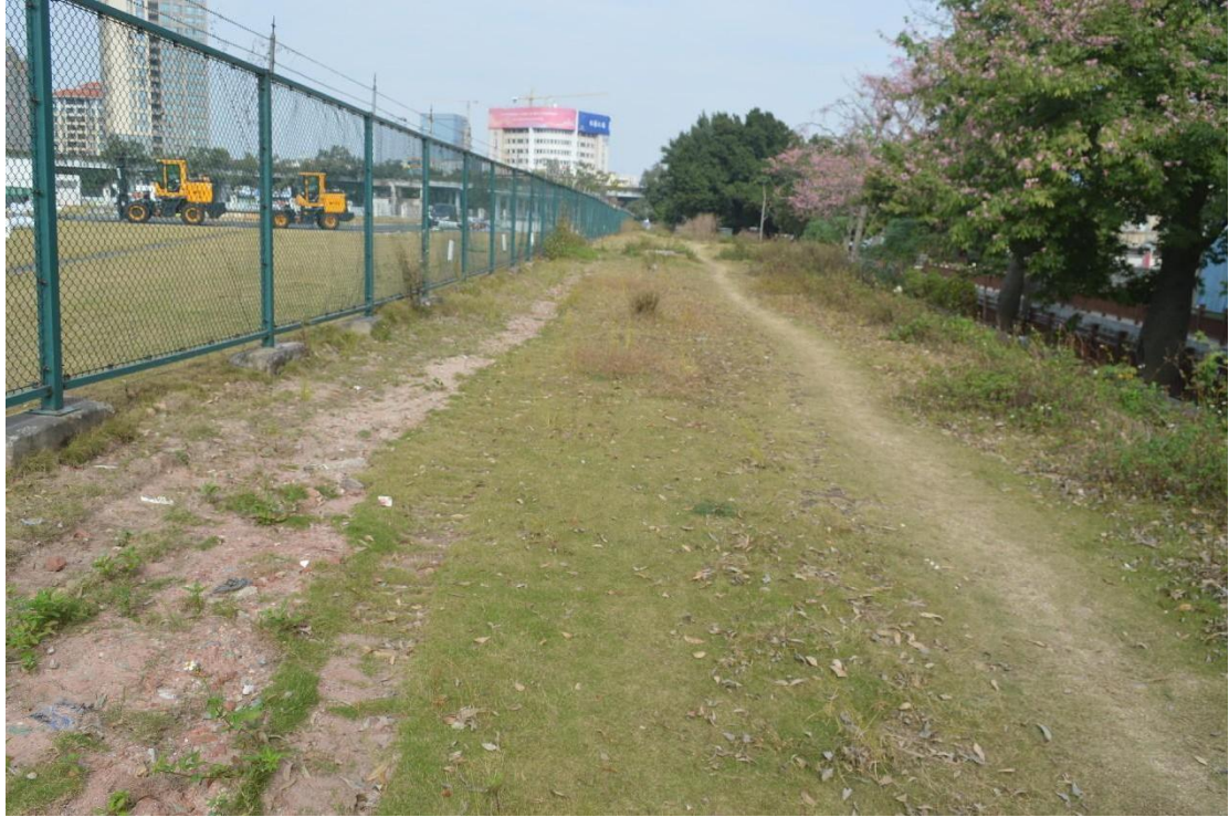
图 26 污水主管顶管范围内现状（南-北）
