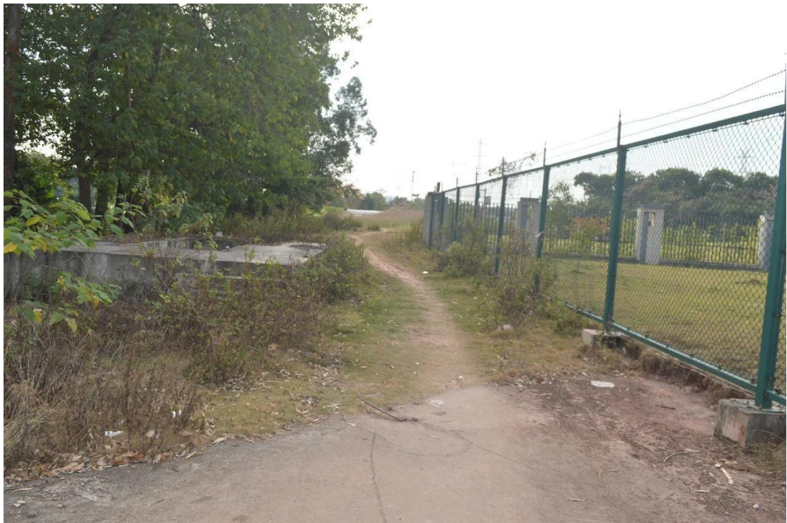
图 7 污水主管顶管范围内现状（北-南）
