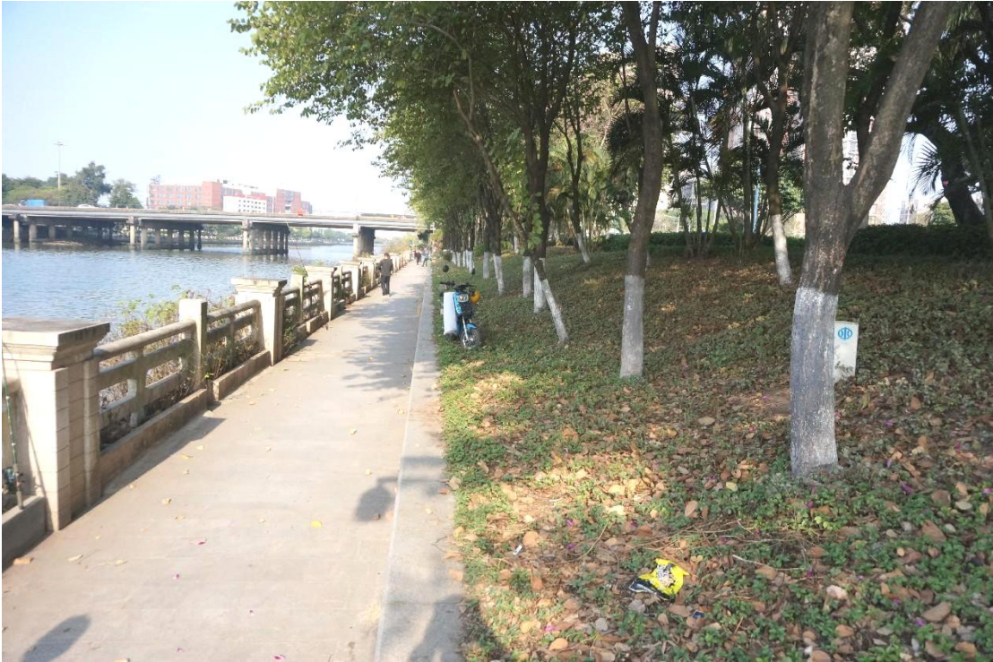
图 18 污水主管顶管范围内现状（东南-西北）
