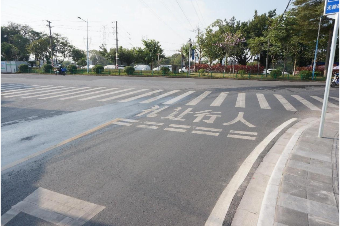
图 14 污水主管顶管范围内现状（东北-西南）
