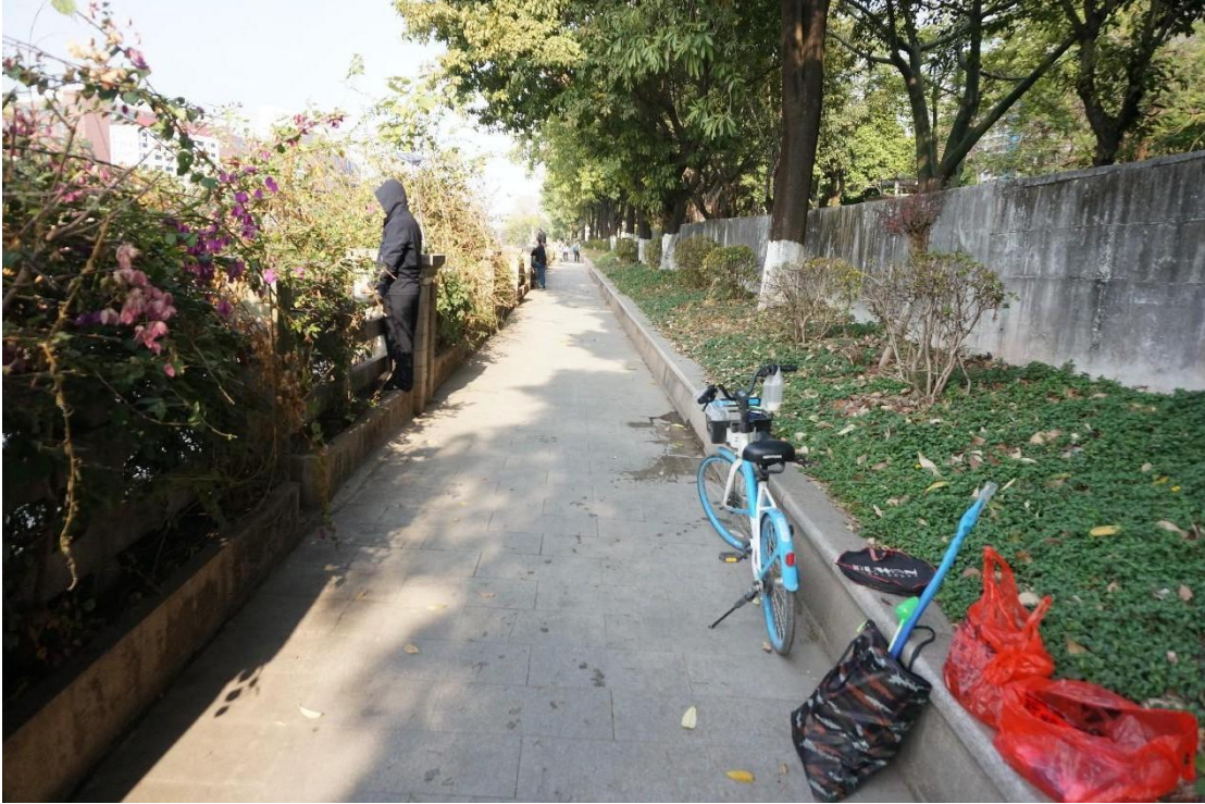
图 22 污水主管顶管范围内现状（东南-西北）
