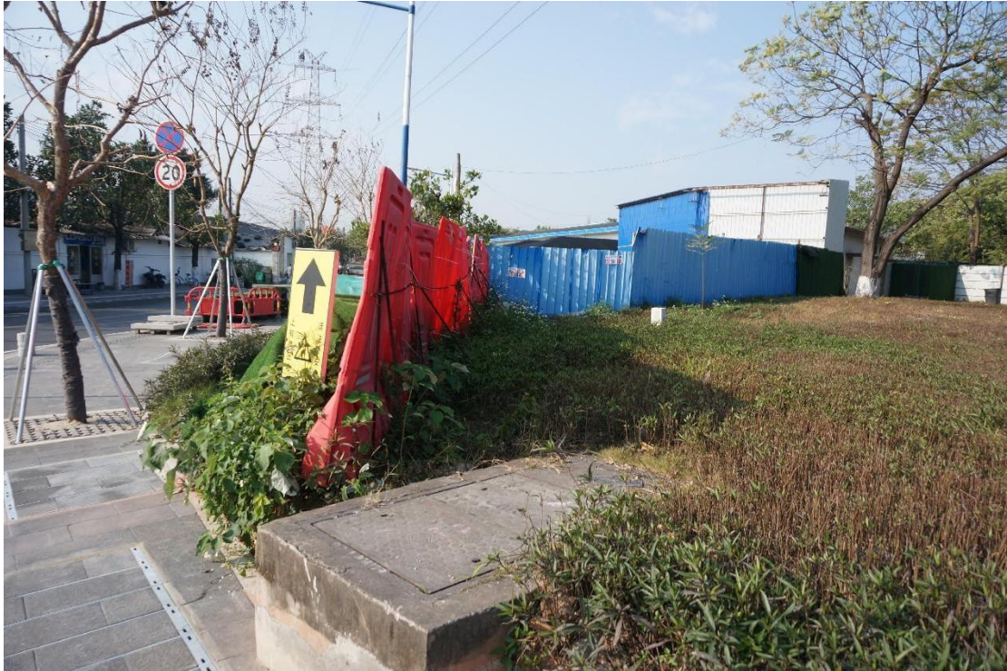
图 10 污水主管顶管范围内现状（东北-西南）
