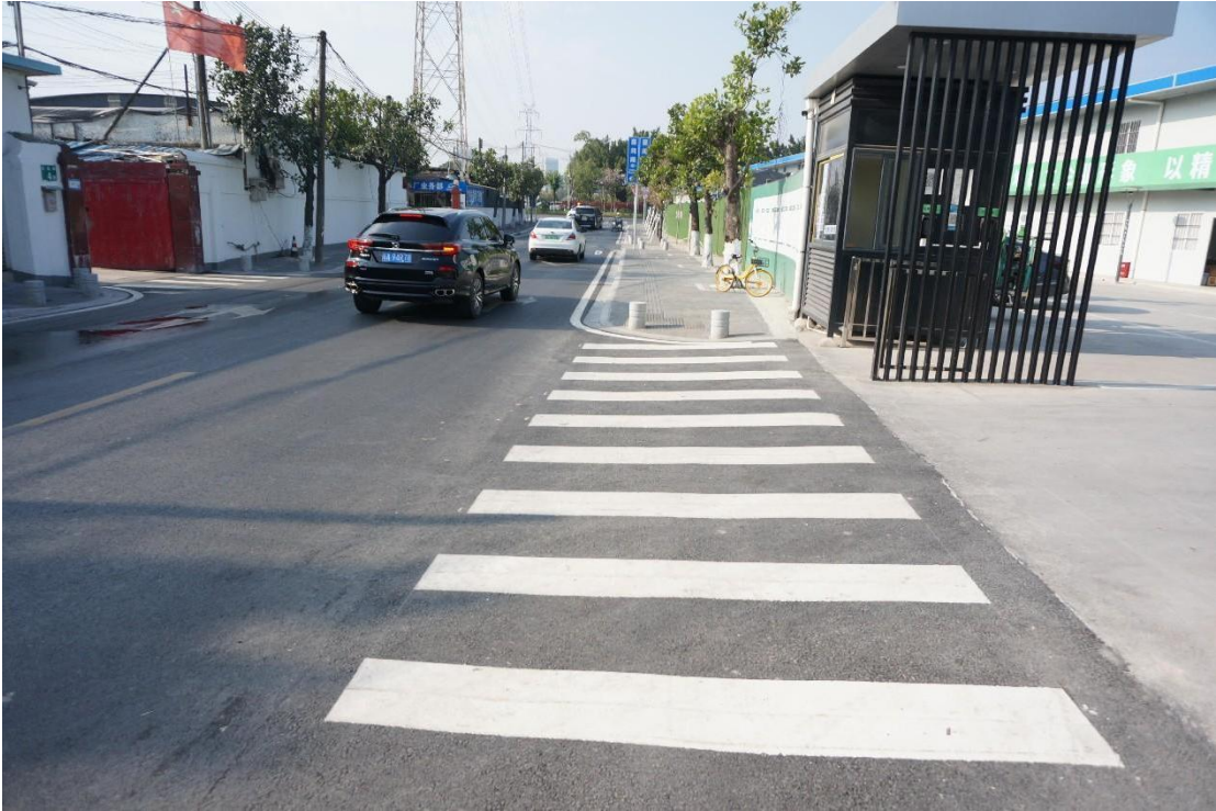
图 12 污水主管顶管范围内现状（东北-西南）
