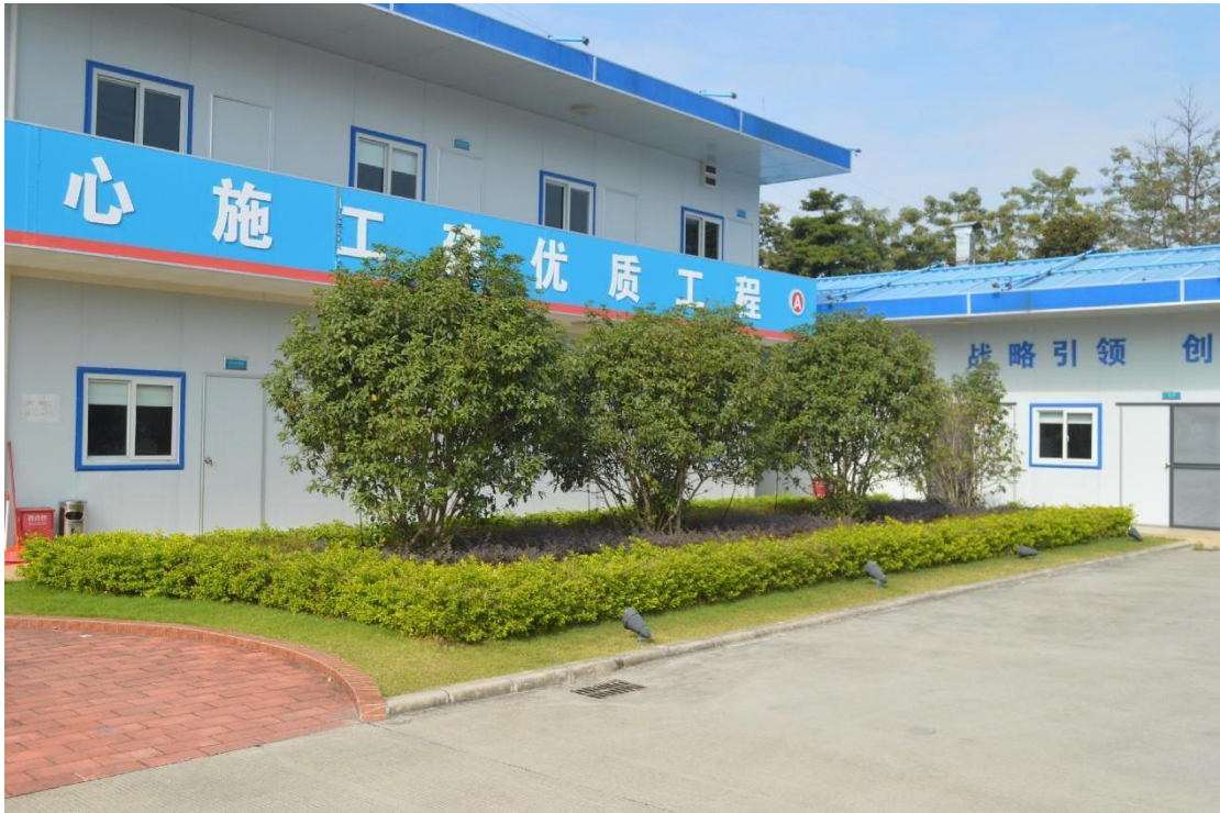
图 33 菊树泵站范围内现状（东南-西北）
