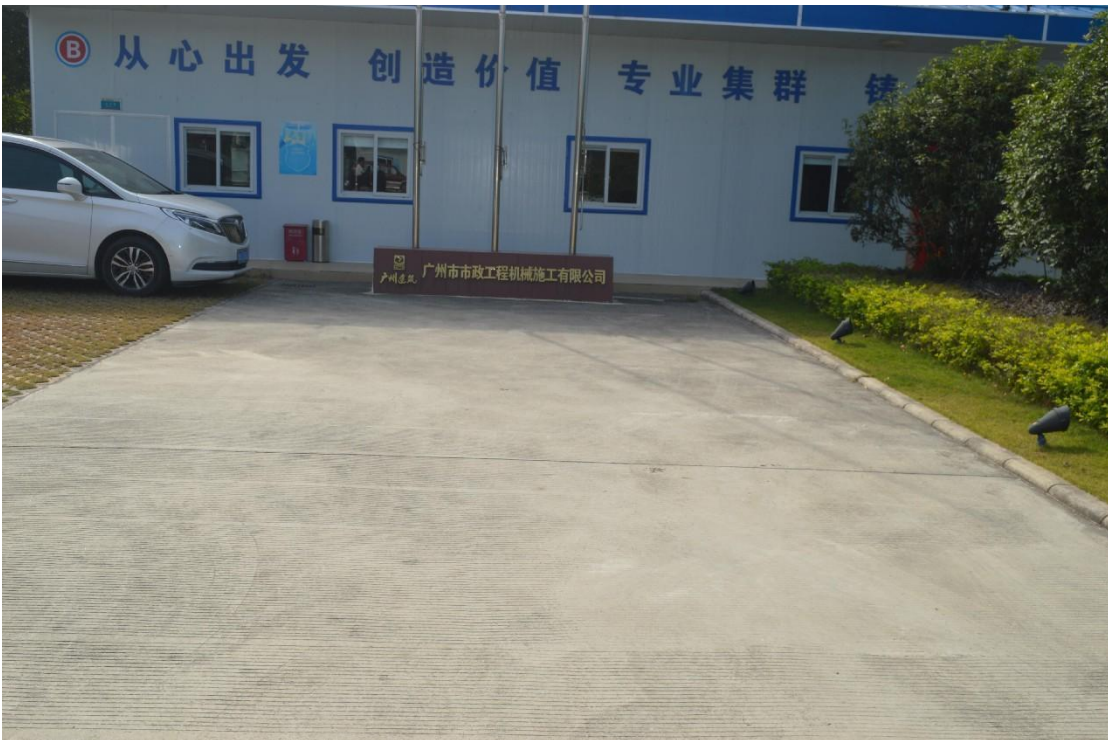
图 31 菊树泵站范围内现状（北-南）
