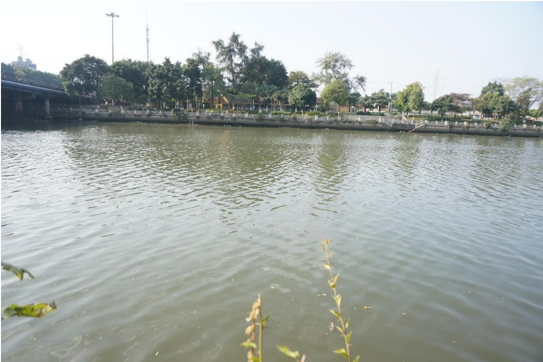
图 15 污水主管顶管范围内现状（东北-西南）
