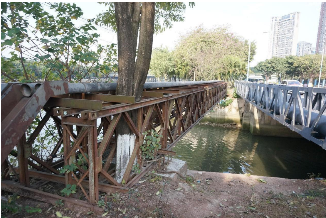
图 17 污水主管顶管范围内现状（东南-西北）
