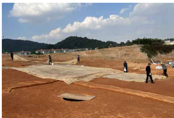
图 121 铺设防水布工作照（南-北）
