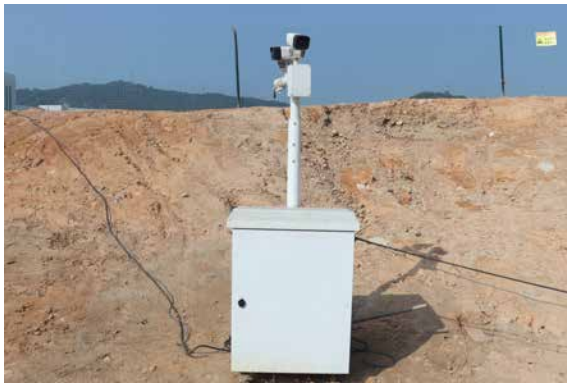
图 106 发掘现场移动监控设备
