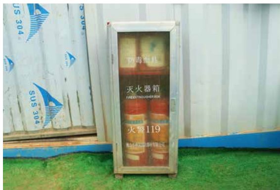
图 111 发掘现场消防器材
