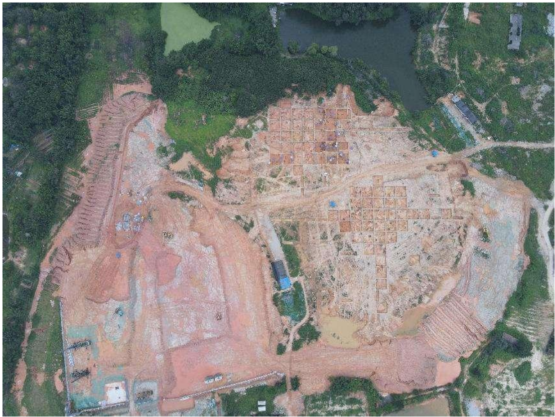
图 7 竹园岭遗址 2023 年 6 月 16 日全景（俯视）
