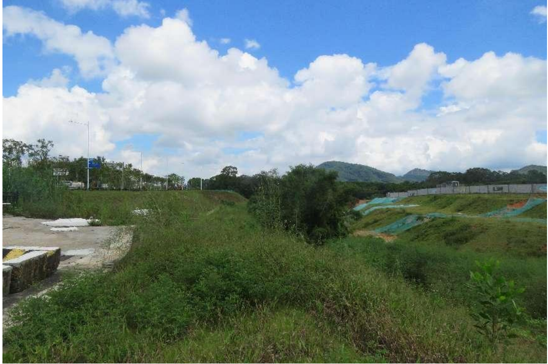
图 25 地块西部地表现状（南-北）
