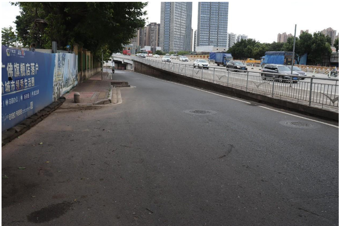
图 11 地块内现状（北-南）
