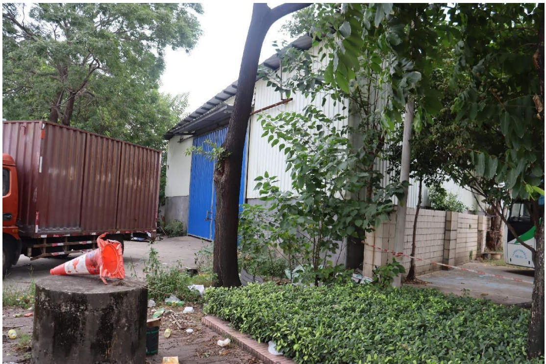
图 21 地块内现状（西南-东北）
