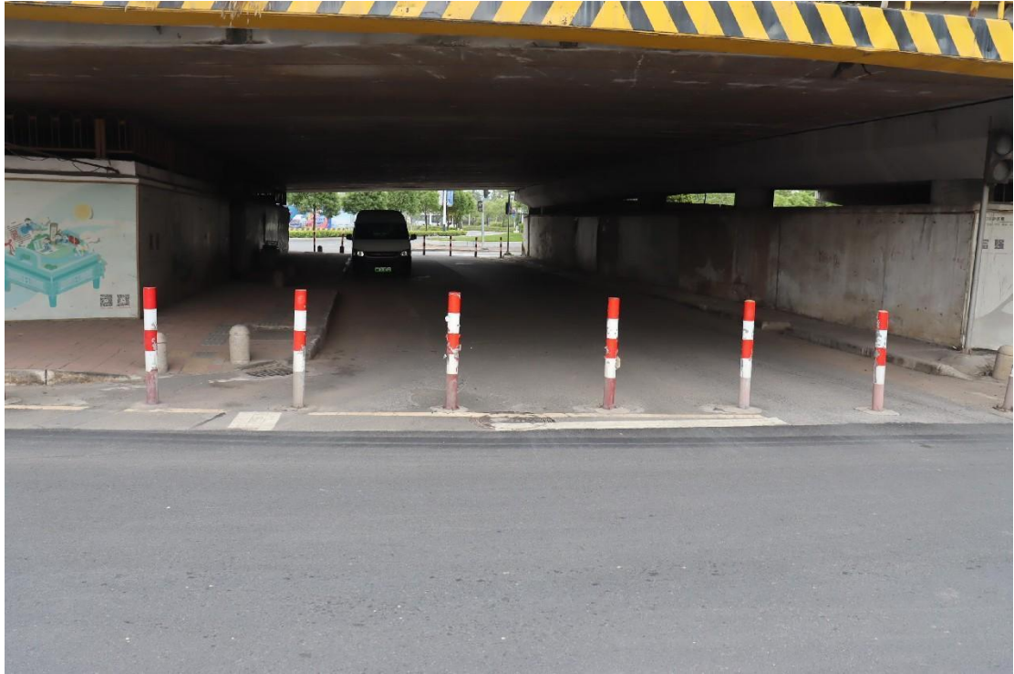
图 18 地块内现状（西-东）
