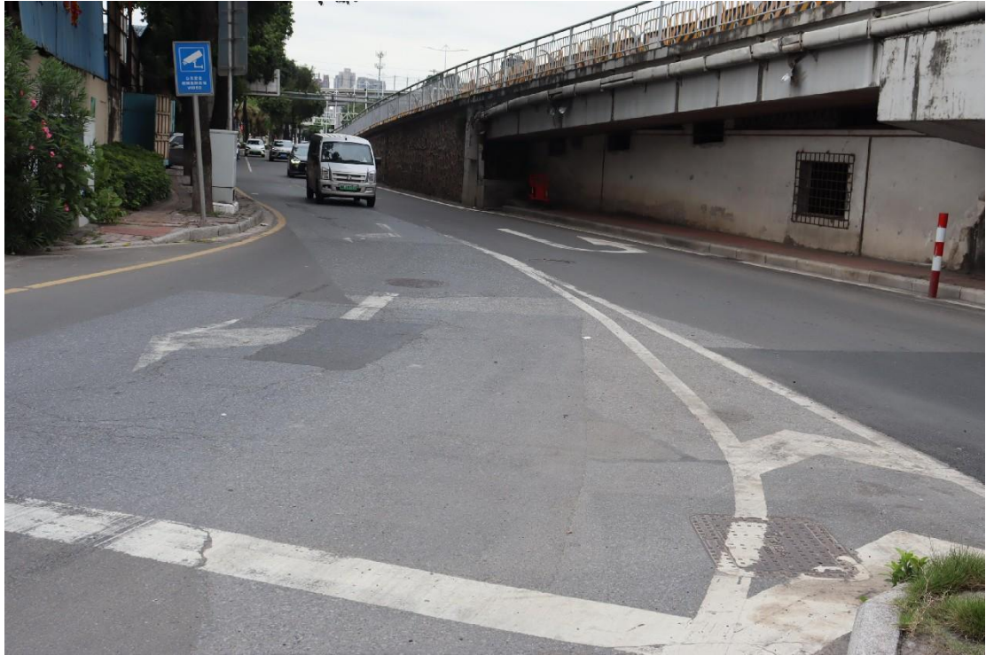
图 16 地块内现状（北-南）
