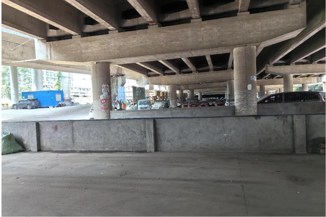
图 12 地块内现状（东-西）
