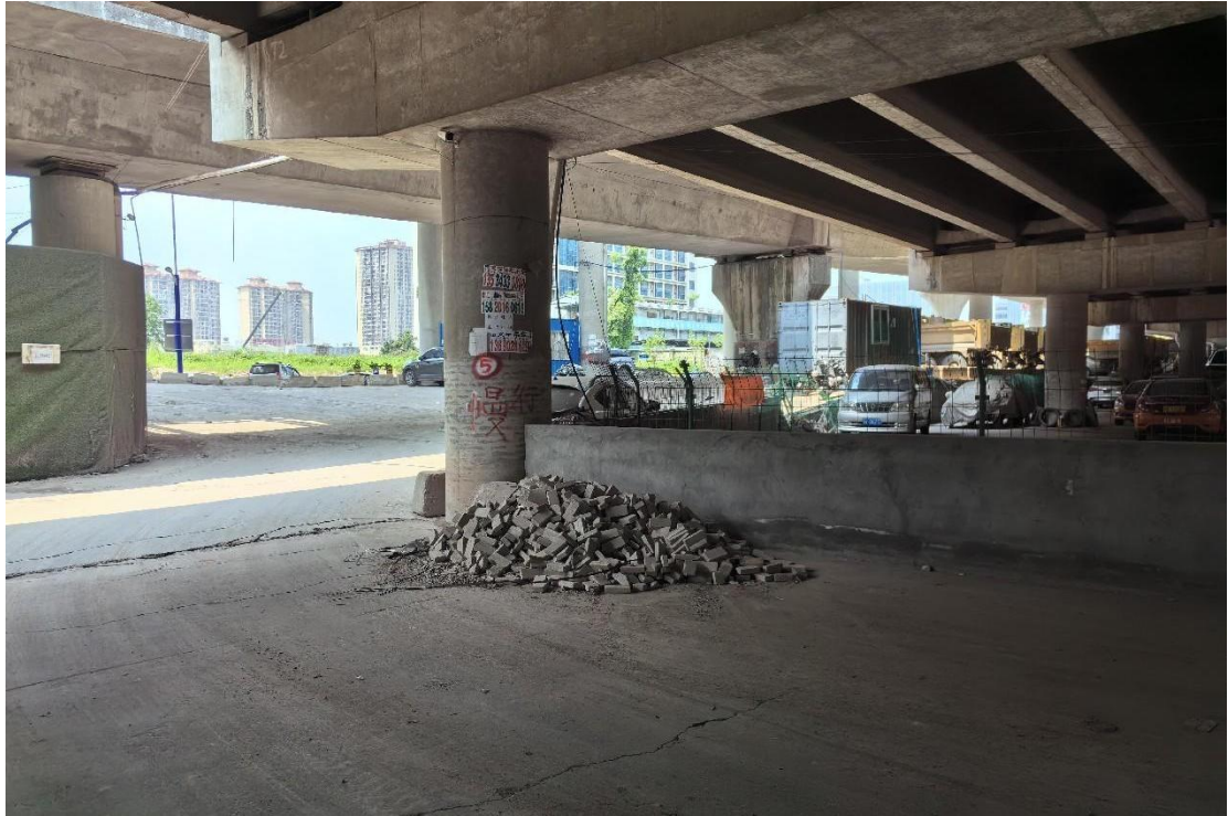
图 8 地块内现状（东北-西南）
