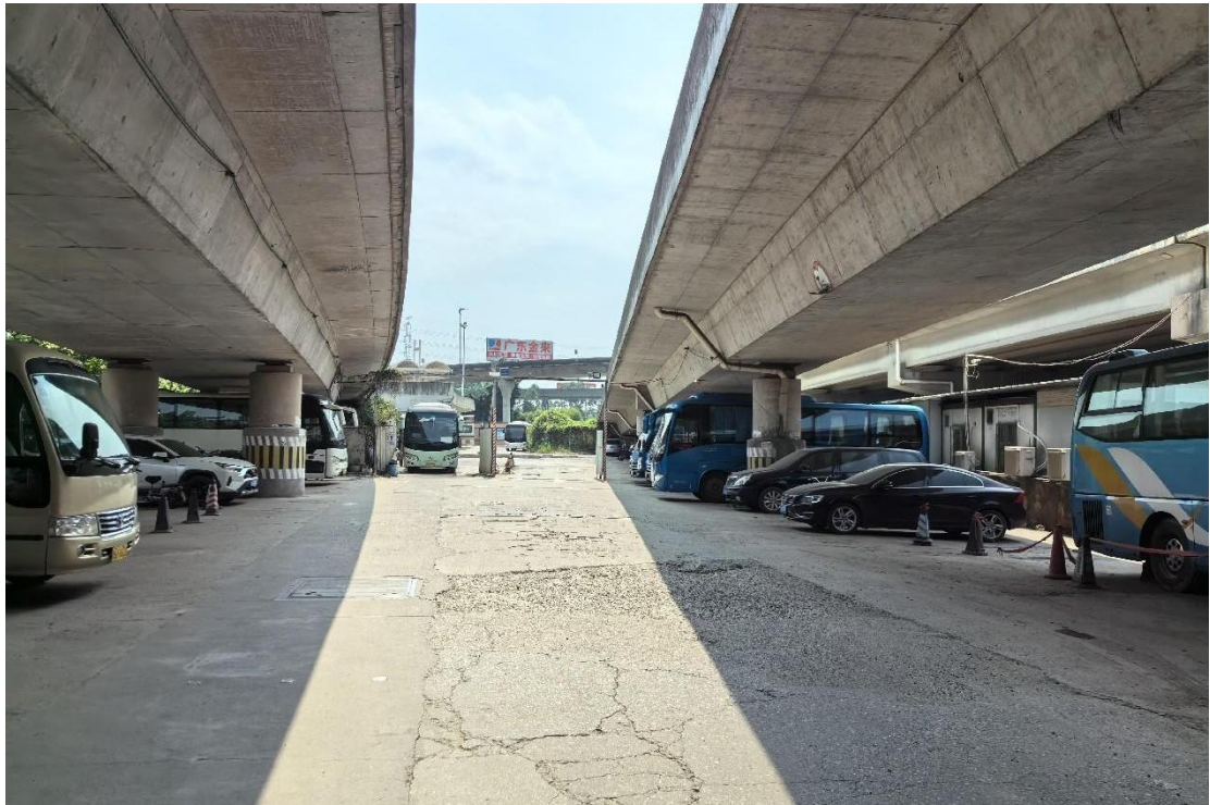
图 15 地块内现状（西-东）
