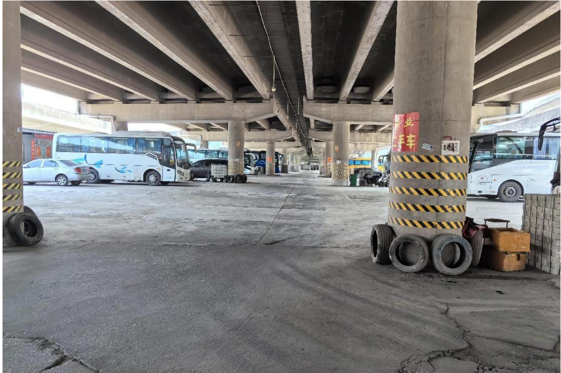
图 16 地块内现状（东-西）
