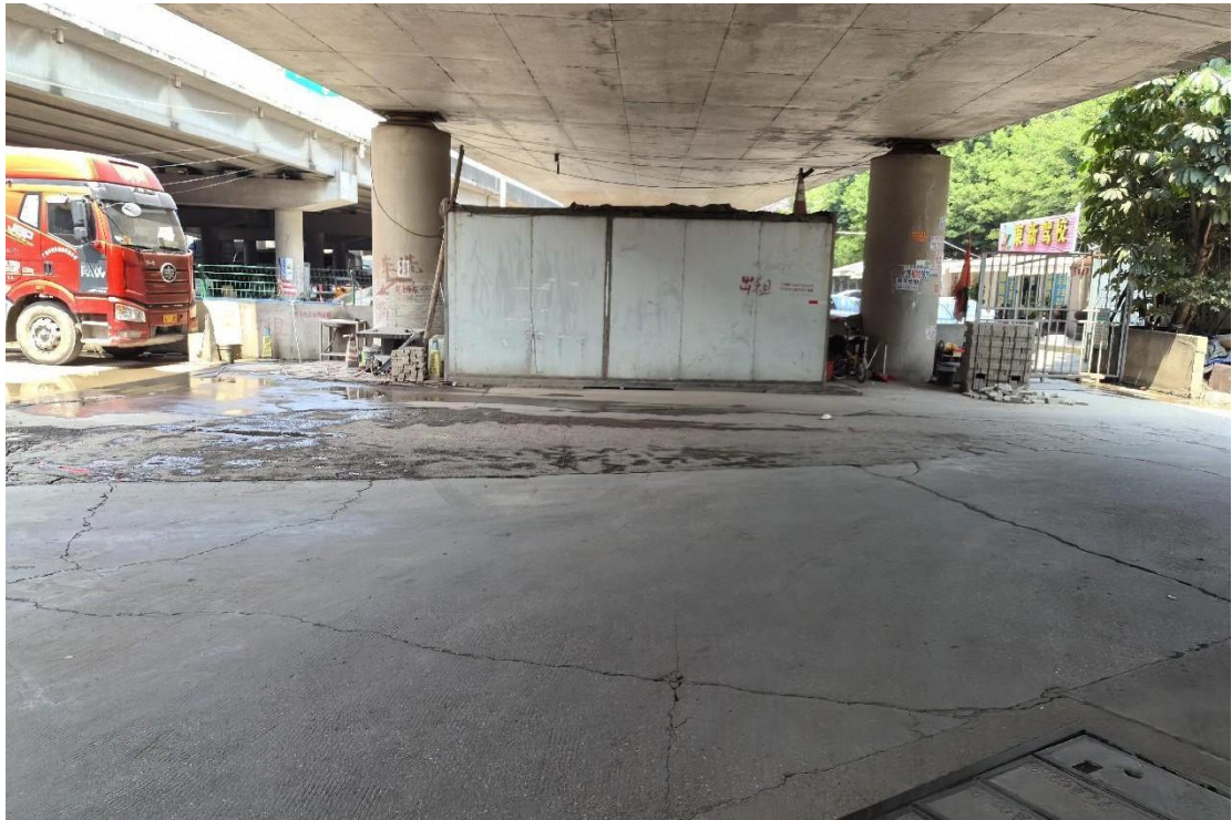
图 11 地块内现状（东-西）
