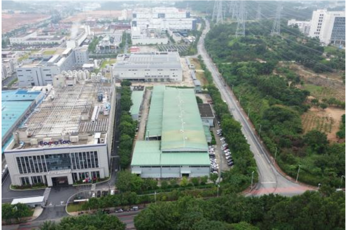
图 10 地块外南部现状（北-南）
