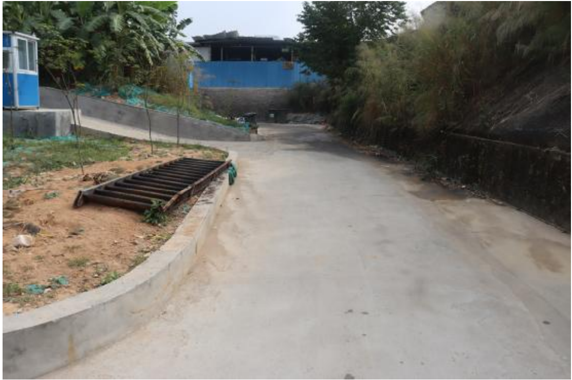
图 14 地块内现状（西-东）
