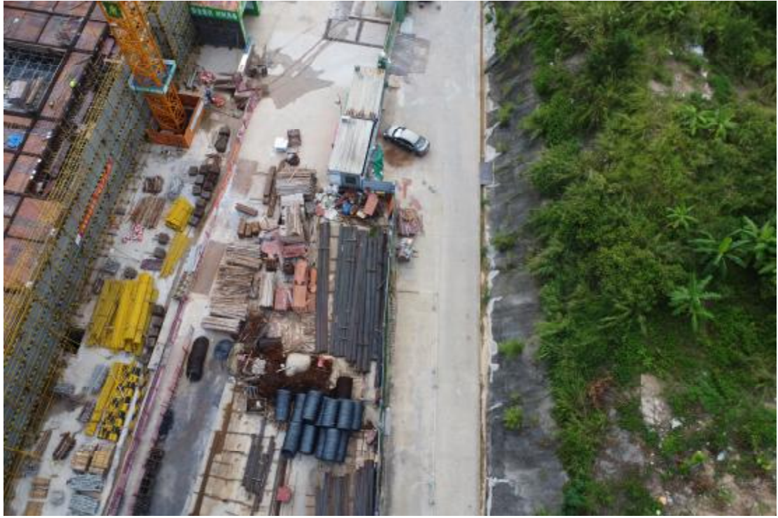
图 10 地块内现状（西-东）
