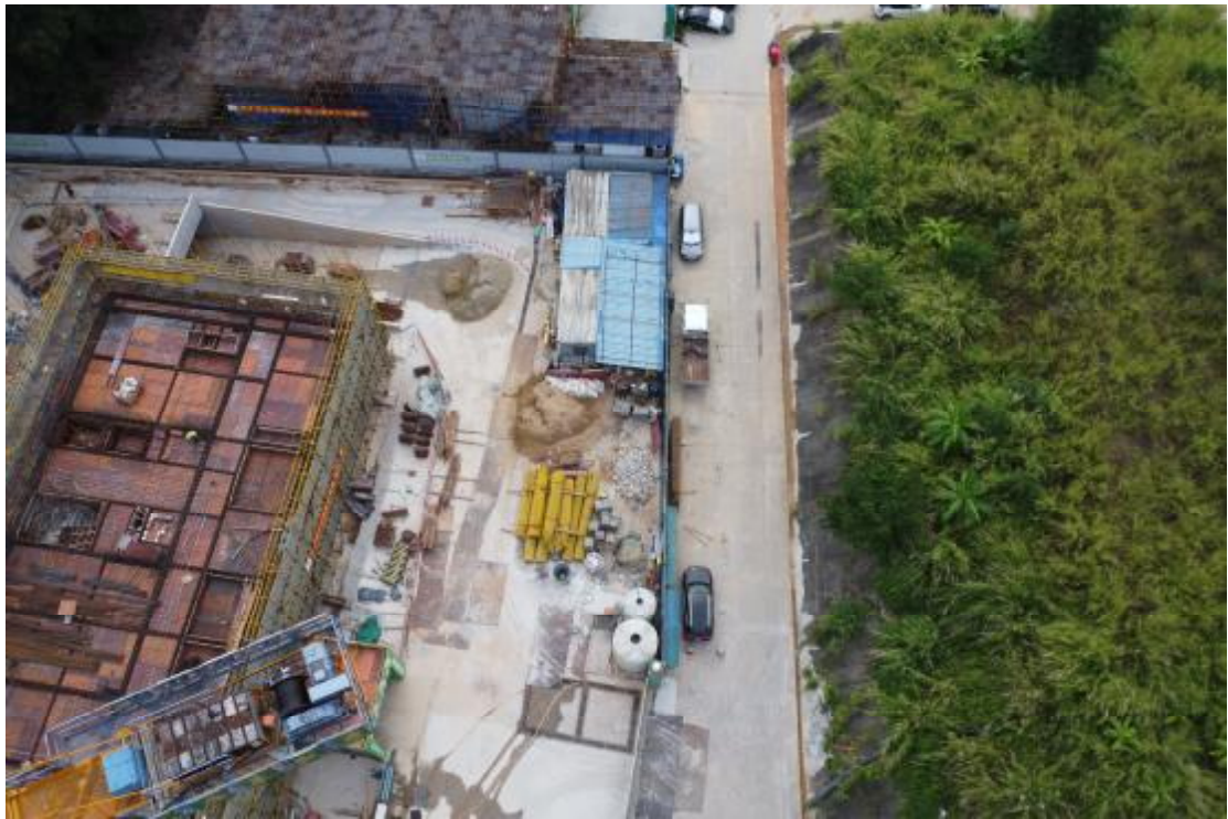
图 11 地块内现状（西-东）
