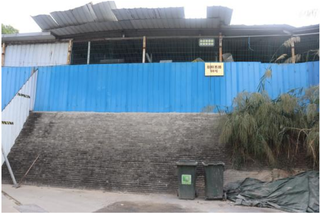
图 16 地块内现状（西-东）
