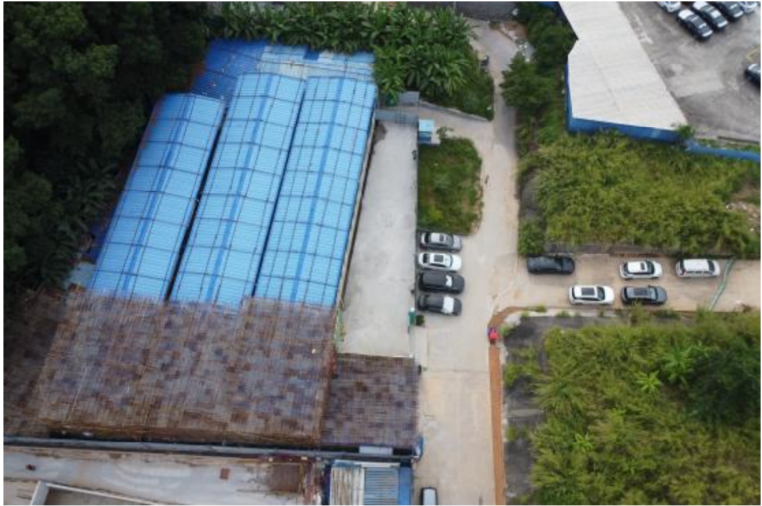
图 12 地块内现状（西-东）
