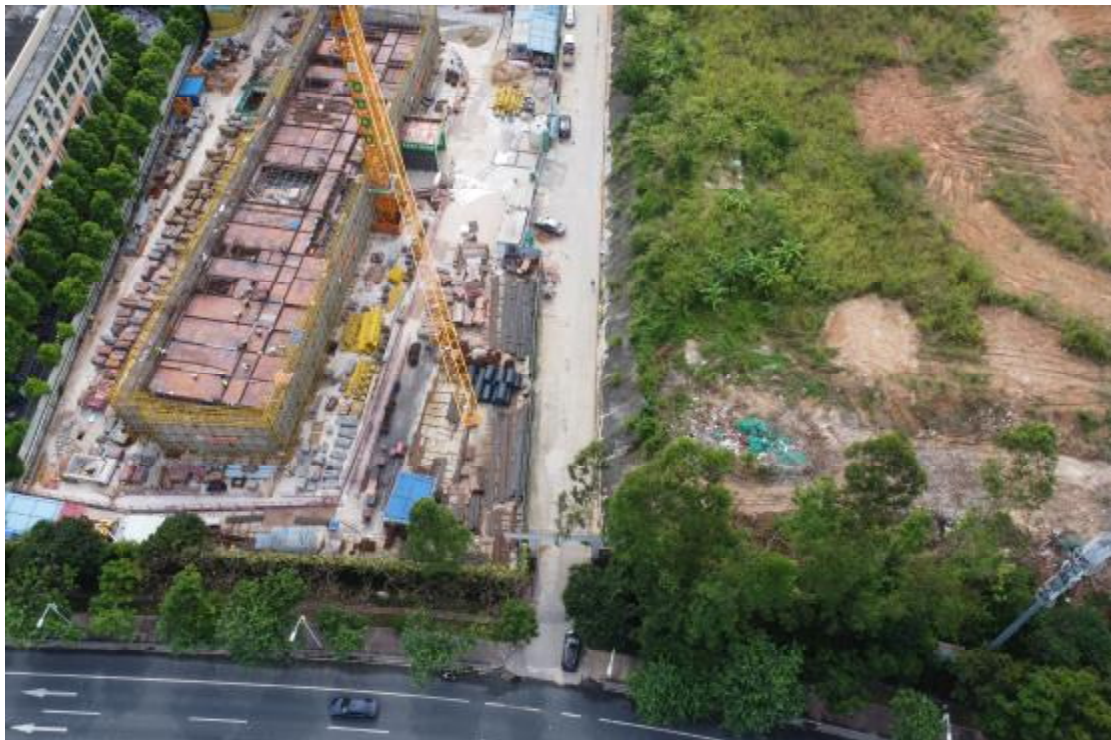
图 9 地块内现状（西-东）
