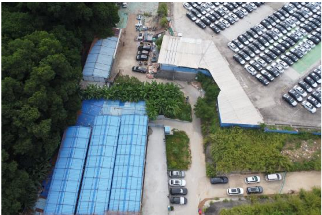
图 13 地块内现状（西-东）
