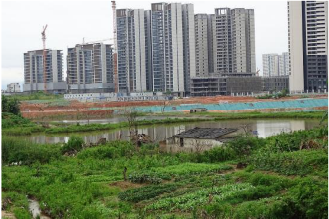
图 21 工程用地地表现状（西-东）
