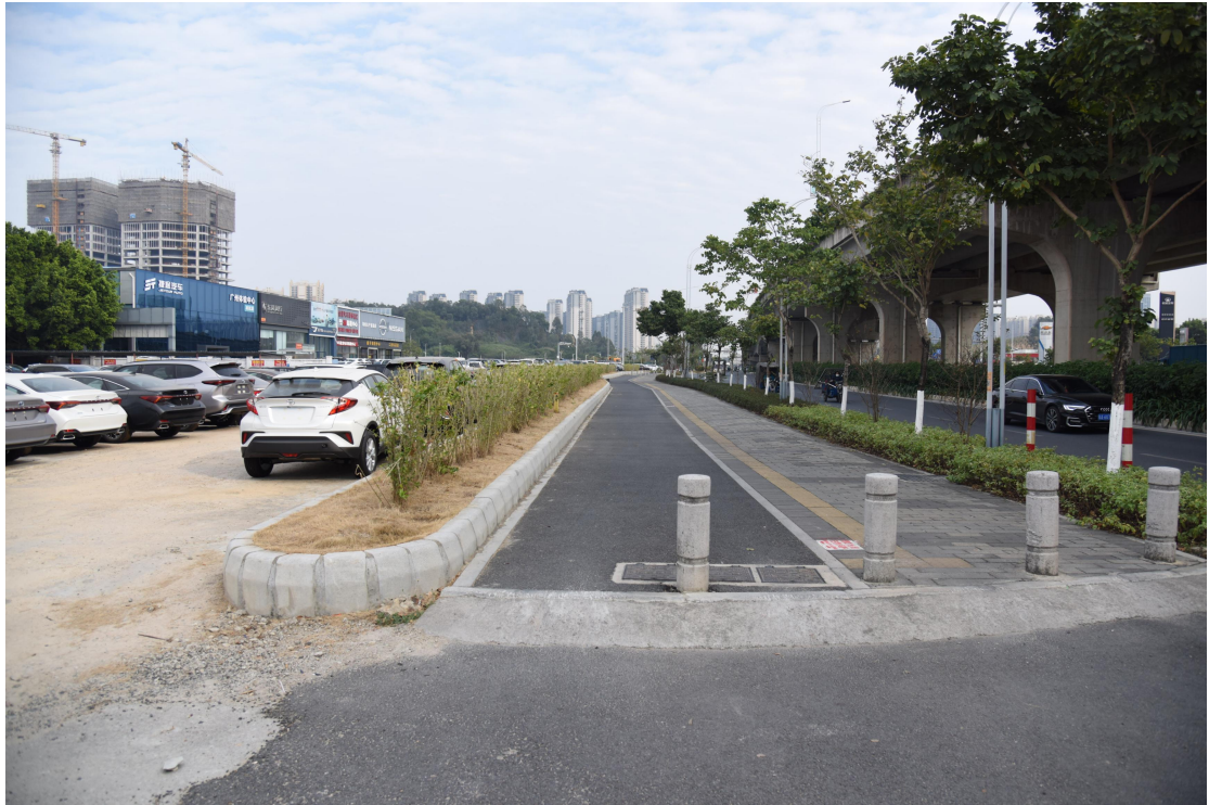
图 11 项目地块平步大道北侧路段现状（西-东）
