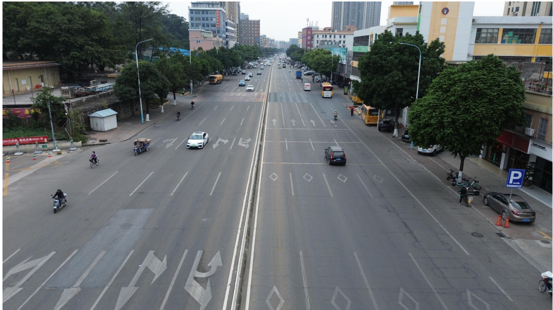
图 8 项目地块建设北路路段现状（北-南）
