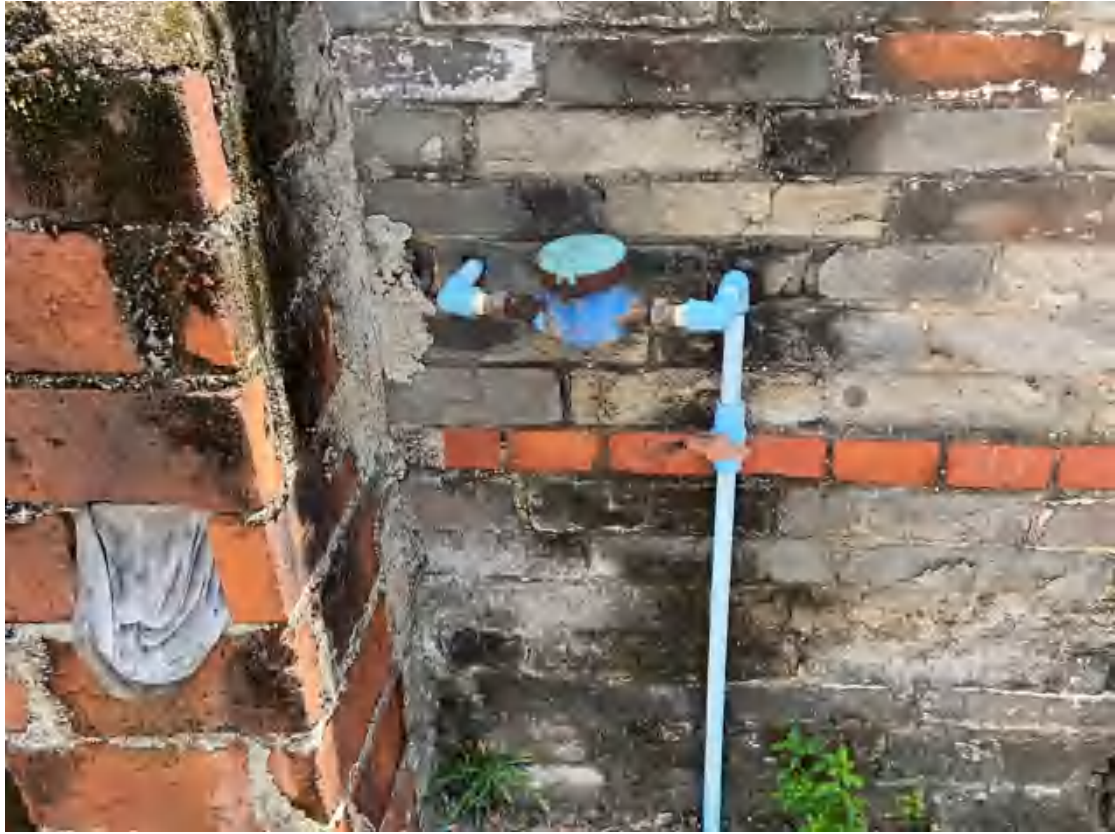
图 51 项目地块内部供水管现状（北-南）
