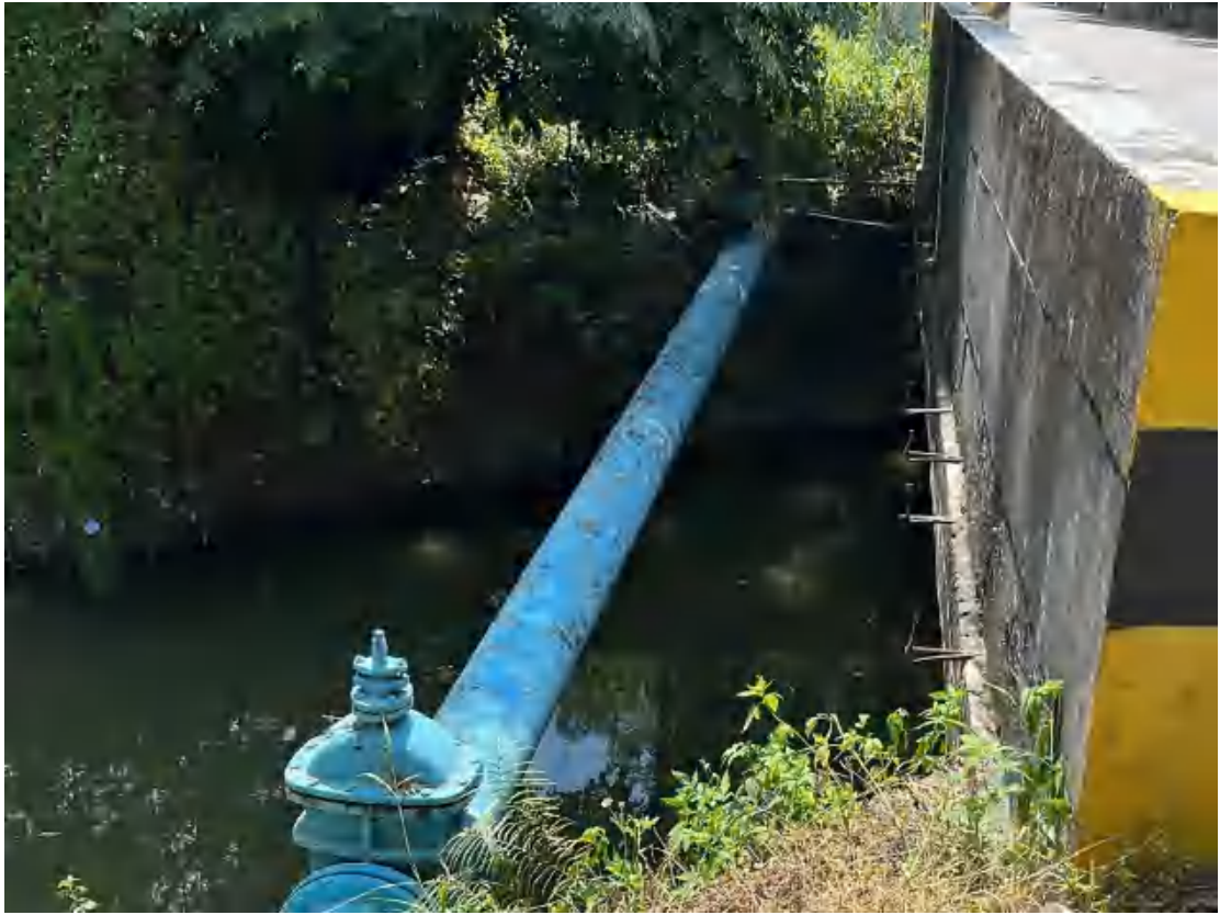
图 53 项目地块内部供水管现状（东北-西南）
