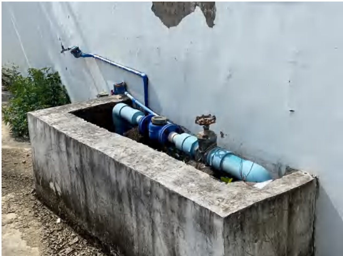
图 58 项目地块内部供水管现状（西北-东南）
