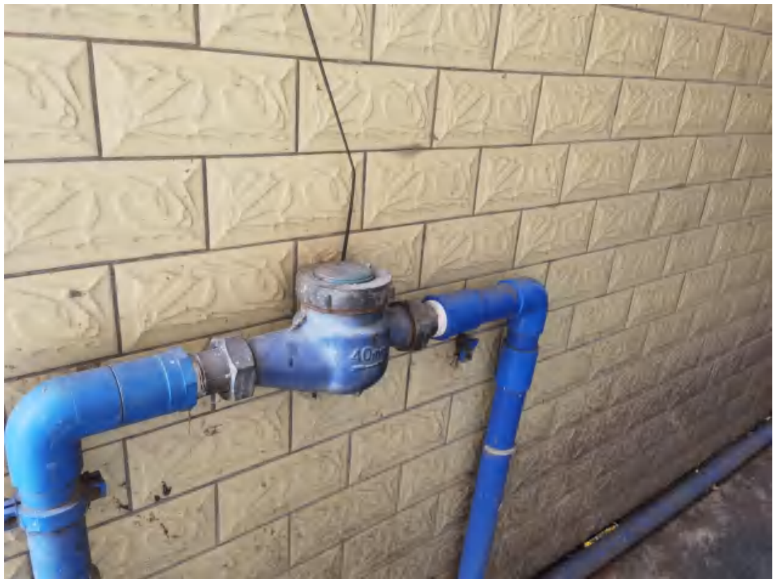
图 64 项目地块内部供水管现状（东北-西南）
