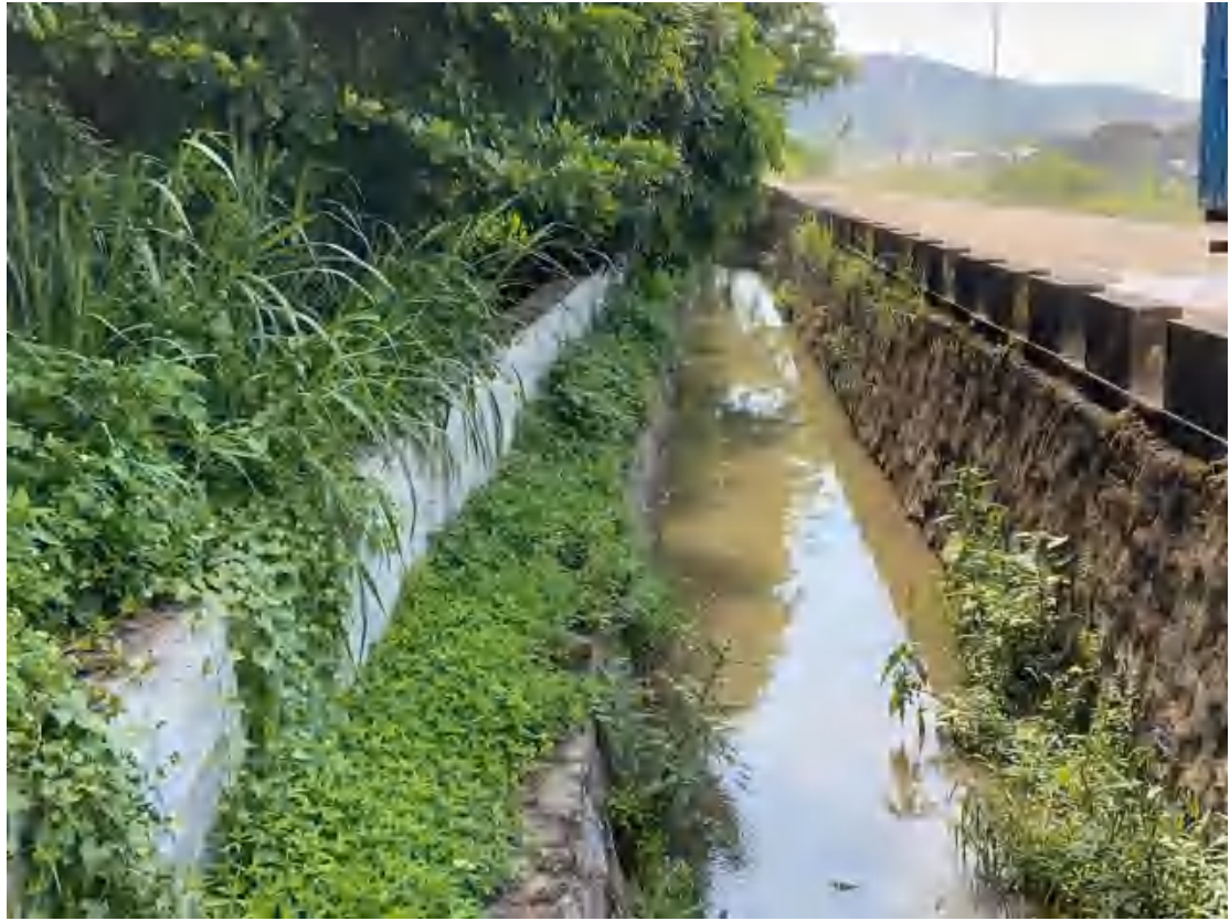
图 39 项目地块内部现状（西北-东南）
