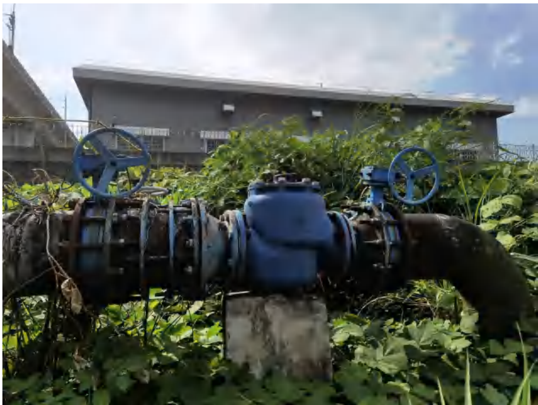
图 66 项目地块内部供水管现状（北-南）
