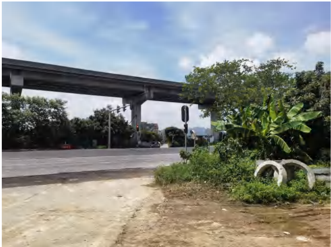
图 44 项目地块内部现状（南-北）
