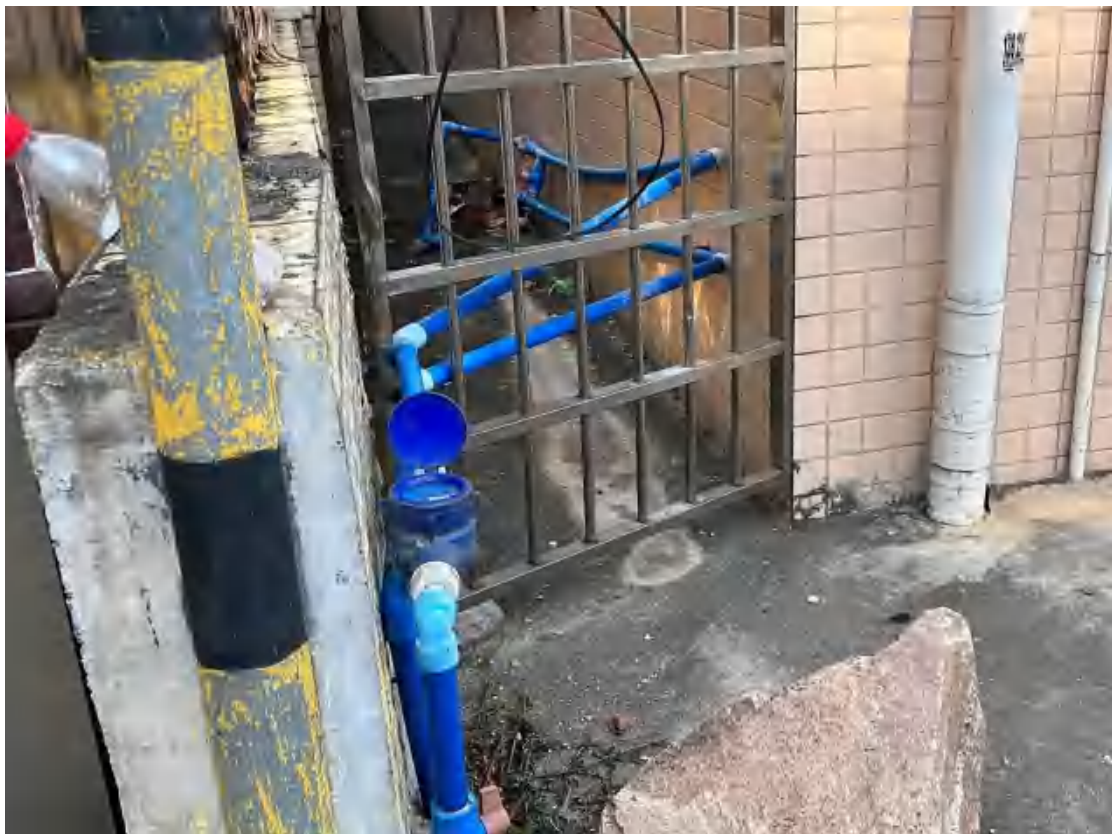
图 68 项目地块内部供水管现状（北-南）
