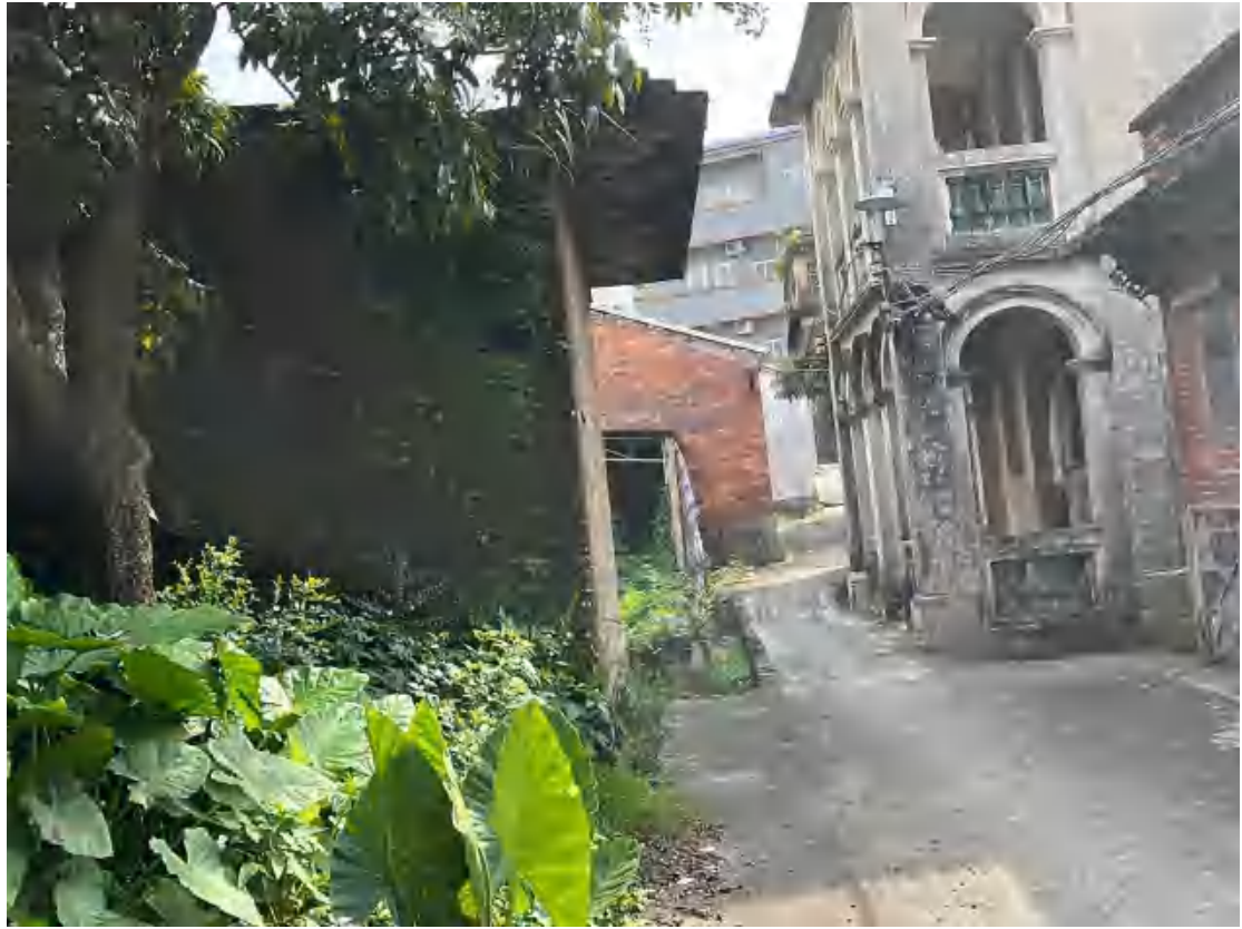
图 41 项目地块内部现状（北-南）
