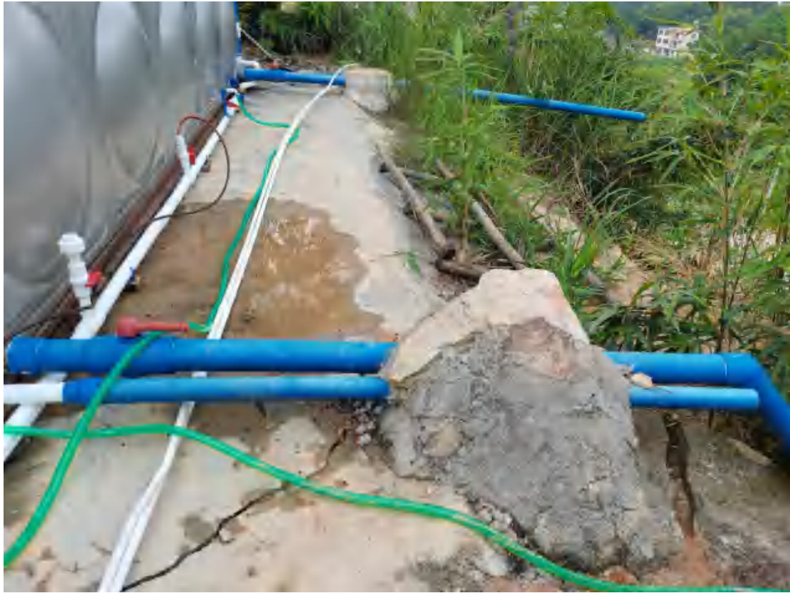
图 61 项目地块内部供水管现状（东北-西南）
