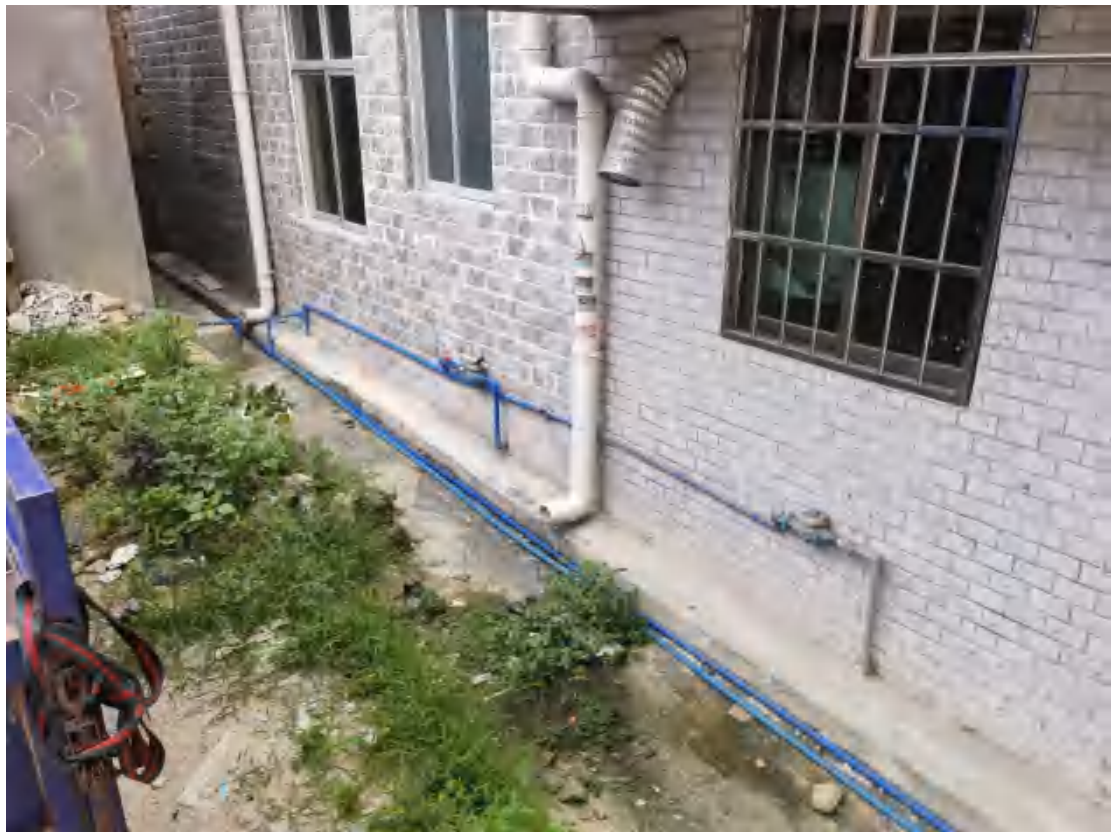
图 56 项目地块内部供水管现状（北-南）
