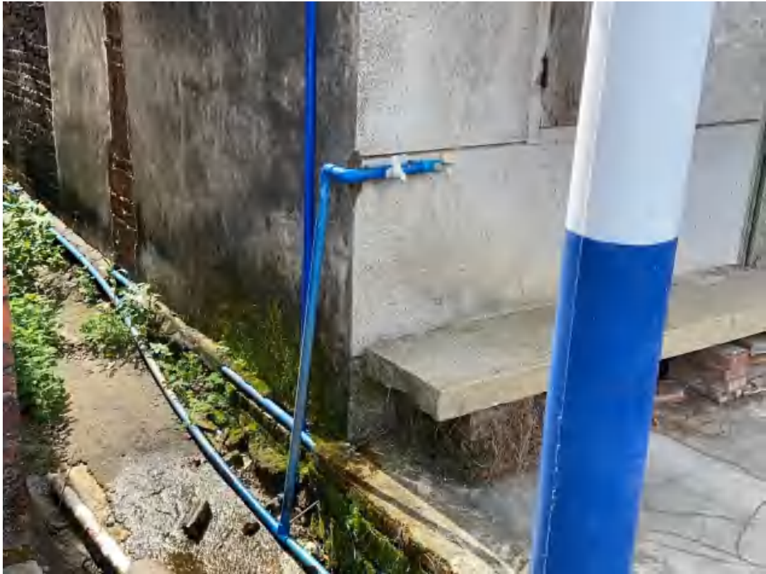
图 57 项目地块内部供水管现状（西北-东南）
