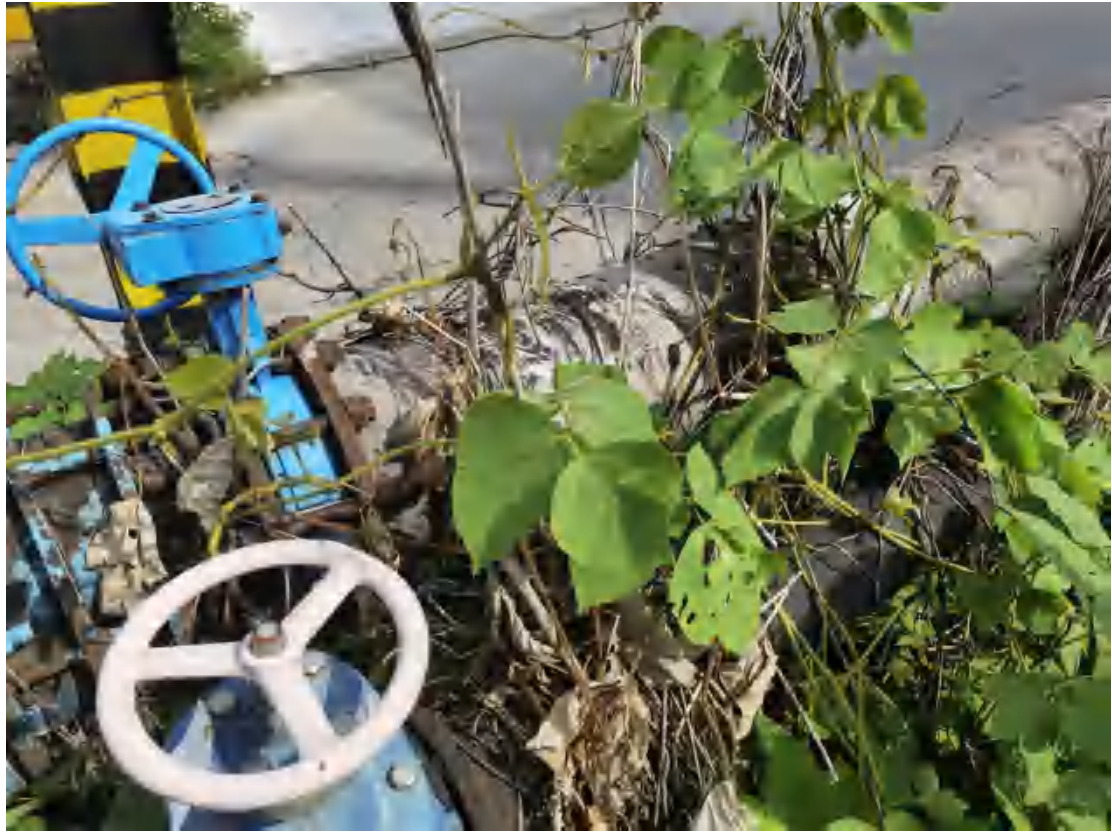
图 67 项目地块内部供水管现状（北-南）
