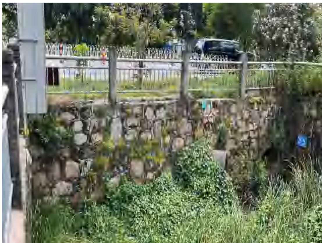
图 29 项目地块内部现状（东南-西北）
