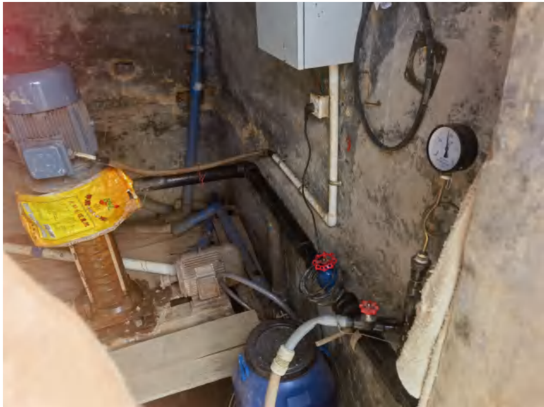
图 65 项目地块内部供水管现状（东北-西南）
