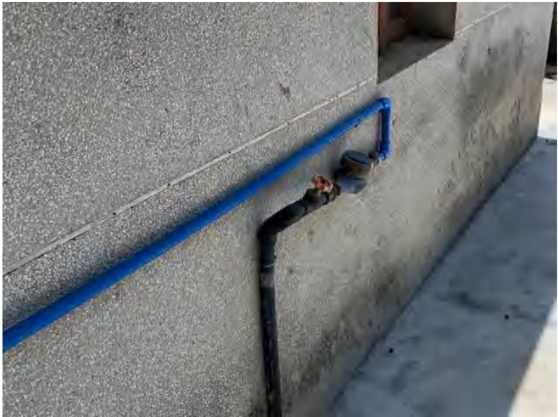
图 52 项目地块内部供水管现状（西北-东南）
