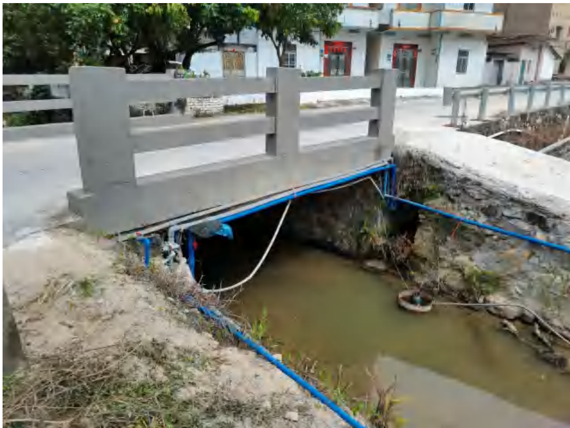
图 62 项目地块内部供水管现状（西-东）
