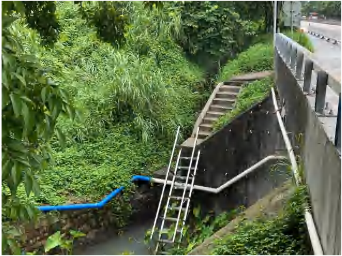
图 55 项目地块内部供水管现状（东-西）
