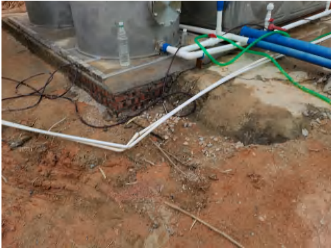
图 63 项目地块内部供水管现状（东北-西南）
