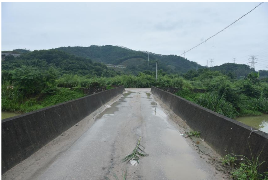
图 27 地块内现状（东南-西北）
