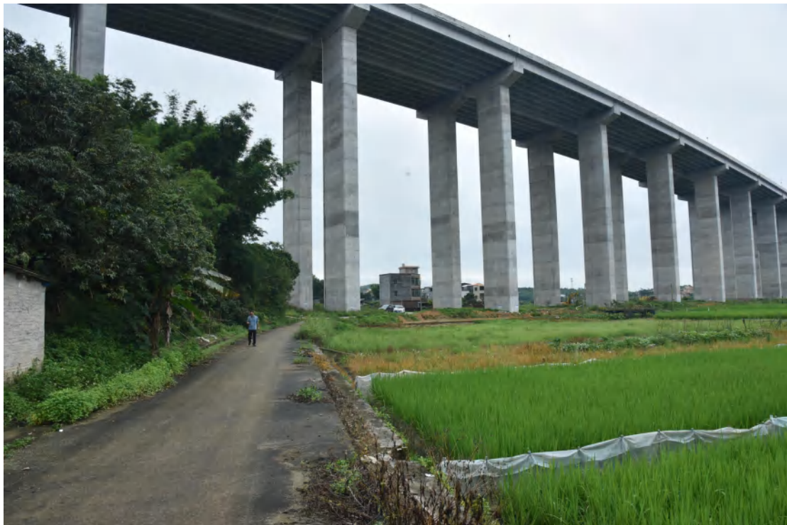
图 32 地块内现状（西-东）
