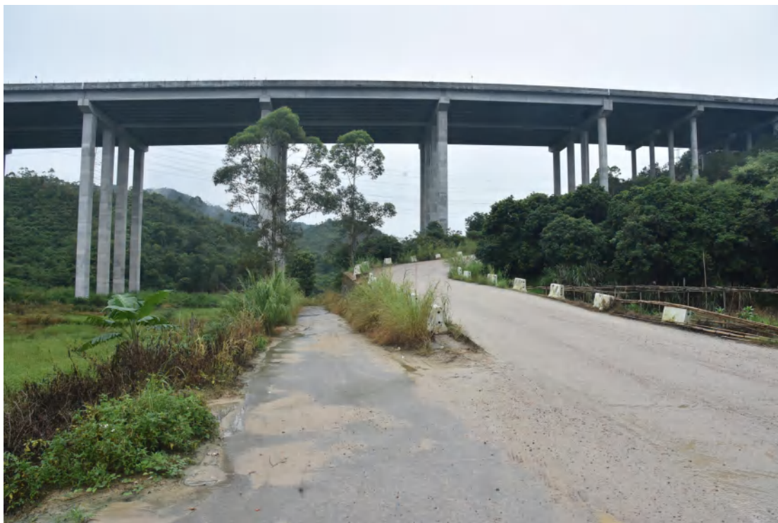
图 28 地块内现状（东-西）
