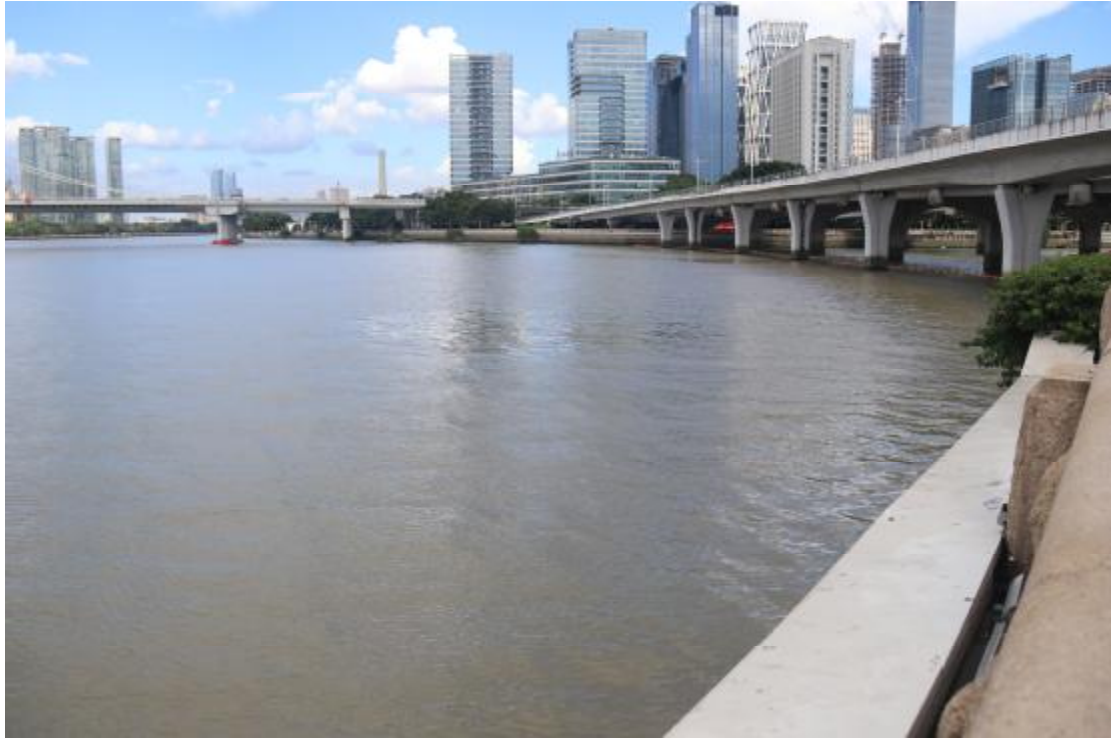
图 10 地块西部现状（西-东）
