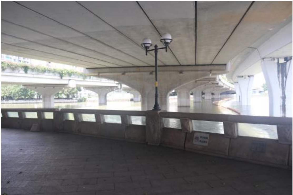
图 9 地块东部现状（东-西）
