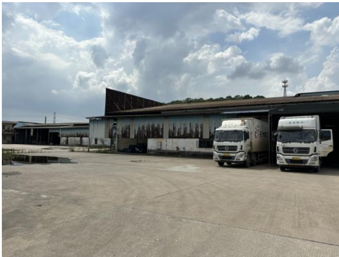
图 9 地块地表现状（南-北）
