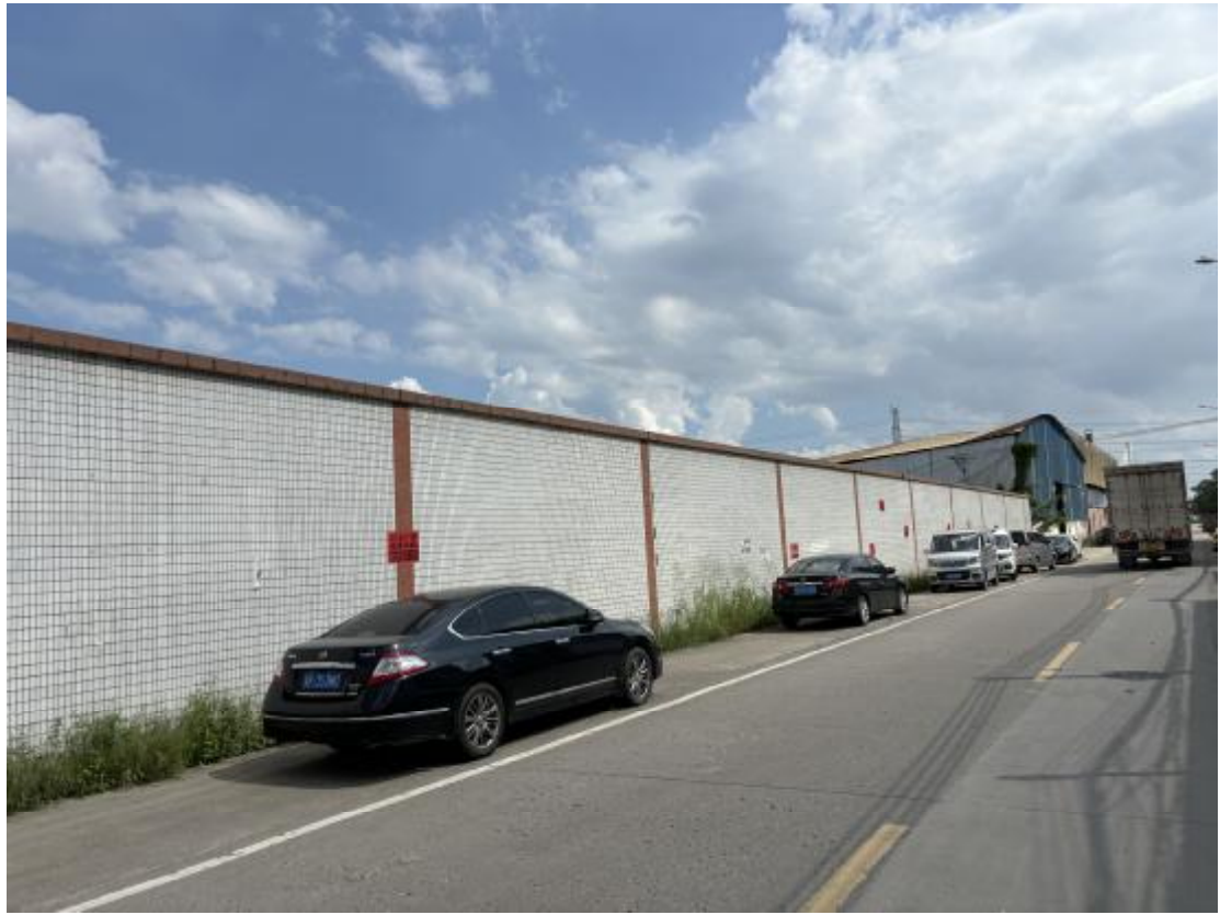
图 21 地块地表现状（南-北）
