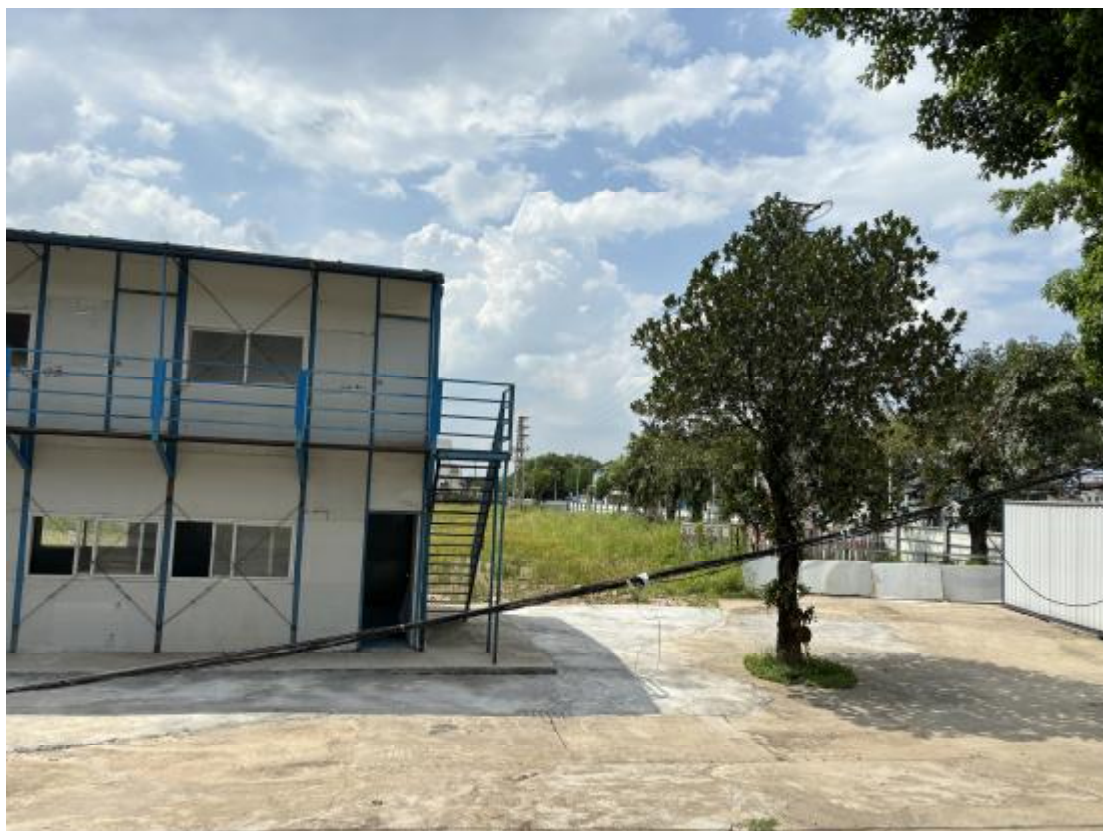
图 12 地块地表现状（南-北）
