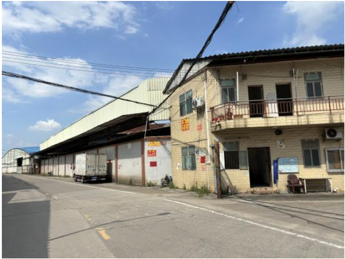
图 23 地块地表现状（西-东）
