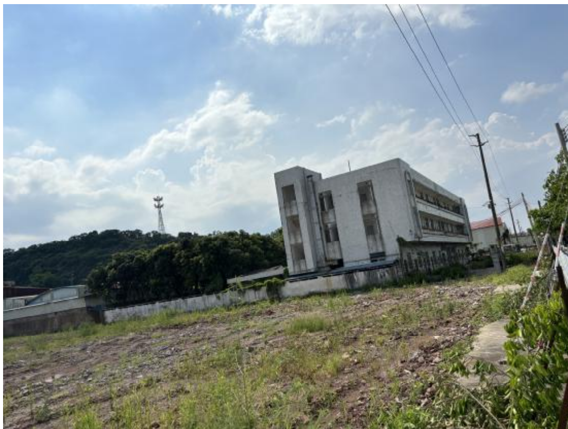
图 30 地块地表现状（南-北）
