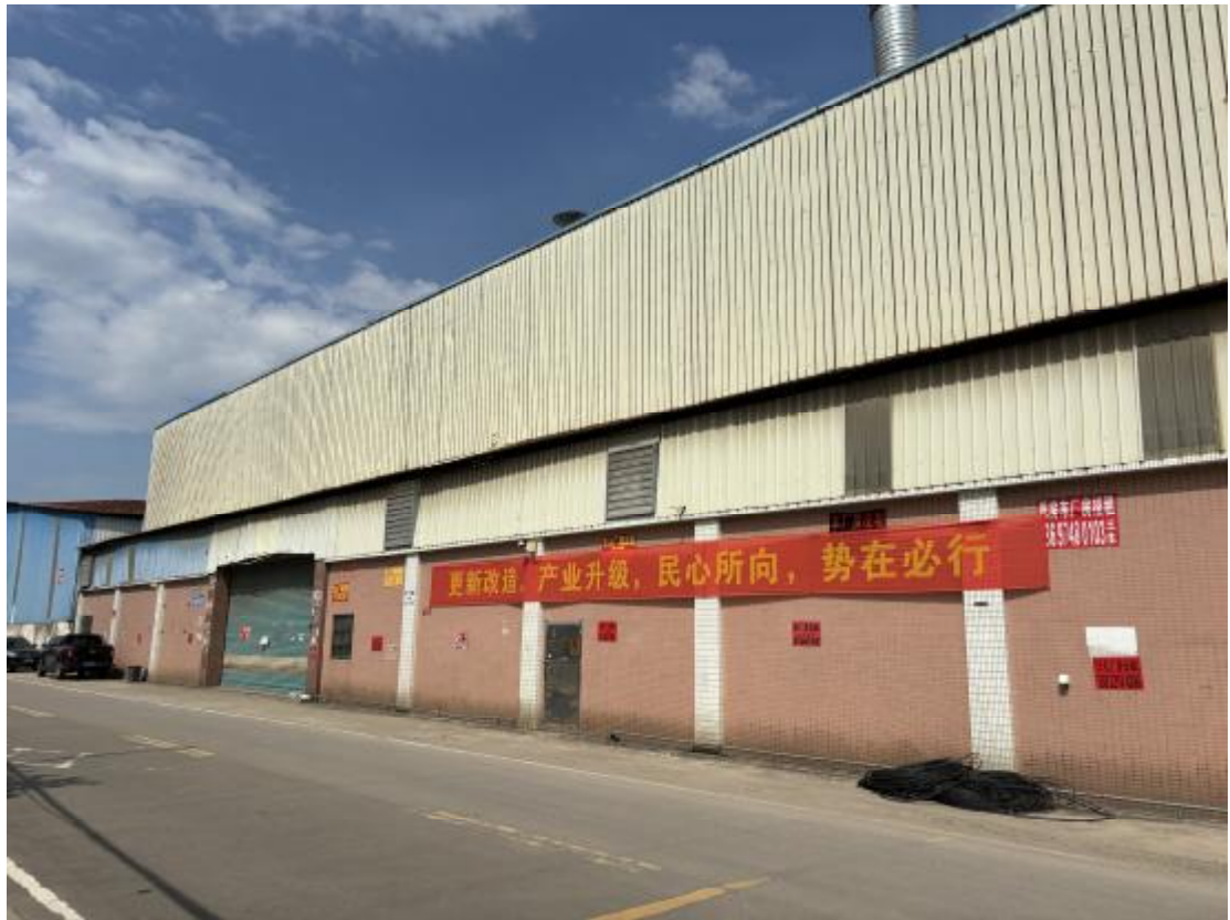
图 22 地块地表现状（西-东）
