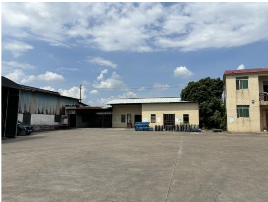
图 10 地块地表现状（西-东）
