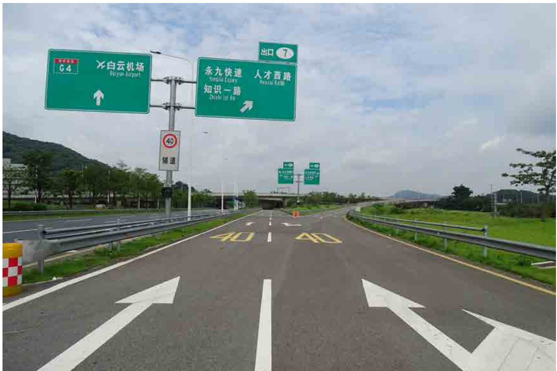
图 22 工程用地北段地表现状（东—西）
