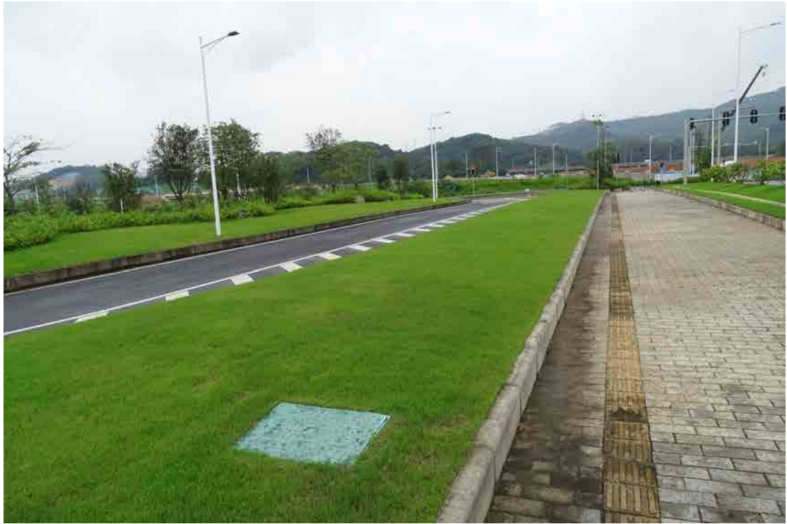
图 17 工程用地北段地表现状（东—西）
