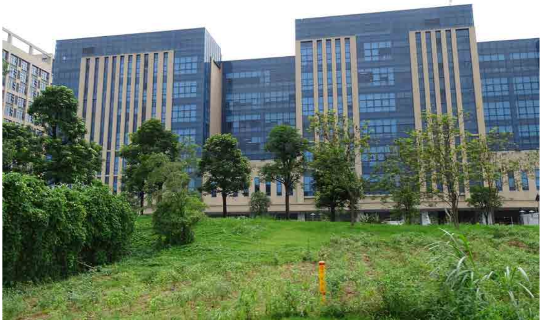
图 20 工程用地北段地表现状（西—东）
