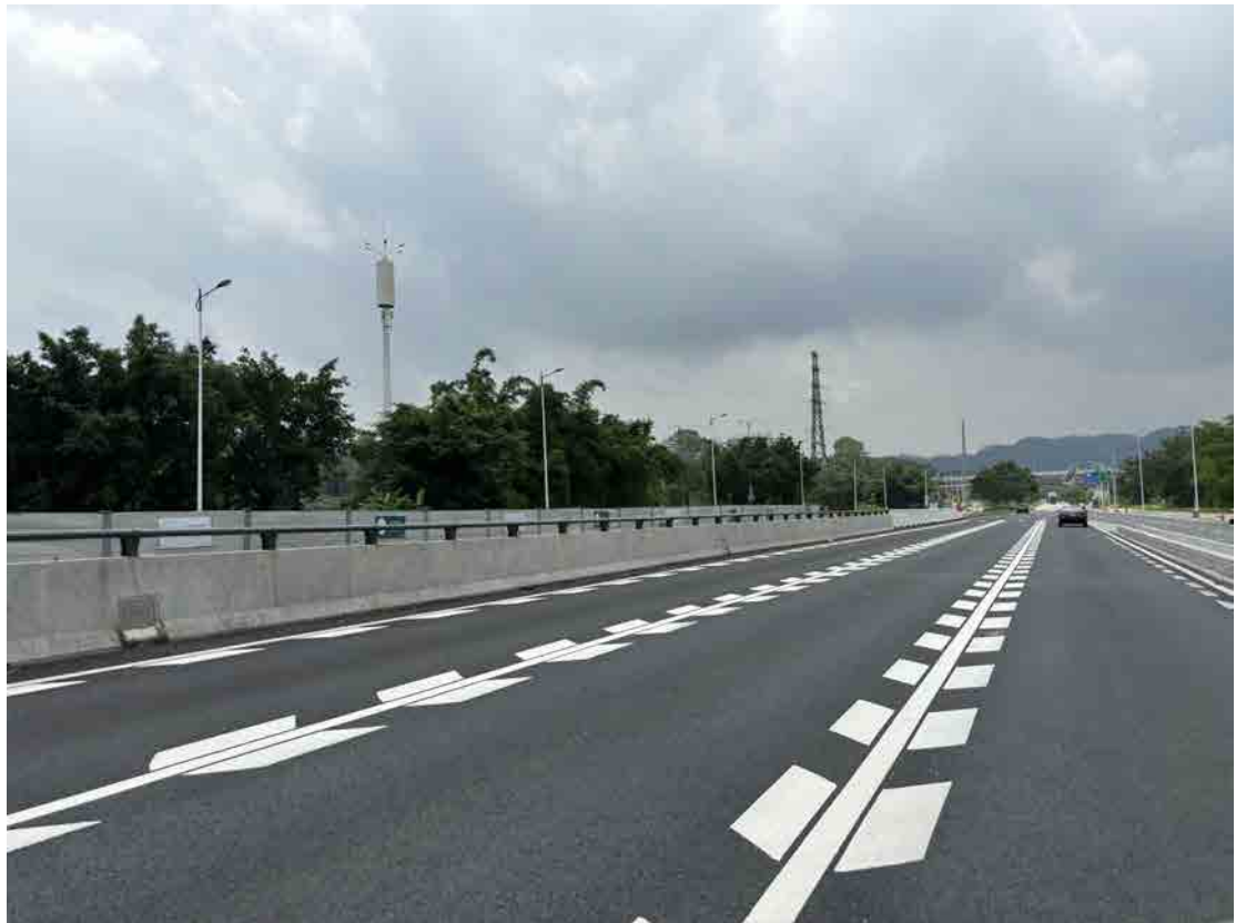
图 48 工程用地南段地表现状（北—南）
