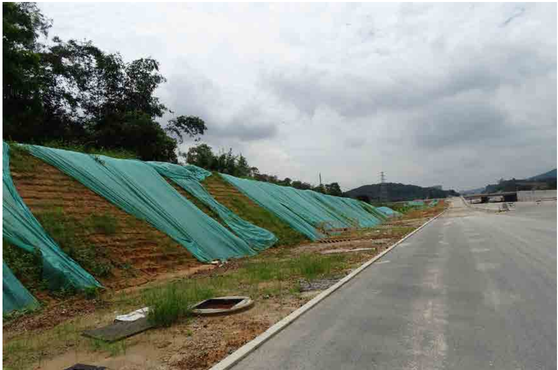
图 30 工程用地北段地表现状（东—西）
