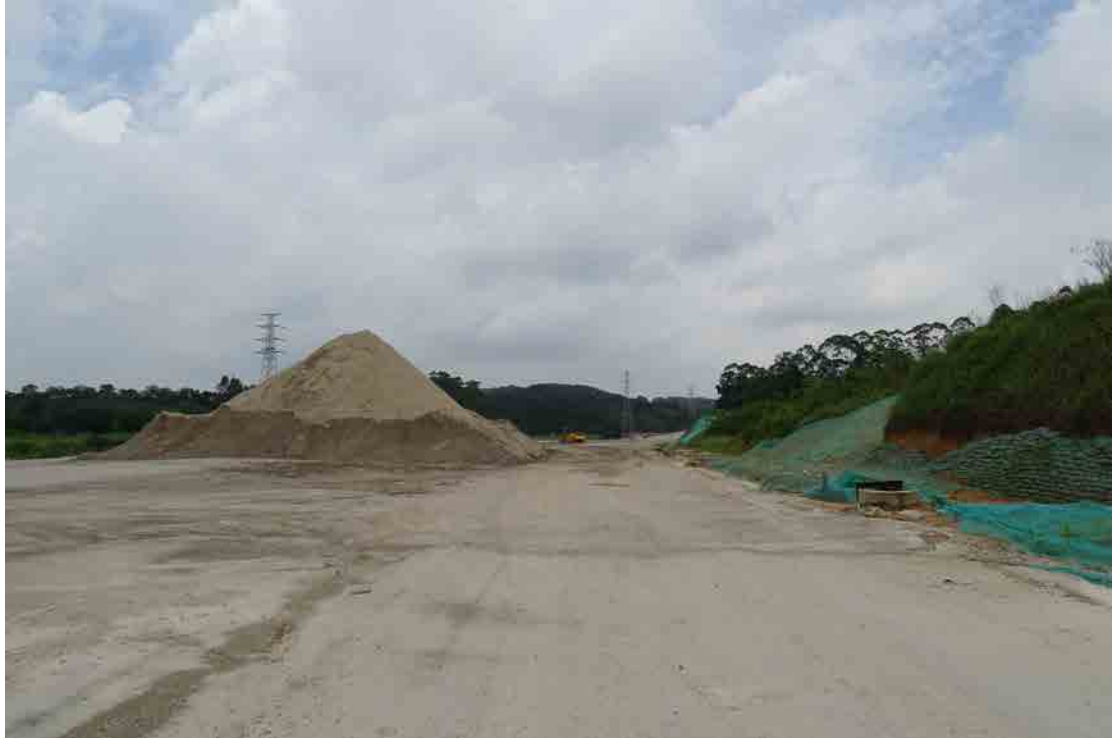
图 29 工程用地北段地表现状（东—西）
