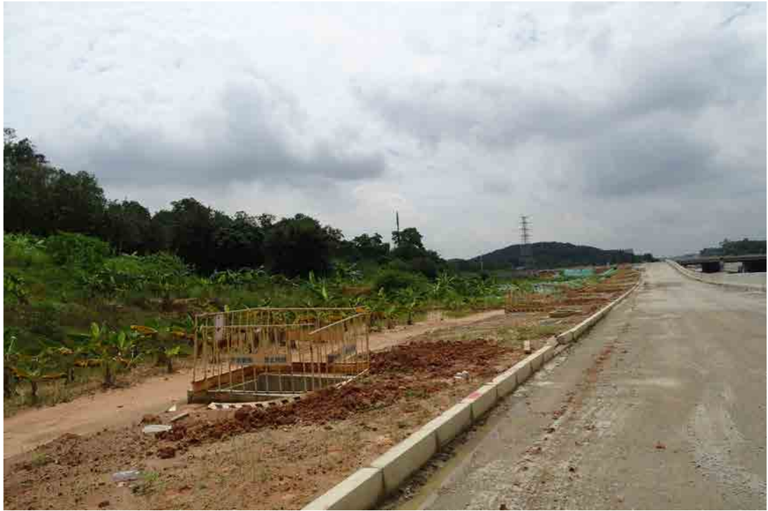
图 31 工程用地北段地表现状（东—西）
