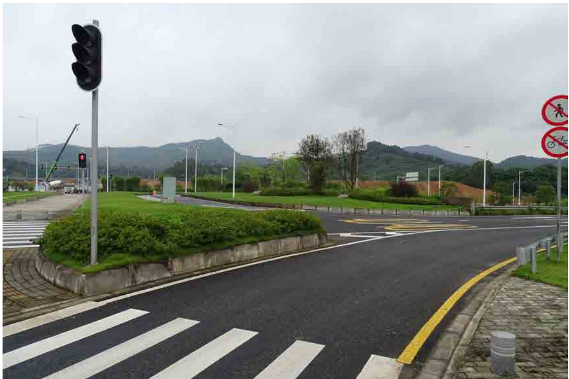
图 16 工程用地北段地表现状（东—西）
