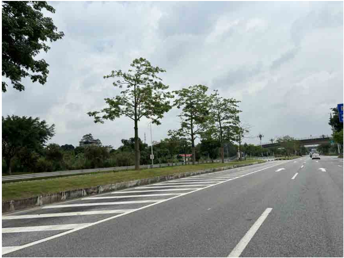
图 49 工程用地南段地表现状（北—南）
