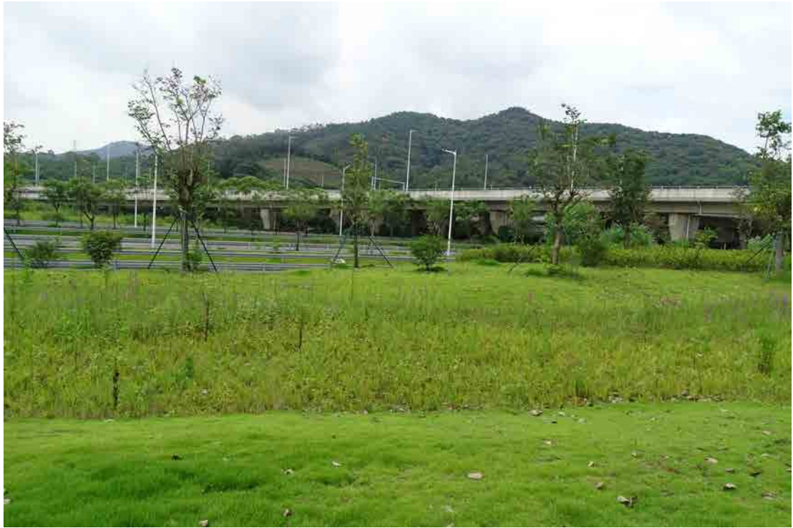
图 27 工程用地北段地表现状（东—西）
