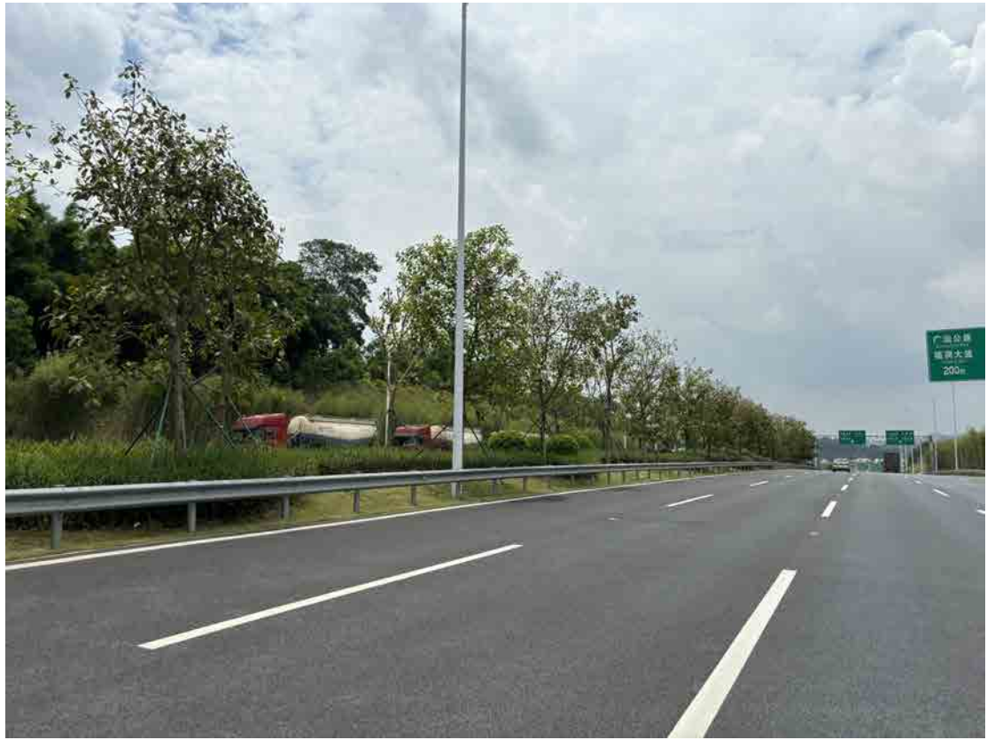
图 47 工程用地南段地表现状（西—东）
