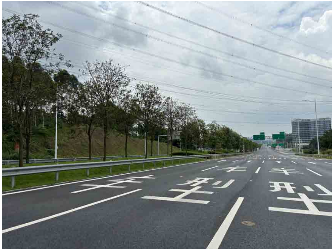
图 46 工程用地南段地表现状（北—南）
