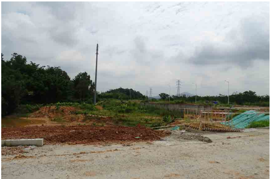
图 32 工程用地北段地表现状（西—东）
