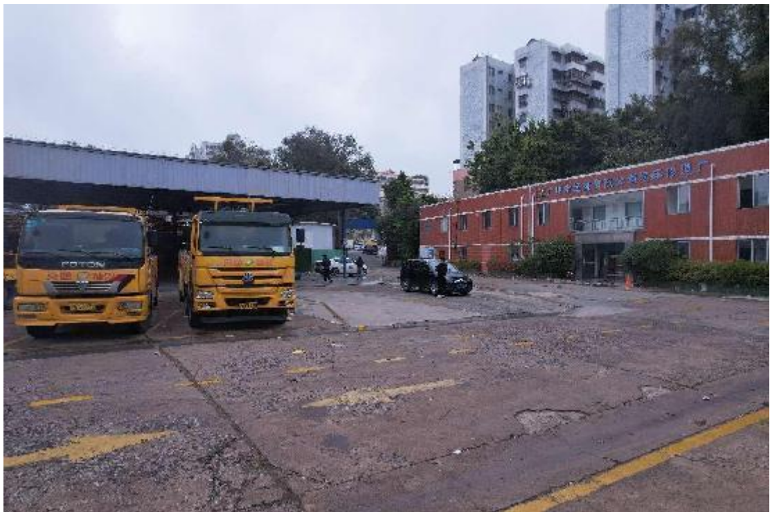
图 16 地块内现状（北-南）
