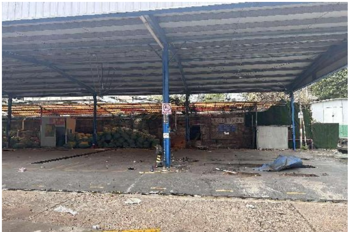
图 17 地块内现状（西北-东南）
