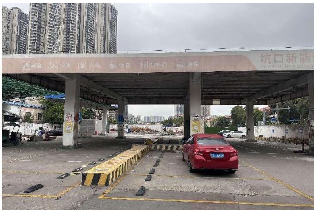
图 11 地块内现状（西-东）
