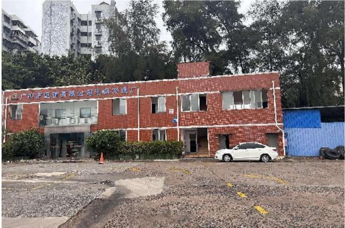
图 21 地块内现状（东-西）
