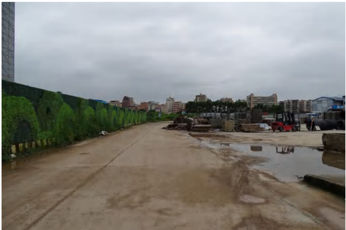
图 24 南部道路地表现状（北-南）
