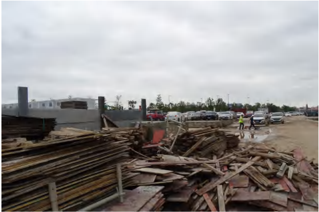
图 35 南部道路地表现状（南-北）
