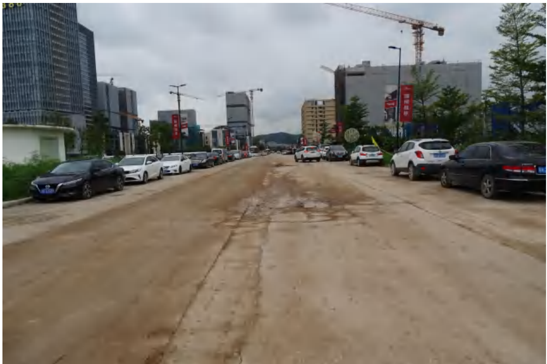
图 22 南部道路地表现状（西-东）
