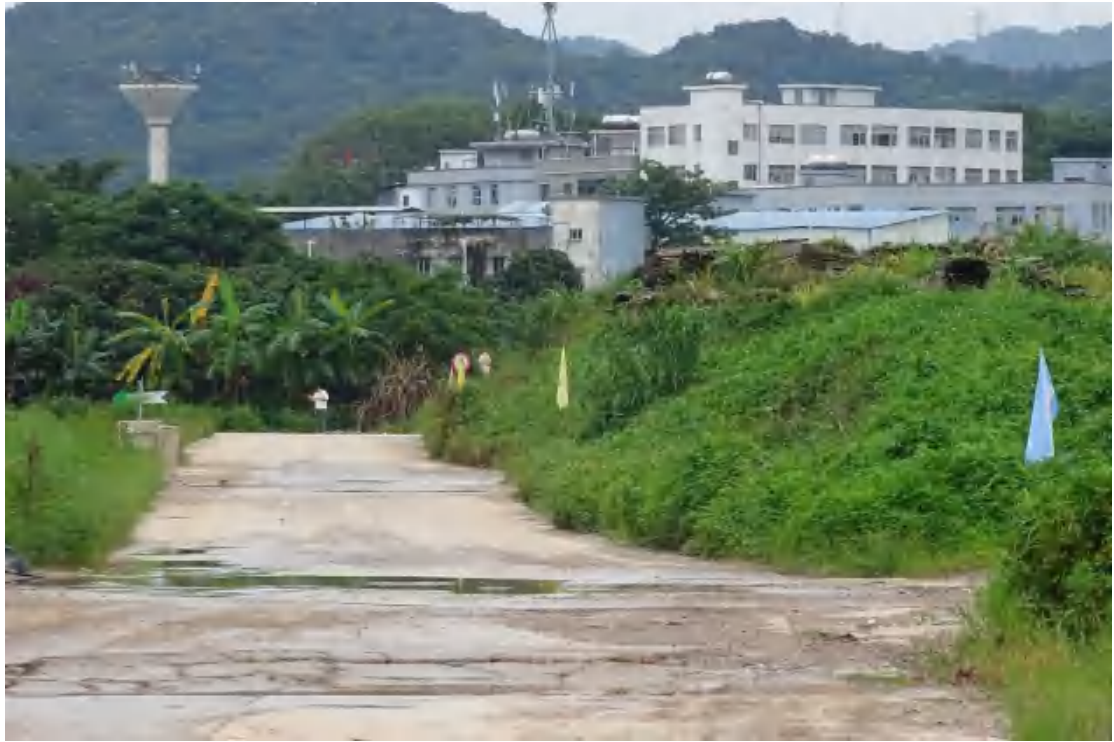
图 31 南部道路地表现状（西-东）
