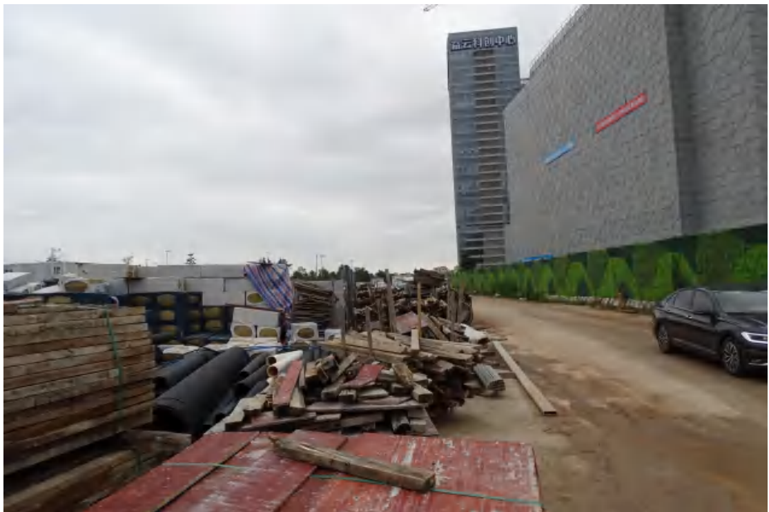
图 34 南部道路地表现状（南-北）
