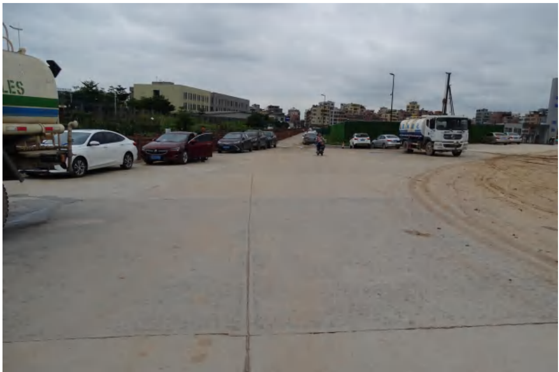
图 14 北部道路地表现状（北-南）
