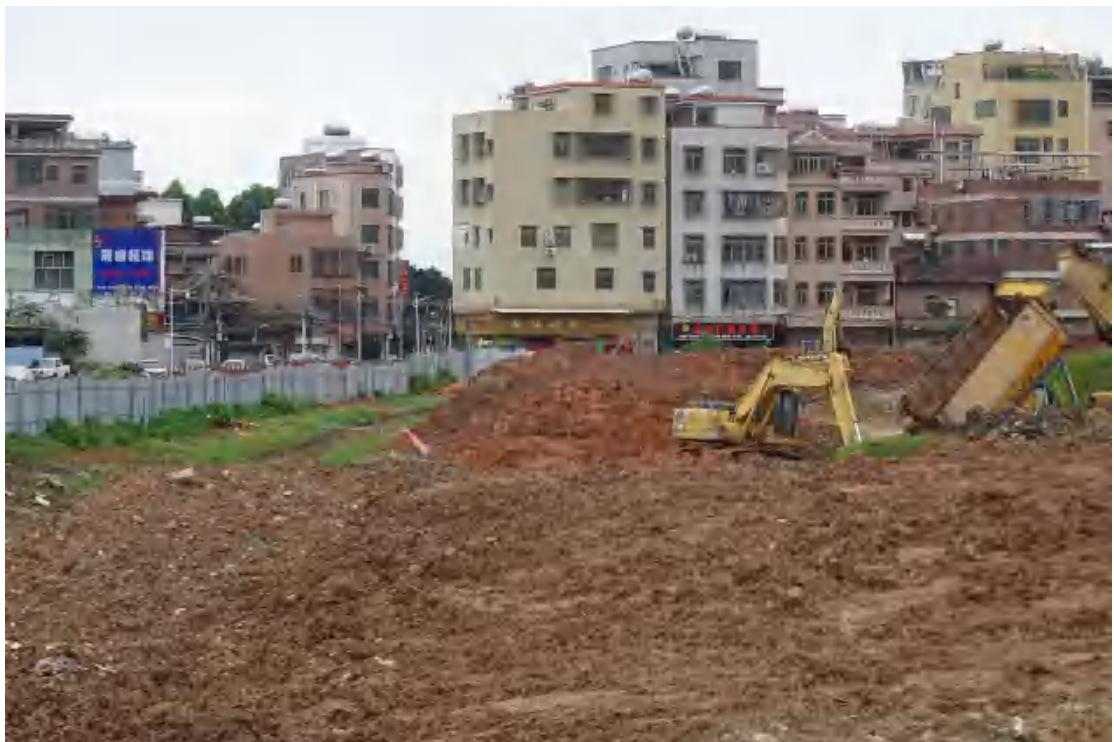
图 18 北部道路地表现状（南-北）
