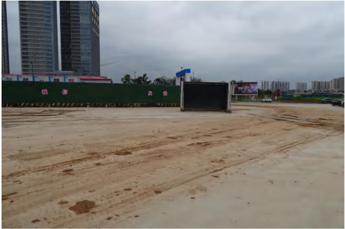
图 17 北部道路地表现状（北-南）
