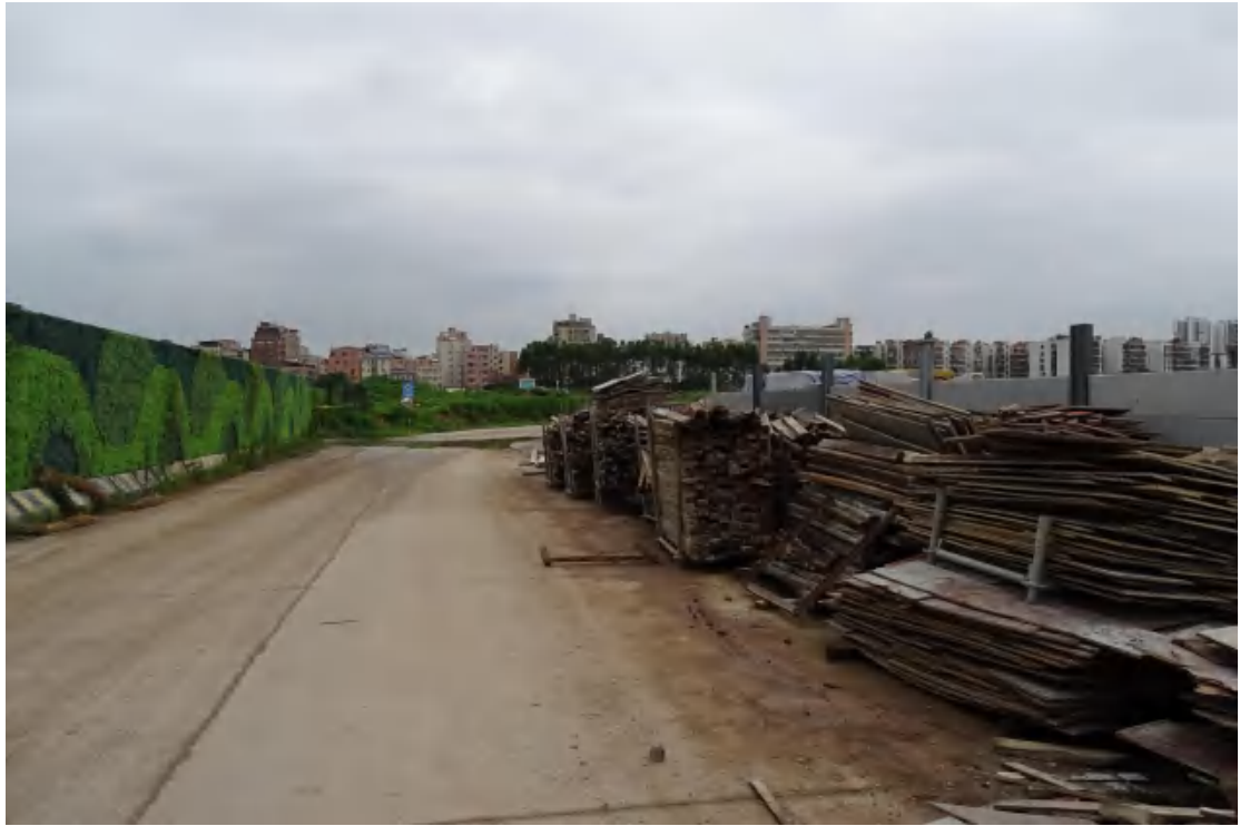
图 25 南部道路地表现状（北-南）
