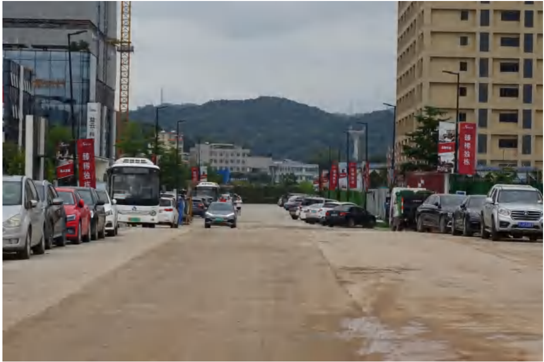
图 21 南部道路地表现状（西-东）
