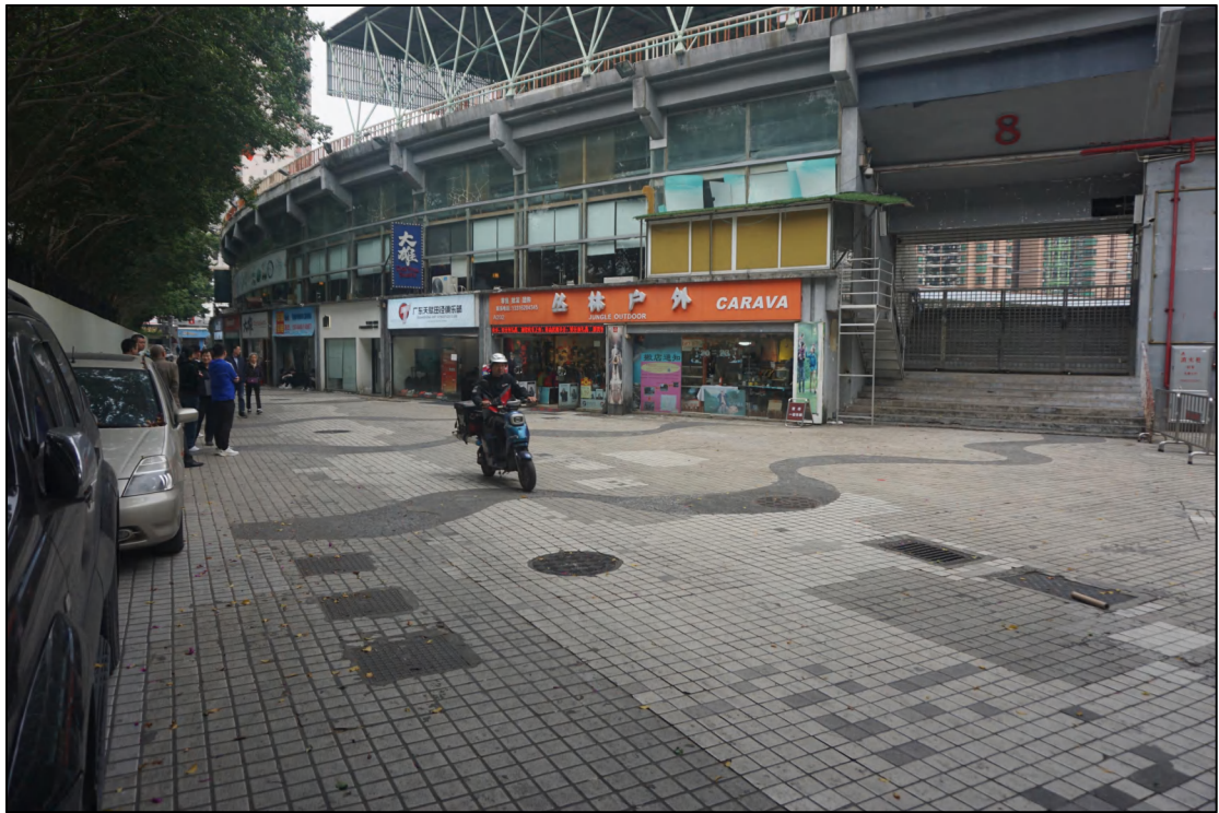
图 23 地块西部现状（西-东）
