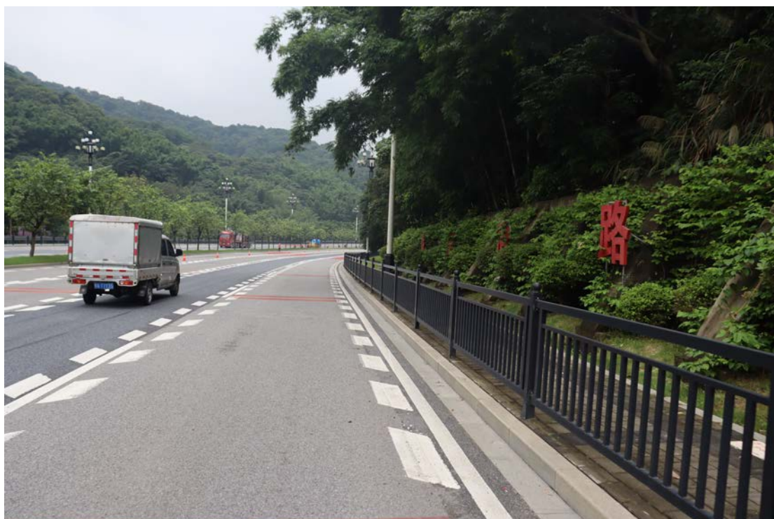
图 20 线路中部现状（东北-西南）
