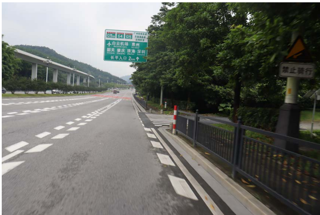
图 22 线路中部现状（西北-东南）
