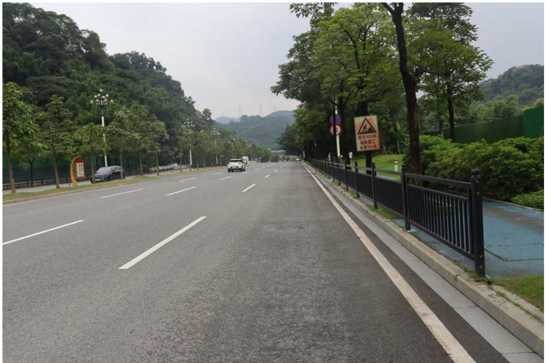
图 27 线路中东部现状（东北-西南）
