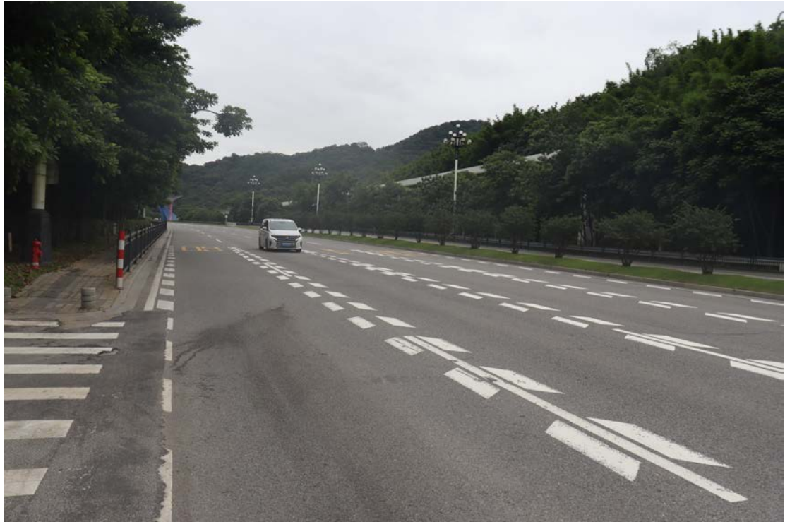
图 26 线路中部现状（北-南）
