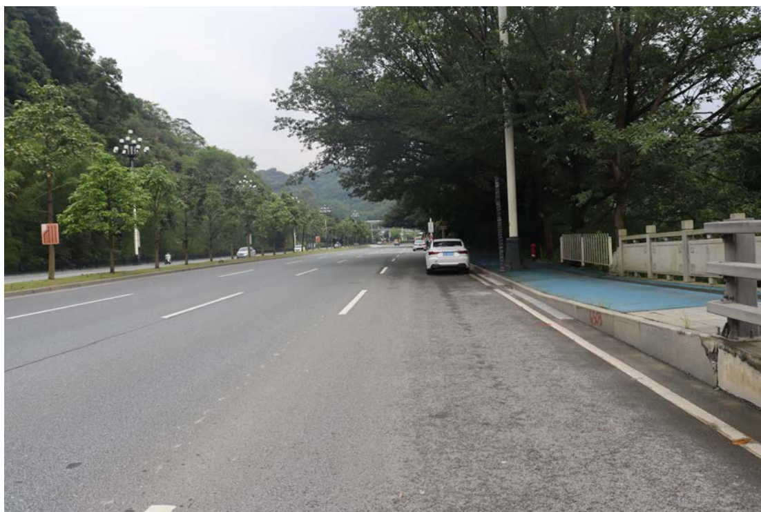
图 28 线路中东部现状（东北-西南）
