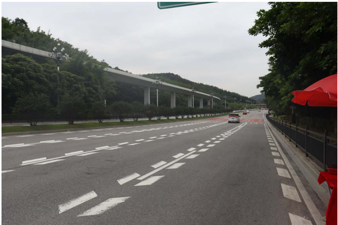
图 25 线路中部现状（西南-东北）
