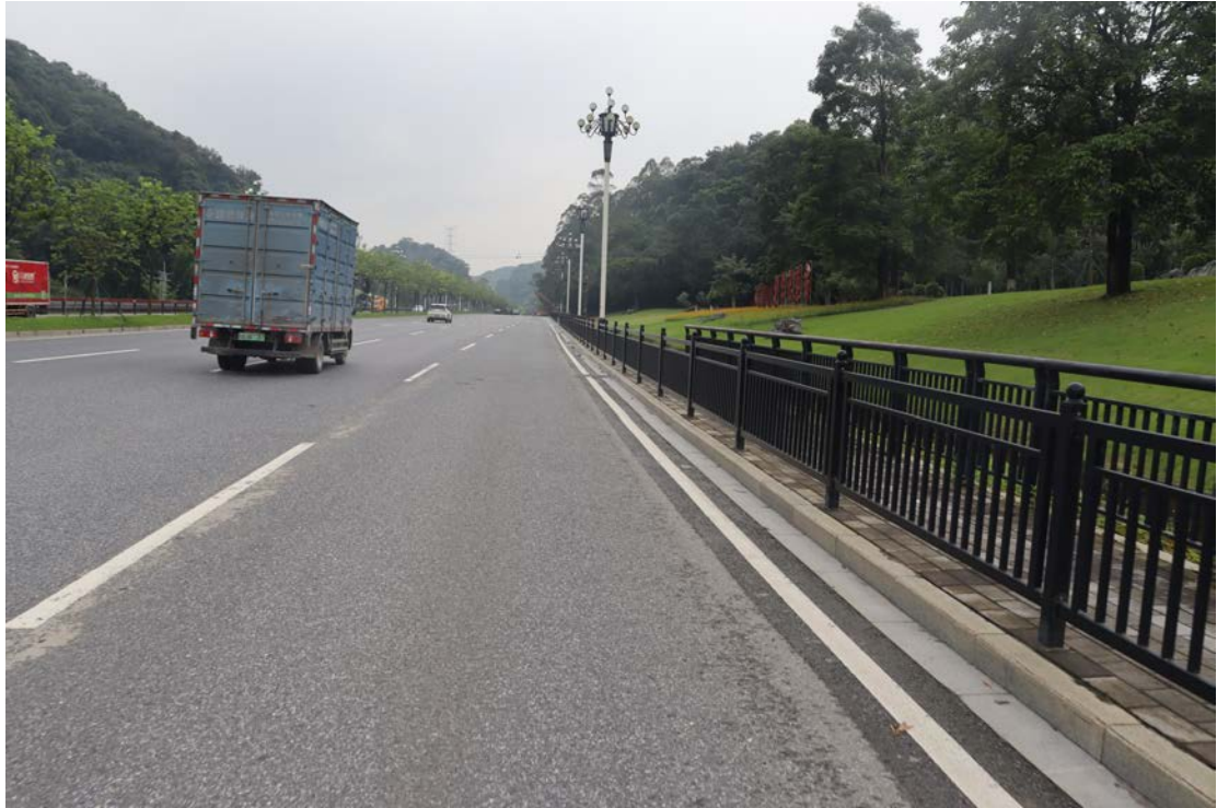
图 16 线路中部现状（东北-西南）
