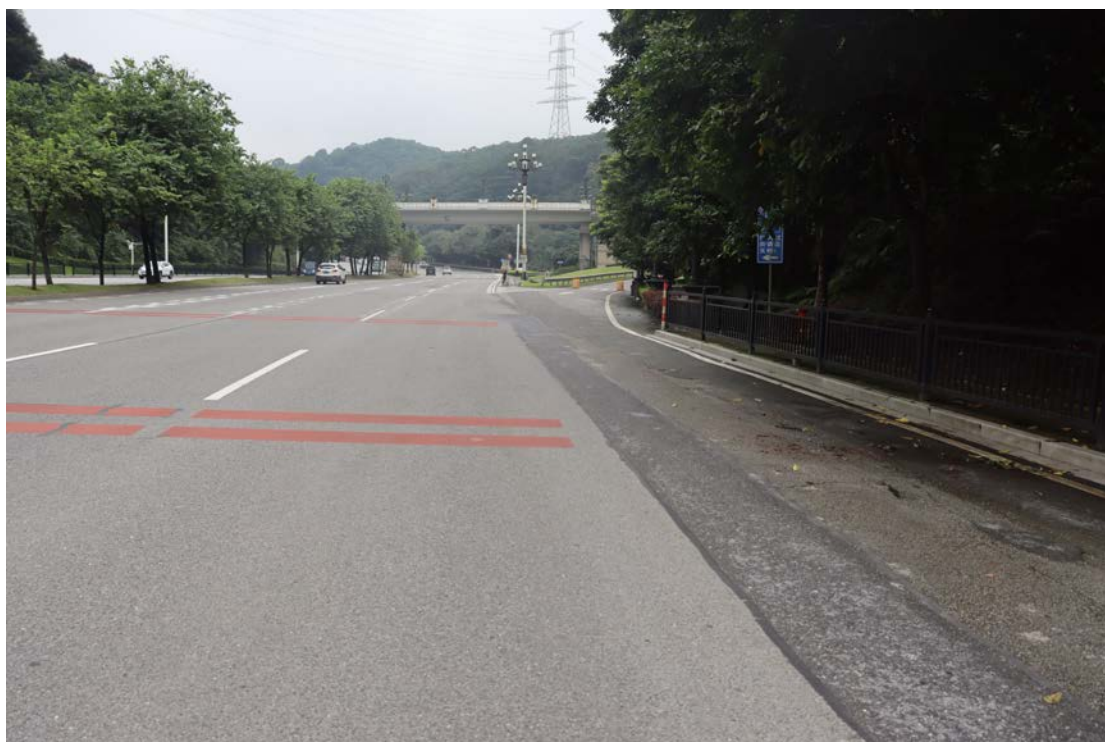
图 18 线路中部现状（东北-西南）
