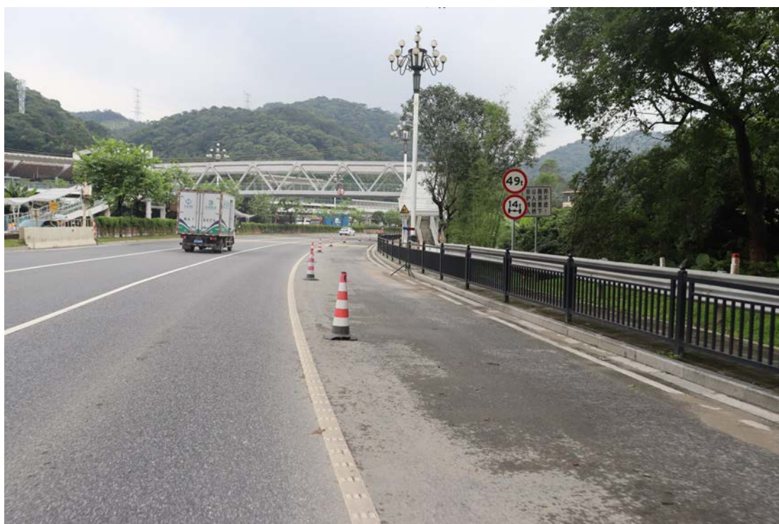
图 23 线路中部现状（西北-东南）
