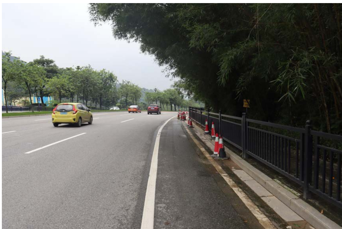
图 21 线路中部现状（东北-西南）
