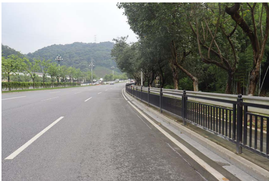
图 15 线路中部现状（东北-西南）
