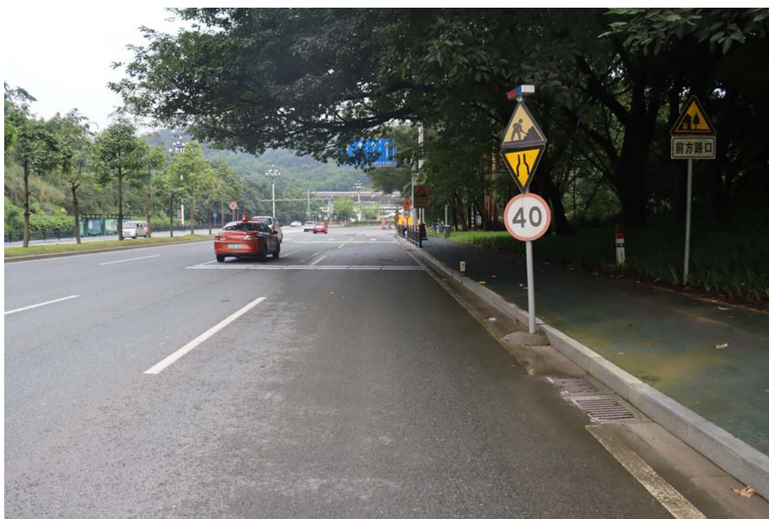
图 29 线路中东部现状（东北-西南）
