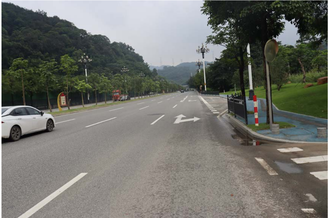
图 32 线路中东部现状（东北-西南）
