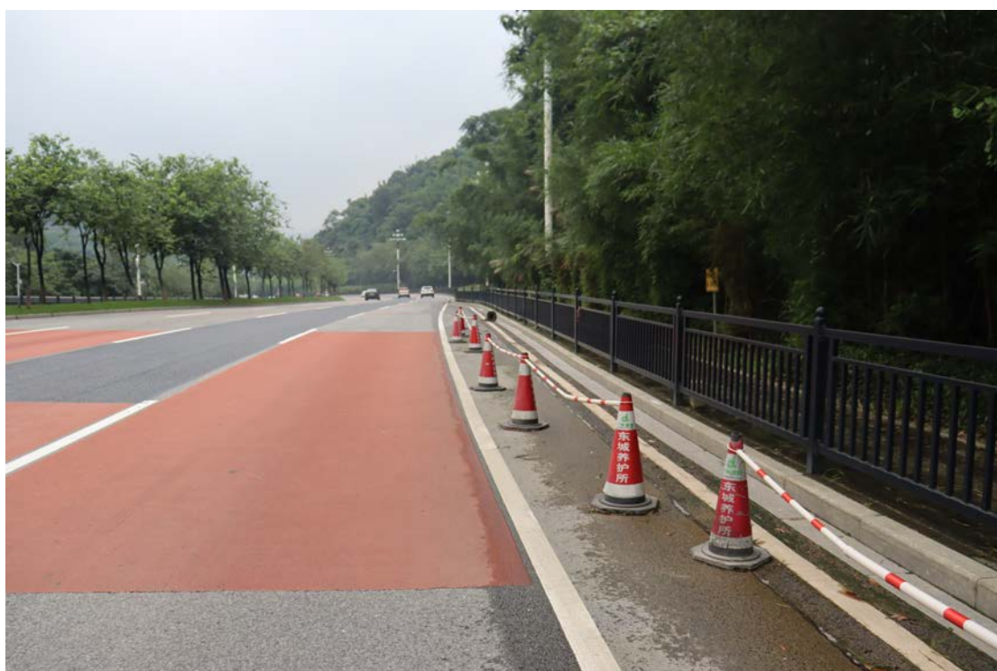
图 19 线路中部现状（东北-西南）
