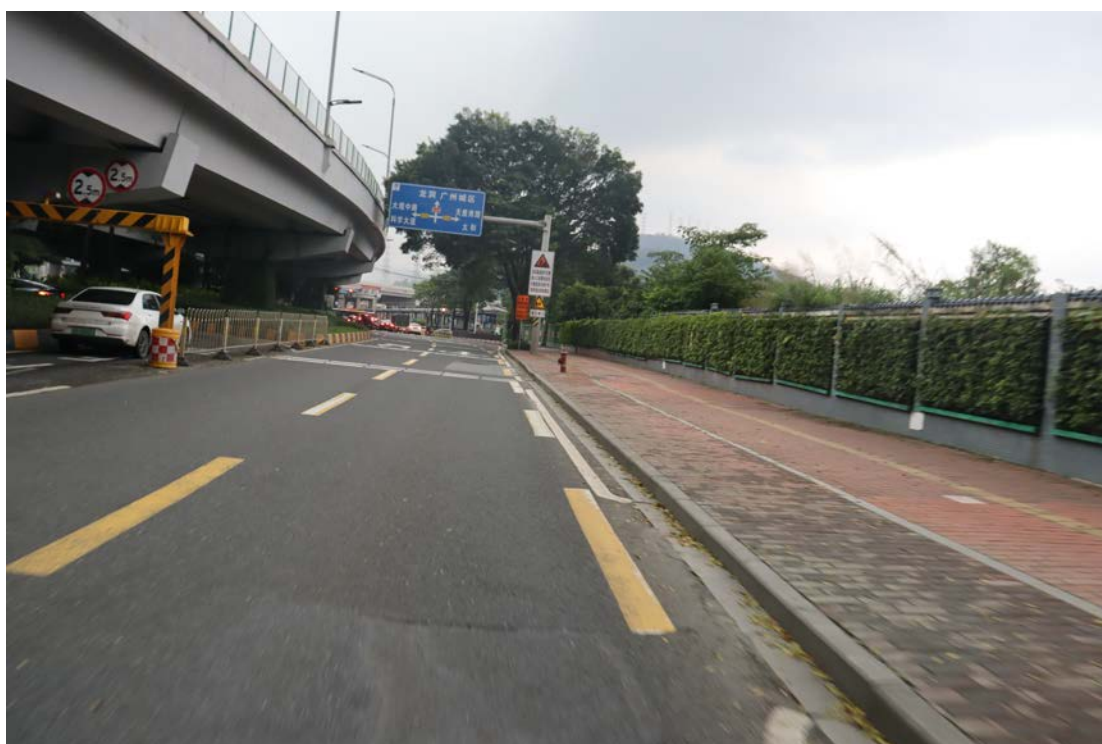
图 13 线路西部现状（东南-西北）
