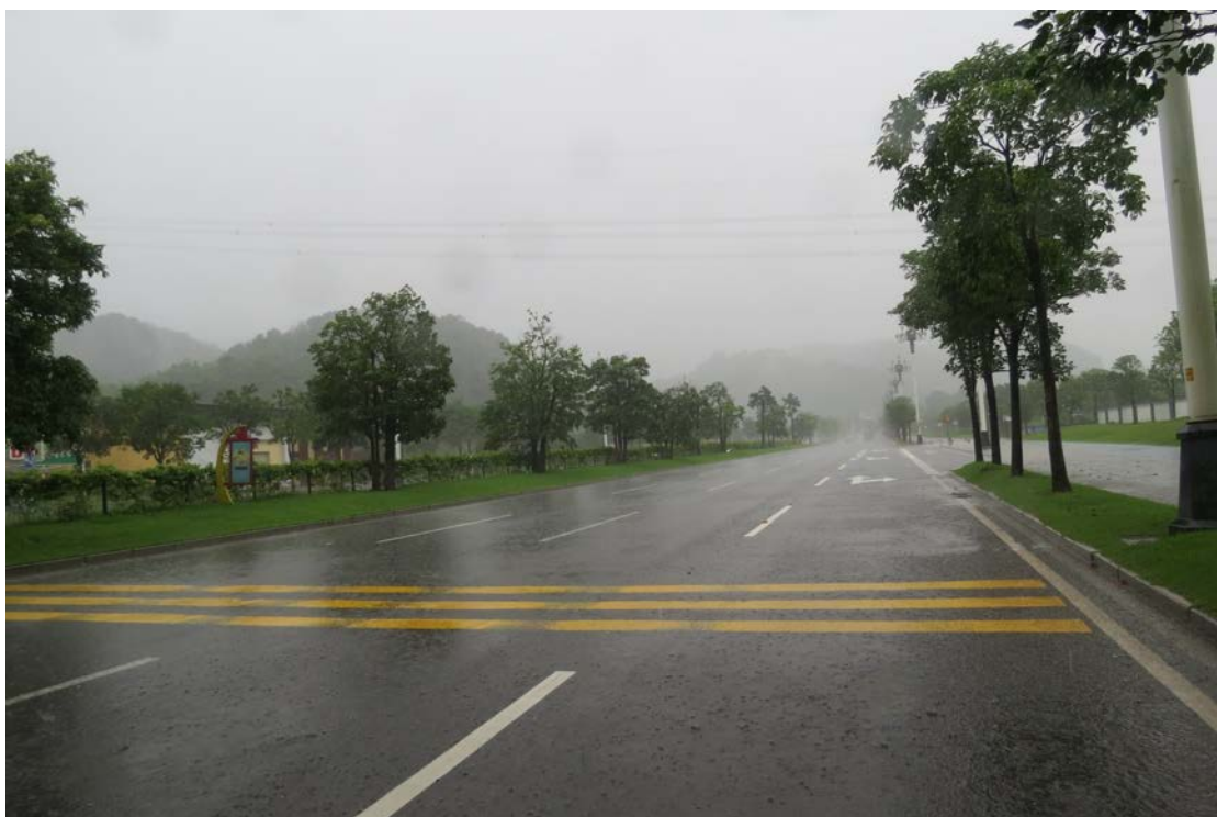
图 35 线路中东部现状（东北-西南）
