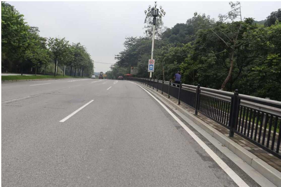
图 17 线路中部现状（东北-西南）
