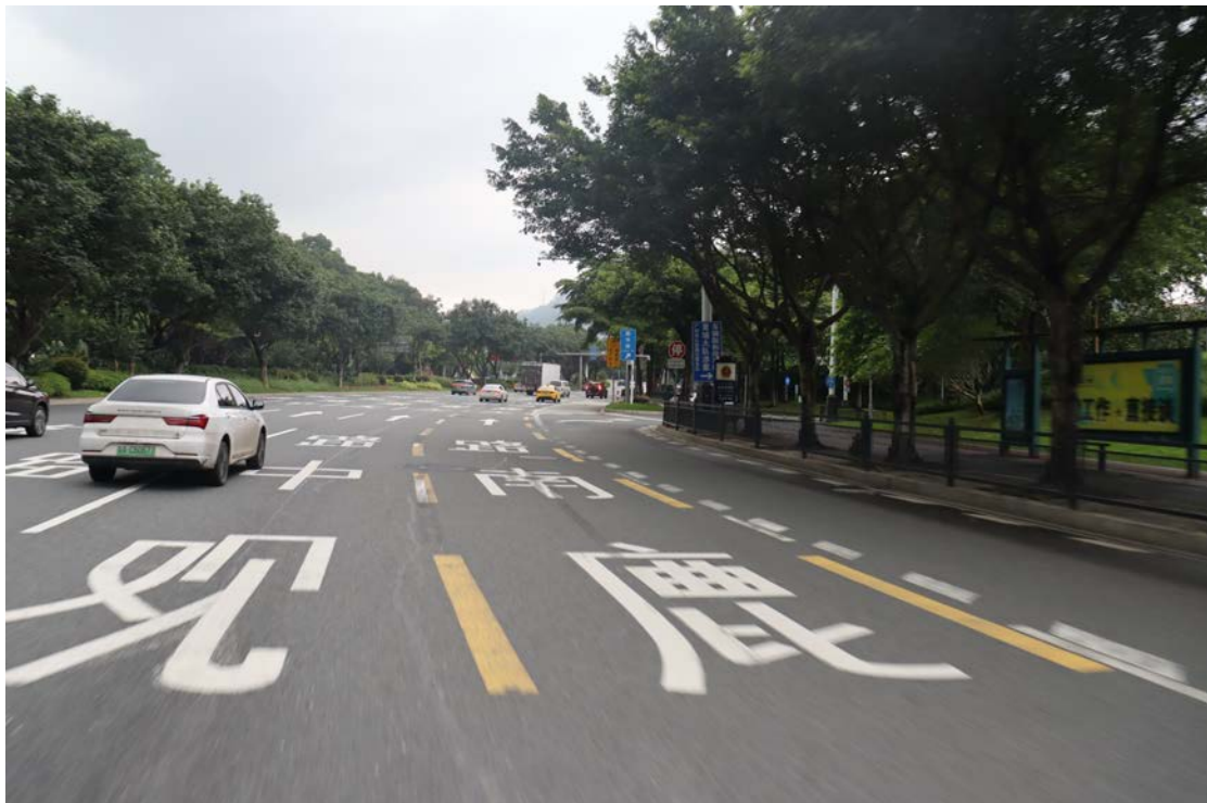
图 11 线路西部现状（东南-西北）
