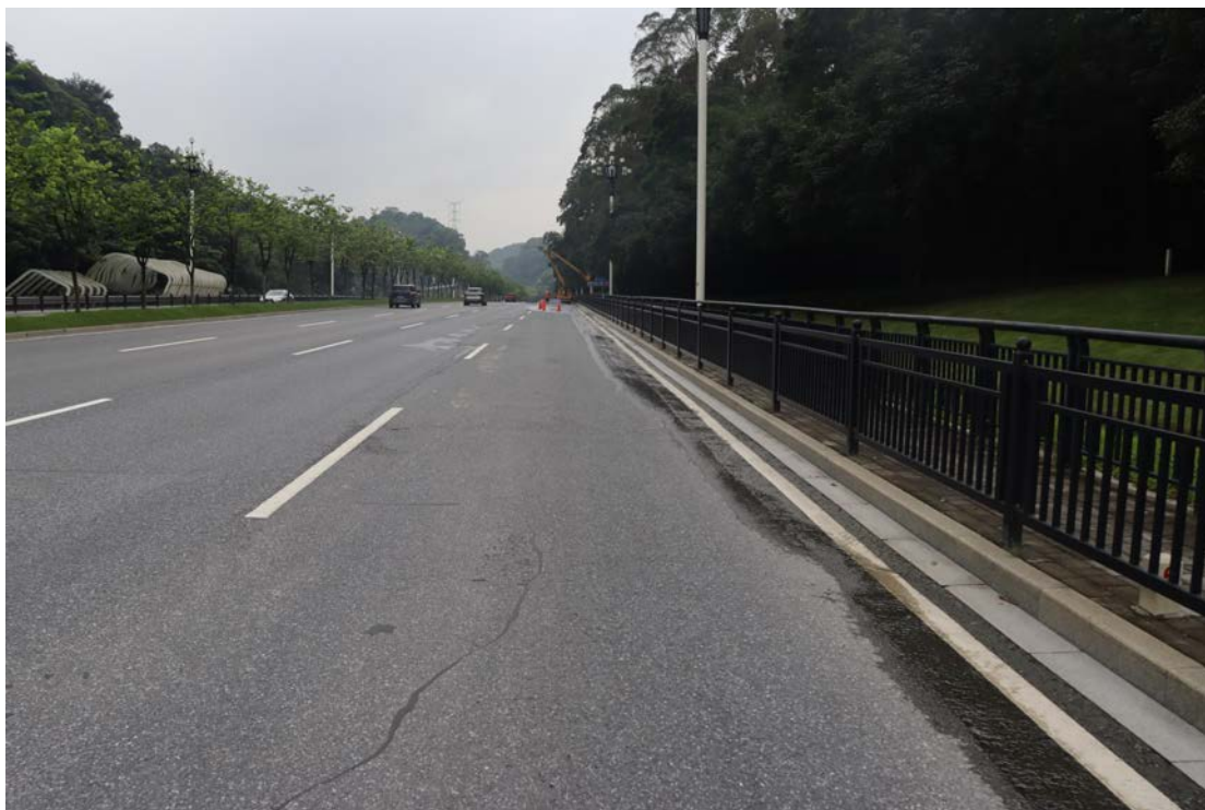
图 30 线路中东部现状（东北-西南）
