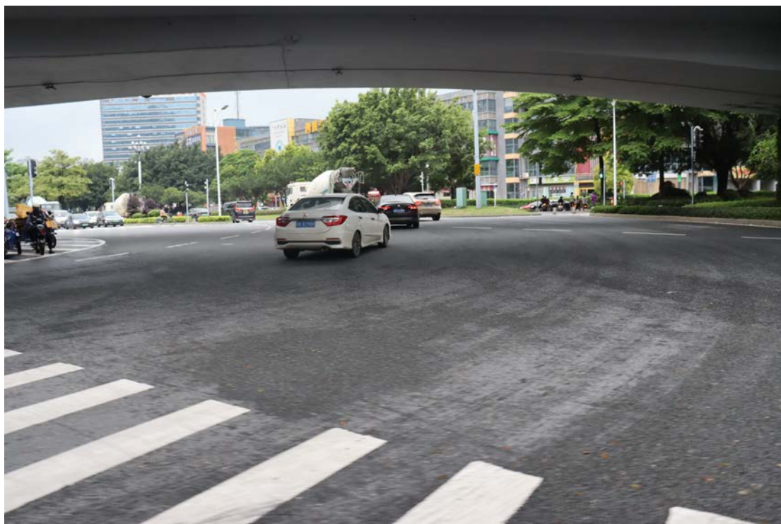
图 14 线路西部现状（西北-东南）
